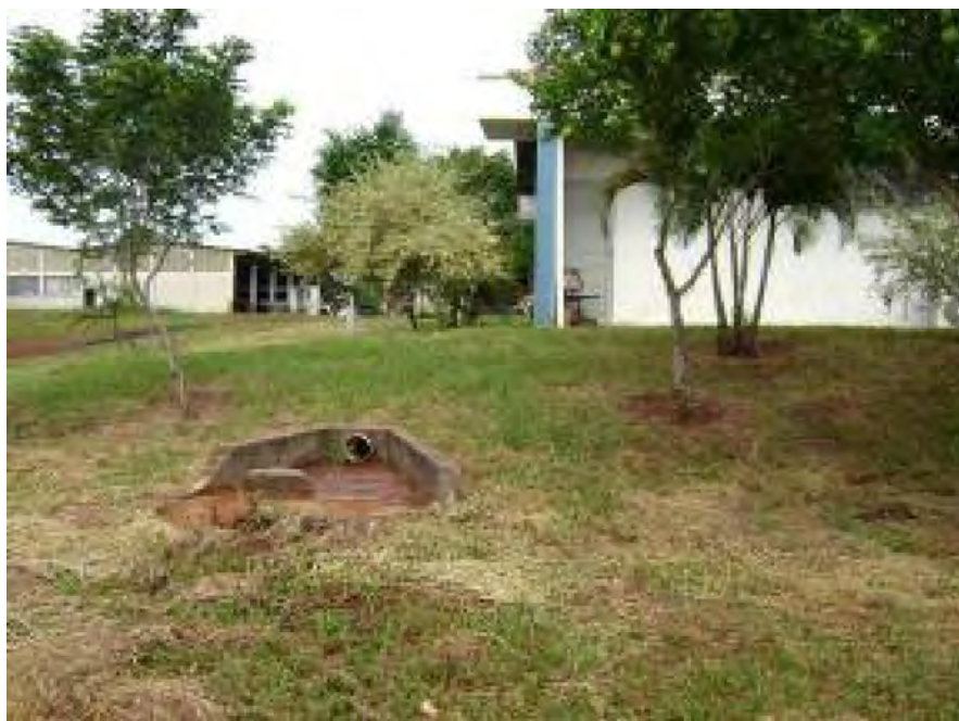
Figura 5A: Terreno antes da escavação (15.02.08)
