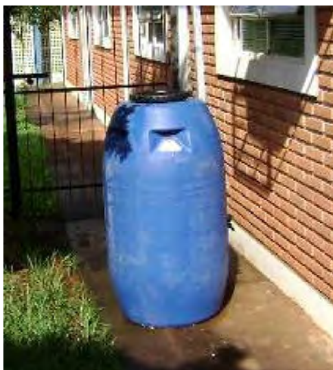
Figura 8: Fotografia de um dos reservatórios utilizados como reservatório de descarte
