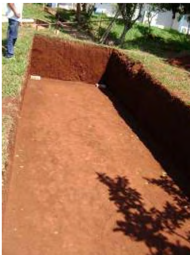
Figura 5B: Terreno após escavação (07.03.08)
