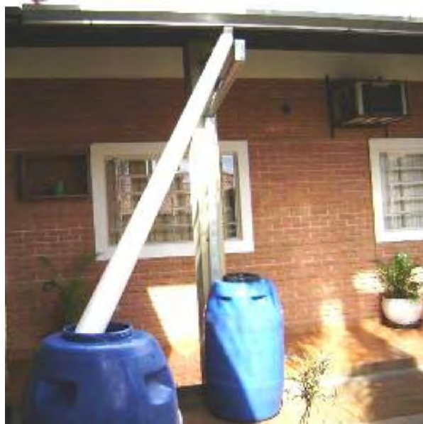
Figura 10: Coleta de água de chuva nos reservatórios de descarte (10/03/08)
