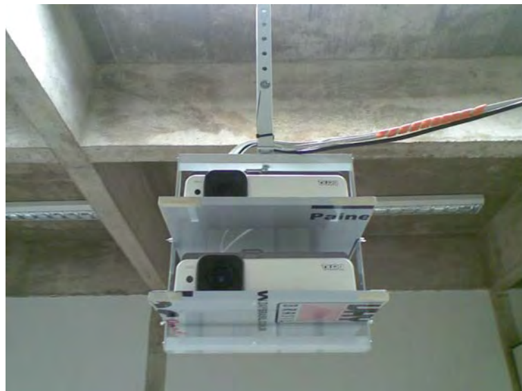
Figura 18: Suporte utilizado para o posicionamento correto dos projetores e lentes polarizadas
