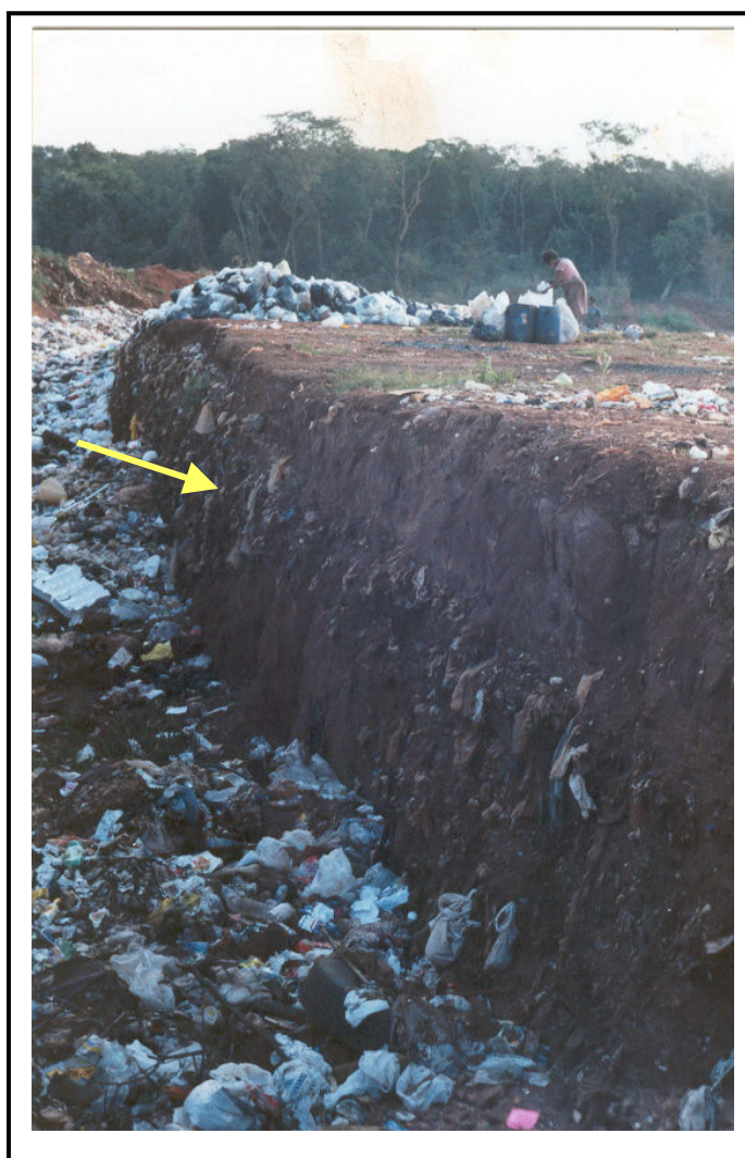
Figura 07 - Vala aberta em área que já foi utilizada anteriormente
