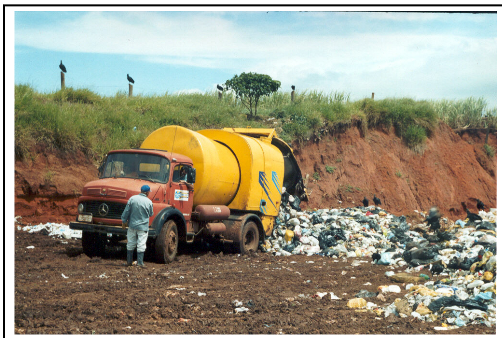
Figura 08 - Caminhão descarregando lixo no aterro em valas
