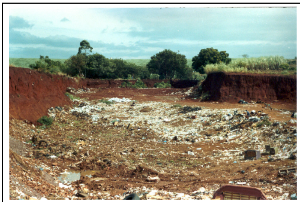
Figura 13 - Área inadequada de disposição final de lixo em Igarçu do Tietê
