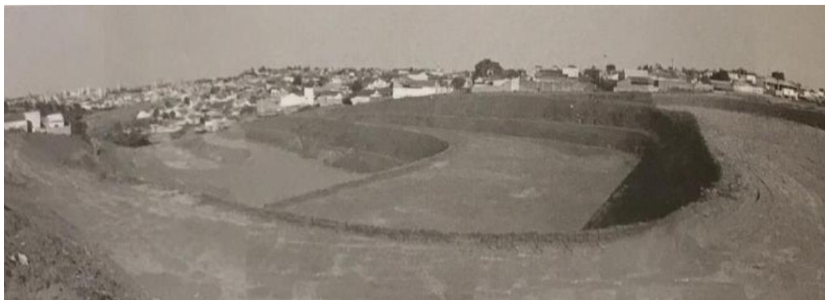
Figura 7 - Voçoroca após retaludamento e drenagem superficial.
