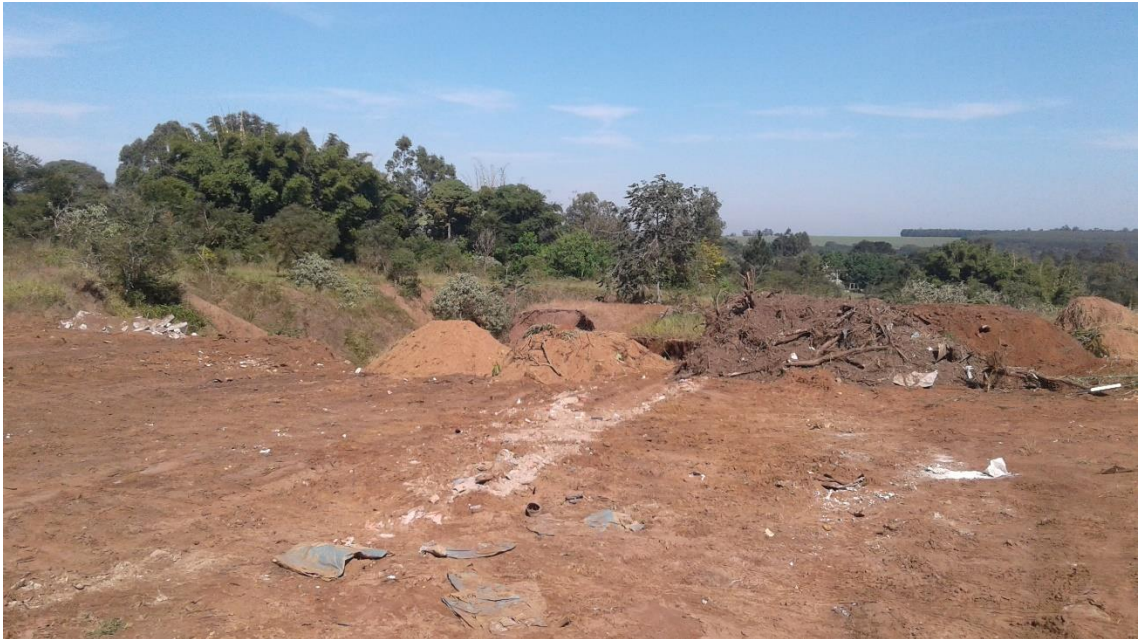
Figura 38 - Depósito de resíduos de construção civil e poda na cabeceira da Feição 1.
