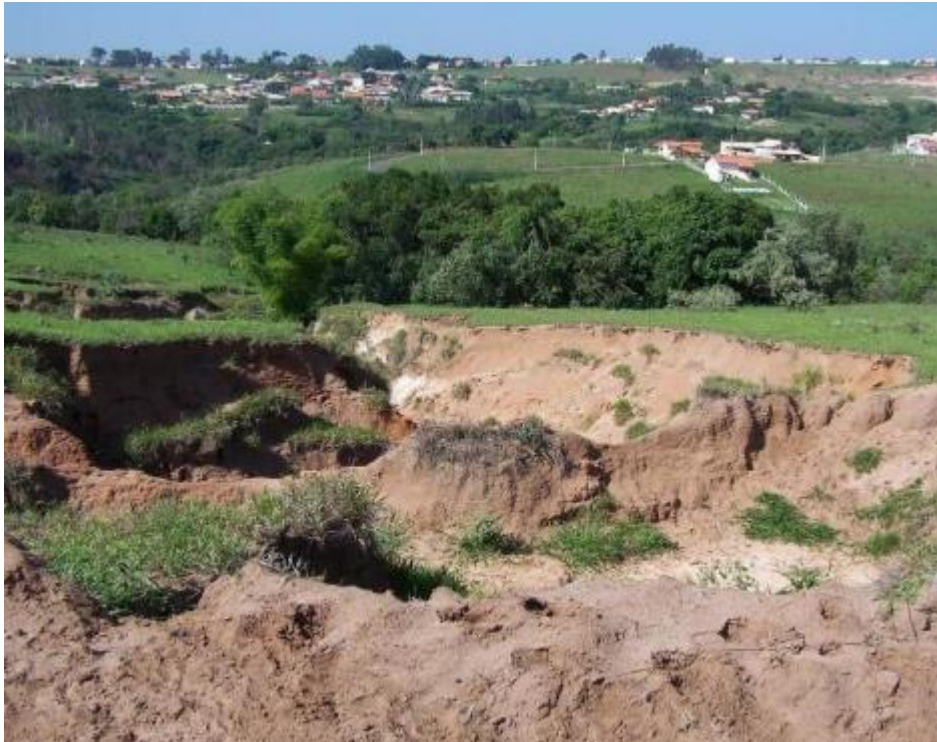
Figura 4 - Voçoroca localizada na Bacia do Córrego do Espraiado, em São Pedro (SP).
