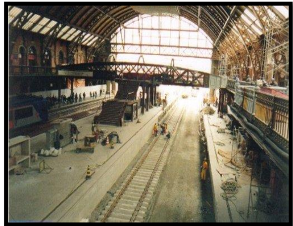
Foto 29: Reforma da Estação da Luz em 2002 em São Paulo - SP Foto: Luis Rafael de Souza 14
