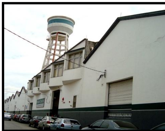
Foto 62: Galpões em atividade, na Mooca Foto da autora (2012)
