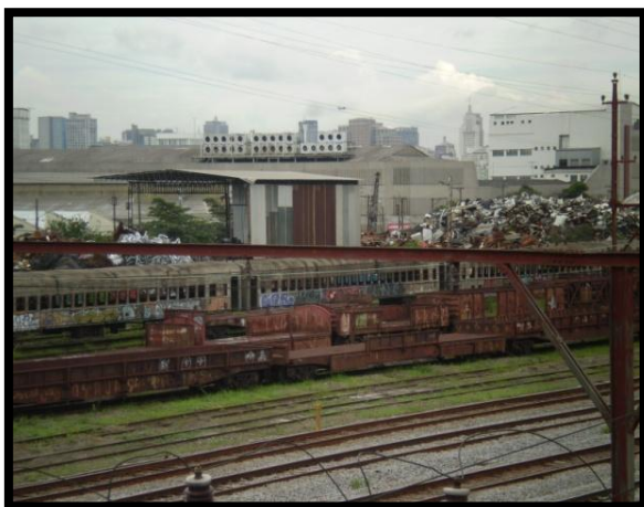
Foto 38: Galpão para entulho na Estrada de Ferro Santos - Jundiaí, em São Paulo – SP (vista do viaduto São Carlos)
