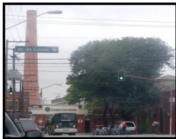
Foto 70: Fábrica de fios de algodão, em atividade, no Ipiranga
