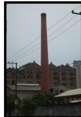
Figura 21: Antiga Cervejaria parcialmente utilizada (depósitos) em 2002, 2009 e 2013
