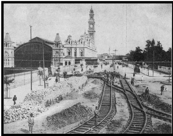
Foto 28: Construção da Estação da Luz em 1902 em São Paulo - SP Foto: Cessão Hermes Y. Hinuy Luis
