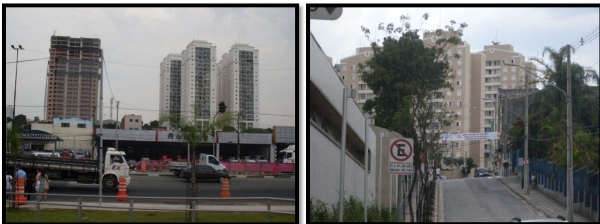
Fotos 76 e 77: Construção de empreendimentos residenciais no entorno da estação de metrô, na Vila Prudente Fotos da autora (2012)
