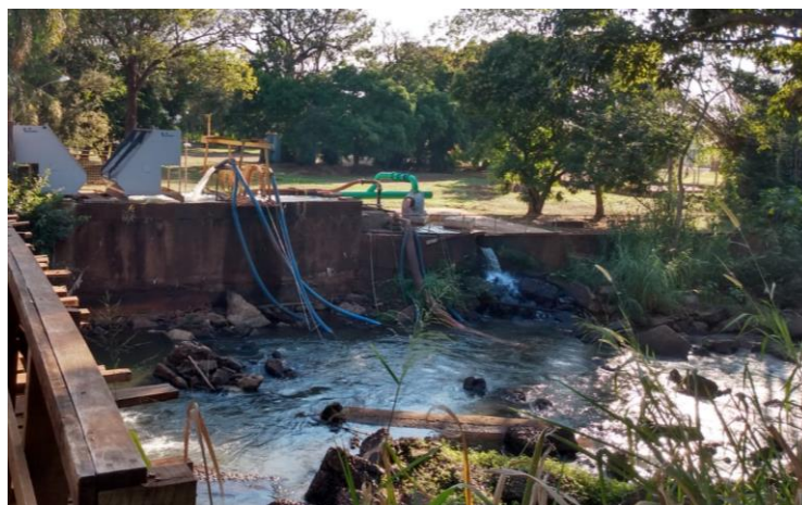
Figura 05 – Captação vista da margem oposta
