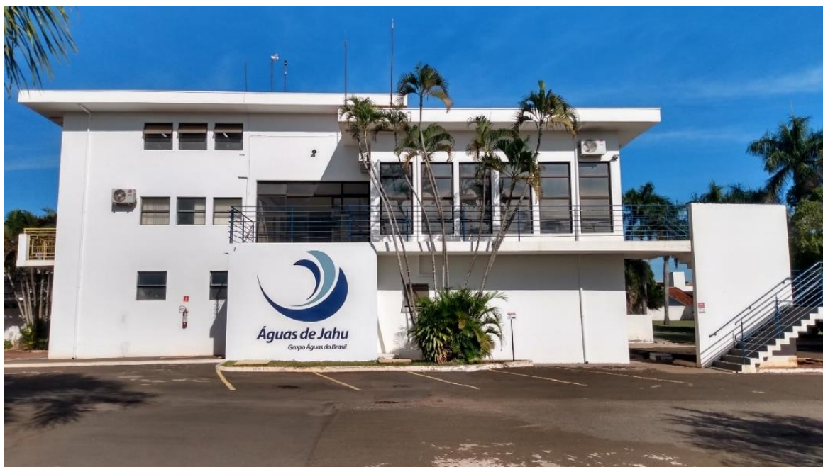
Figura 01 - Fachada do prédio da ETA
