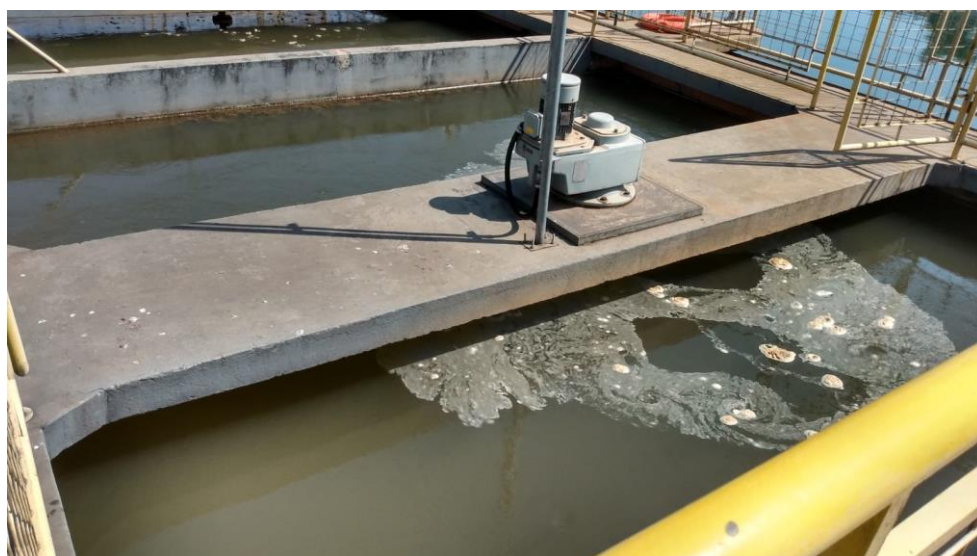
Figura 14 – Câmara de floculação
