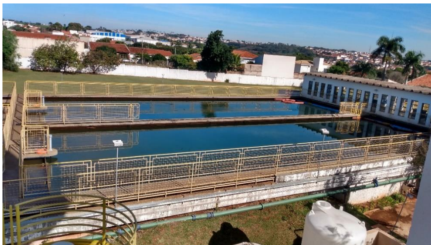
Figura 18 – Dois decantadores
