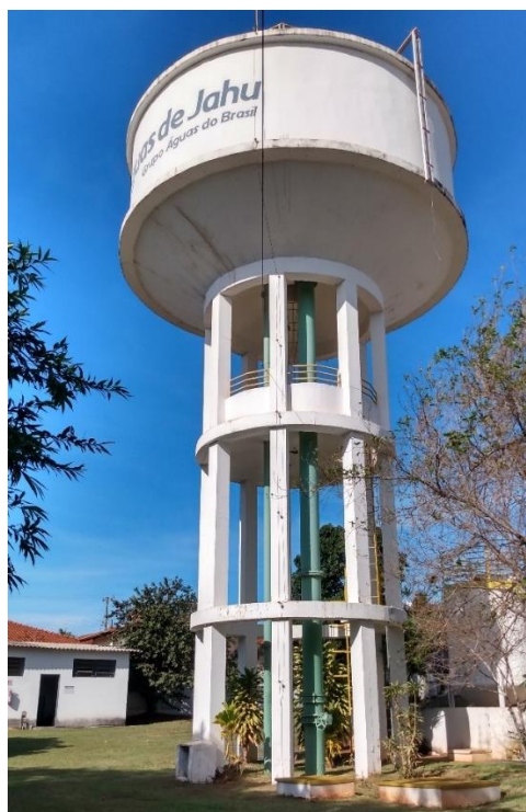
Figura 27 – Reservatório Elevado (T1)
