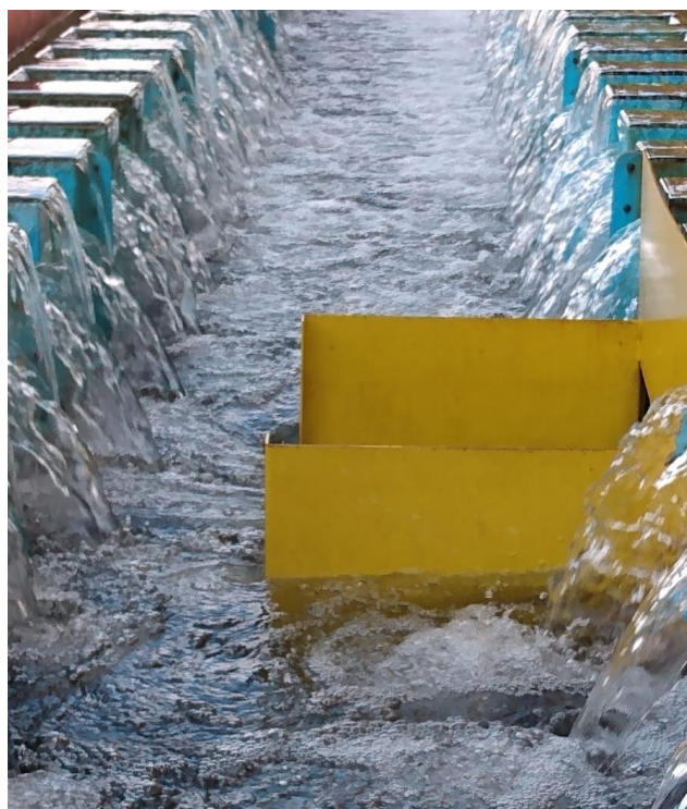
Figura 19 – Calha de recepção da água decantada já cristalina
