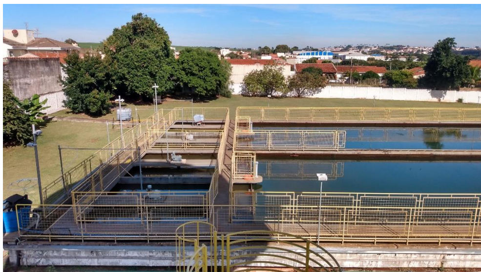
Figura 13 – Quatro câmaras de floculação e parte dos dois decantadores
