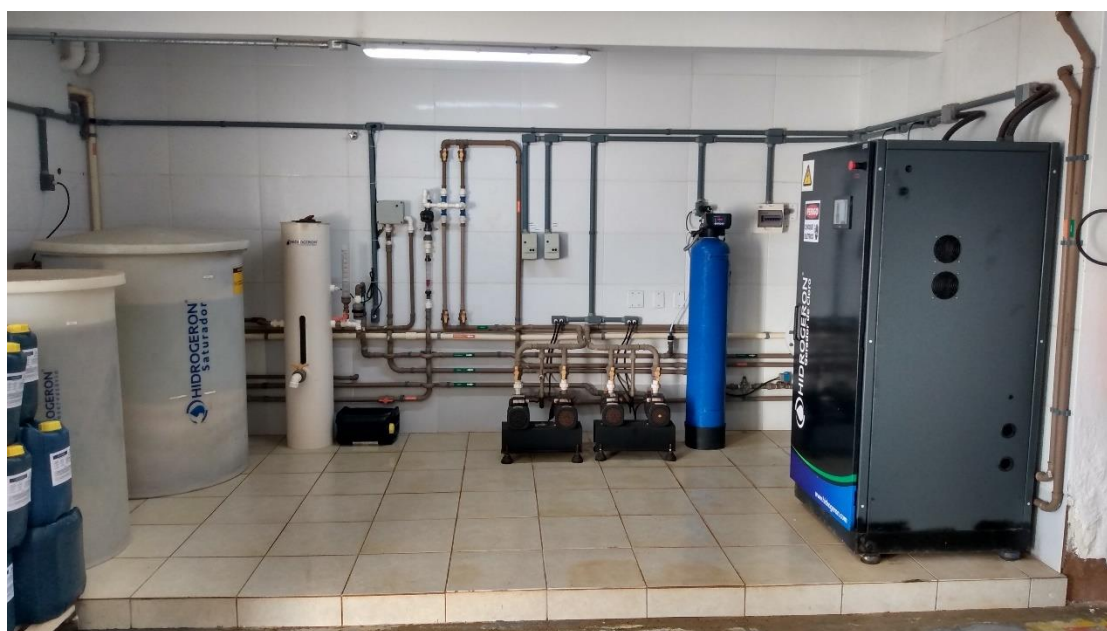
Figura 23 – Sistema de geração de cloro
