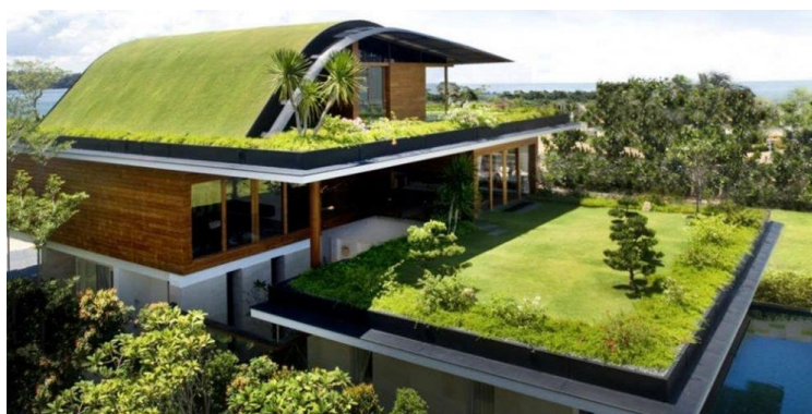
Figura 4 - Exemplo de utilização de telhados verdes
