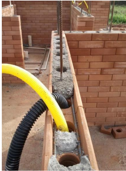
Figura 7 - Sistemas hidráulicos integrados com cimento Solo - Cimento
