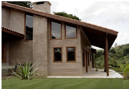
Figura 8 - Exemplo de utilização de tijolos Solo - Cimento
