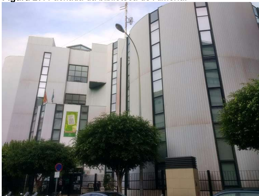
Figura 27: Fachada da biblioteca de Almería.
