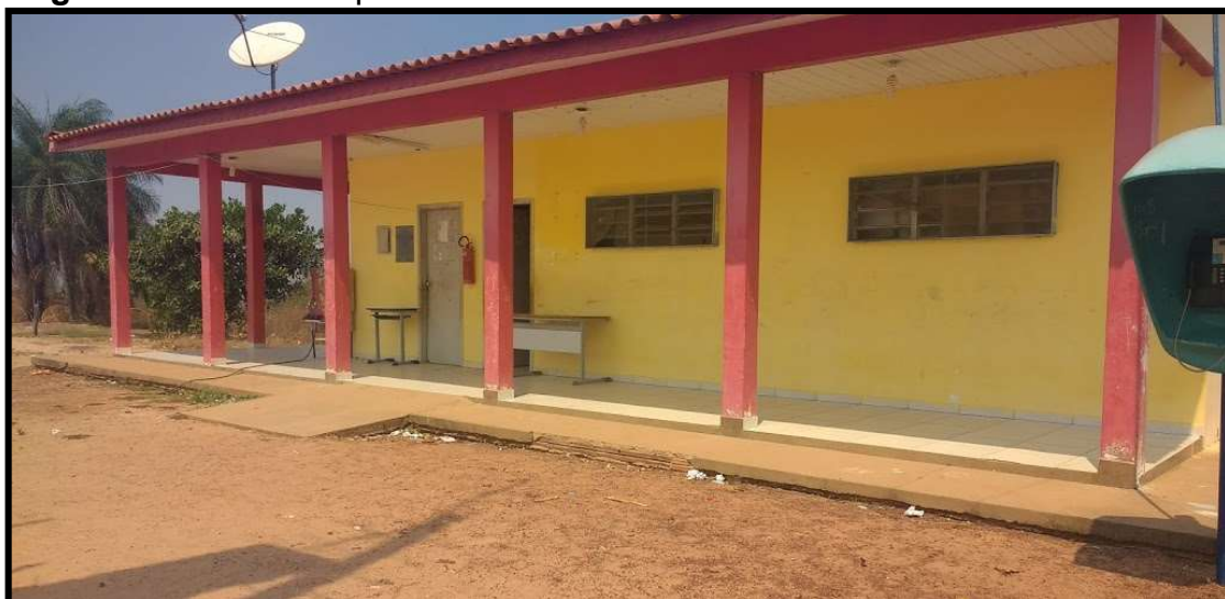
Figura 12: Frente de prédio da escola da aldeia.
