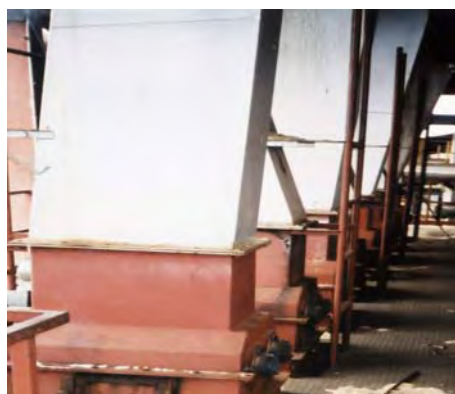
Figura 15: Foto do conjunto do sistema rotativo de alimentação de combustível nas caldeiras que se obstrui com as frações de palhiço da Usina Vale do Rosário-SP. Foto do autor (2004).
