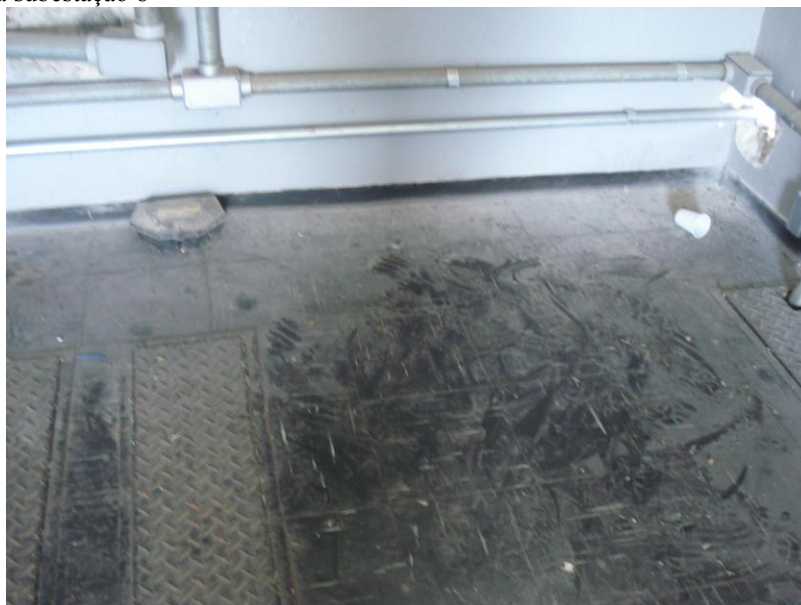
Figura 12 - Piso da subestação 8
