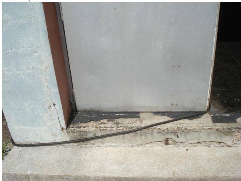
Figura 5 - Porta da subestação 3
