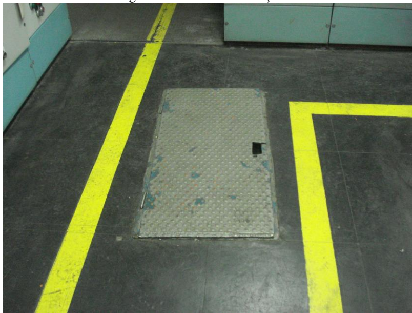
Figura 19 - Piso da subestação 12
