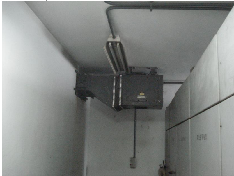
Figura 6 - Luminárias da subestação 4
