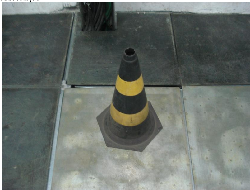
Figura 22 - Piso da subestação 14
