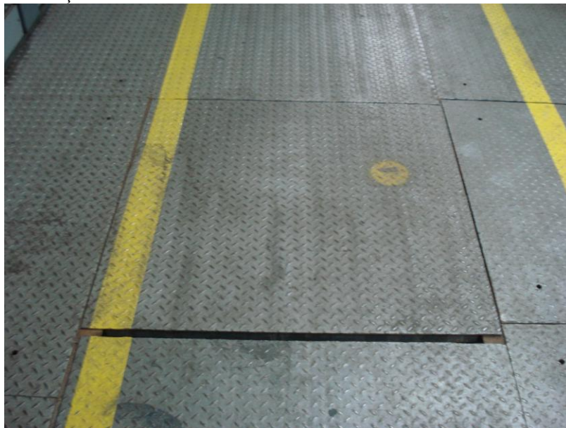
Figura 24 - Piso da subestação 15
