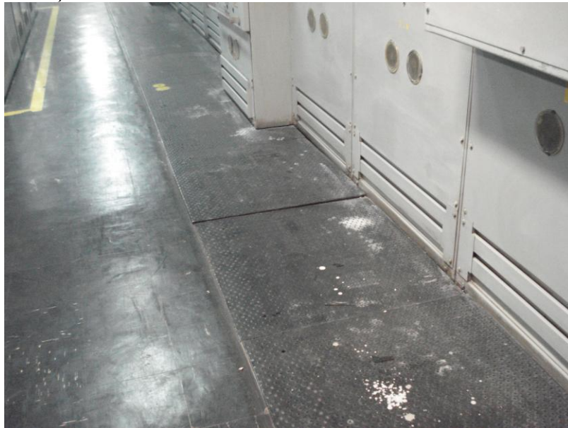
Figura 2 - Piso da subestação 1
