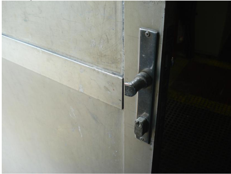
Figura 20 - Porta da subestação 13
