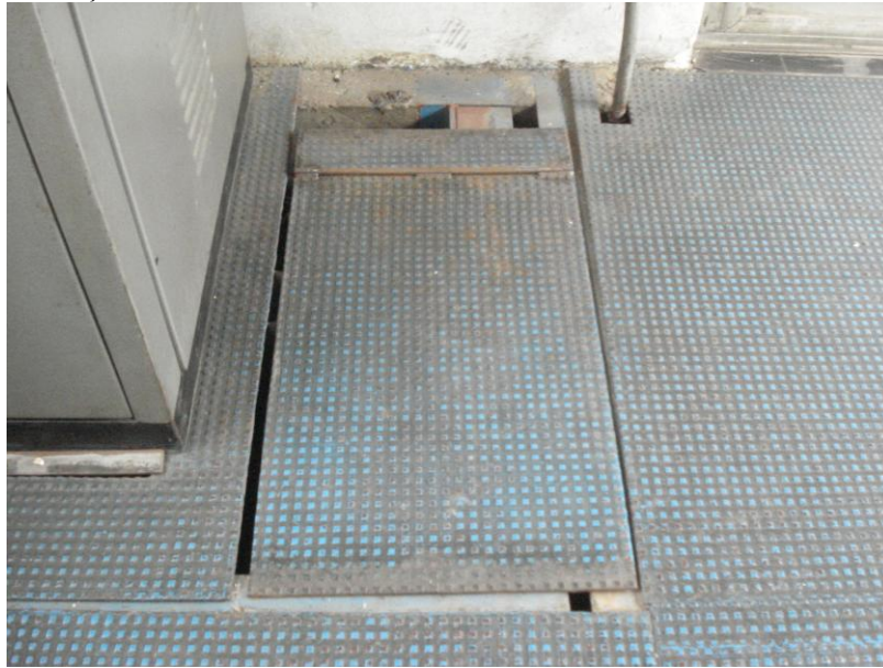
Figura 9 - Piso da subestação 7
