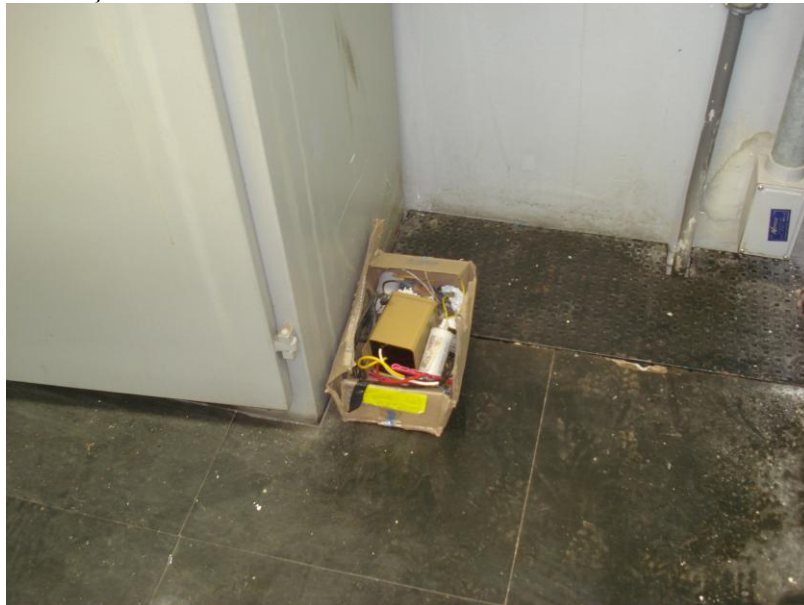
Figura 27 - Piso da subestação 16
