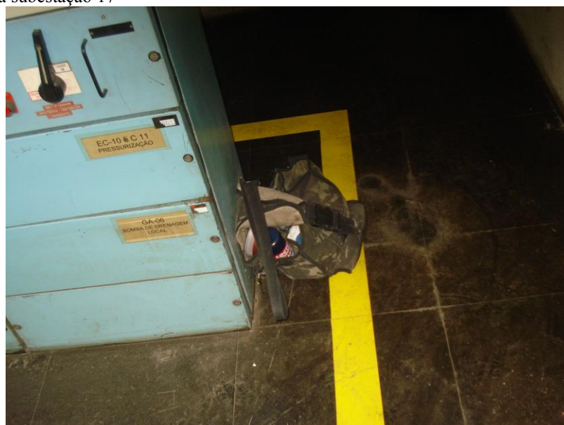
Figura 29 - Piso da subestação 17
