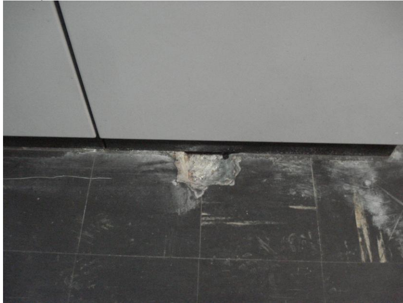
Figura 1 - Piso da subestação 1
