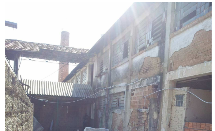
Figura 38: Vista da chaminé e esquadrias do edifício.
