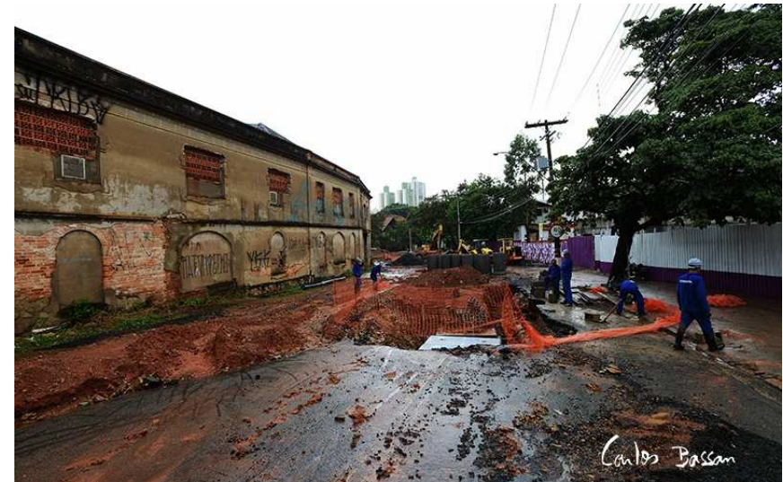
Figura 5: Obras na Av. Dr. Carlos de Campos. Fonte: Carlos Bassan, 2015.
