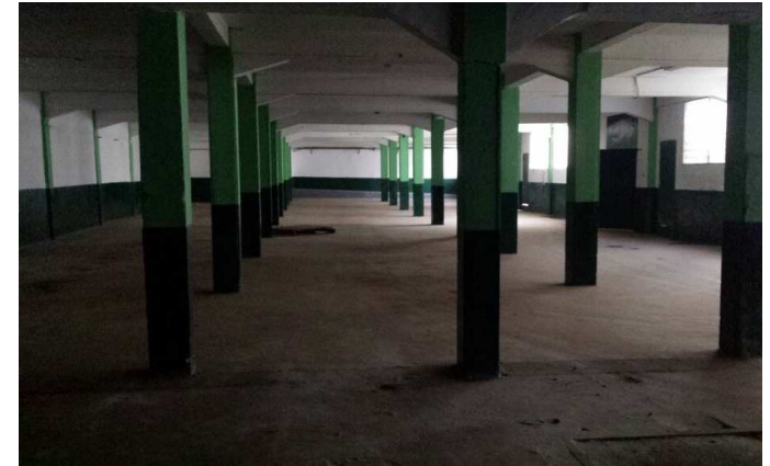
Figura 37: Interior do Bloco E.
