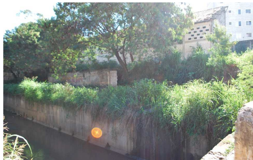
Figura 4: Fundo do Curtume e margem do córrego. Fonte: acervo da autora, 2017.
