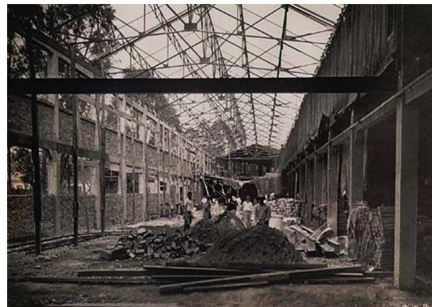
Figura 31: Reforma no Curtume Cantúcio, em meados de 1920. Fonte: Coordenadoria Setorial de Patrimônio Cultural (CSPC), Arquivo de Tombamento, 2010.
