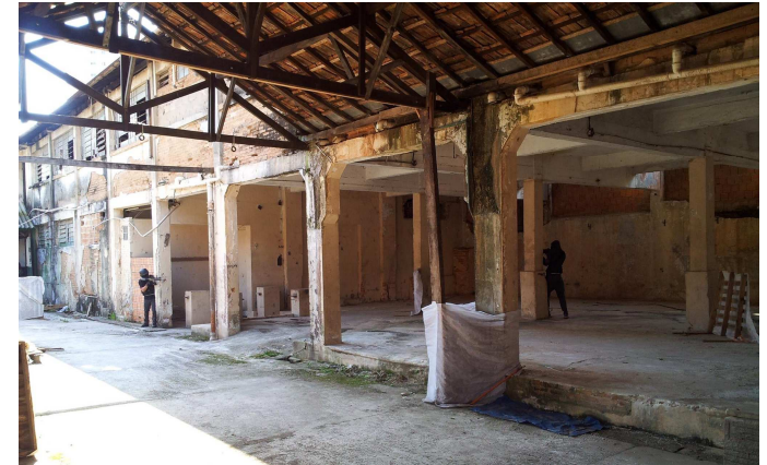
Figura 34: Interior do edifício. Telhado de madeira. Fonte: Arena Zumbi, 2016.
