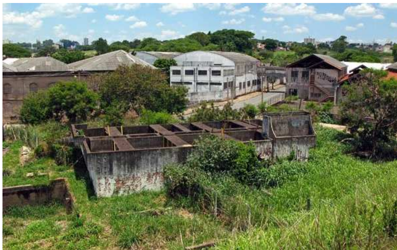
Figura 25: Antiga estação de tratamento. Foi demolida nos anos 2010. Fonte: Eduardo Dantas, 2008.
