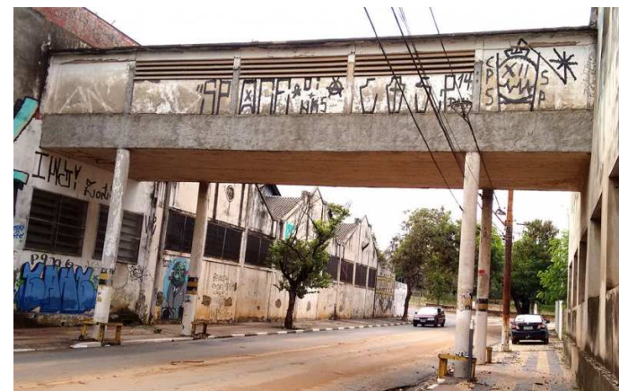
Figura 14: Passarela que fazia a ligação no Curtume Firmino Costa. Fonte: América Perfurações.
