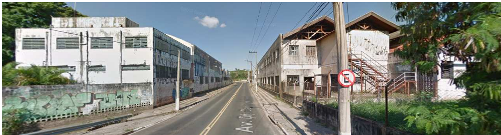
Figura 13: Vista dos blocos do Curtume Firmino Costa. Fonte: Google Street View, 2017.
