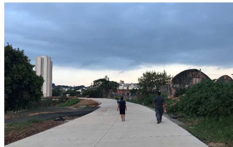
Figura 12: Corredor do BRT em obras. Fonte: acervo da autora, 2018.
