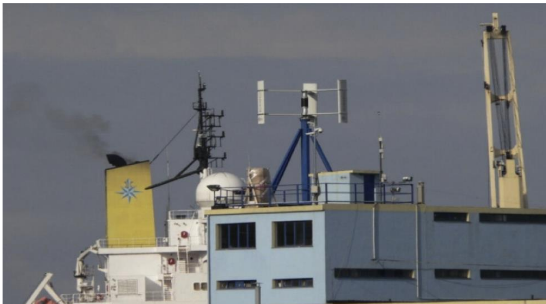
Figura 4 – Turbina eólica Darrieus instalada sobre um prédio.
