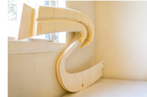
Fig. 62: Aplicação de PU na chapelona de compensado.
