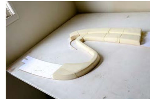
Fig. 60: Aplicação de PU na chapelona de compensado.
