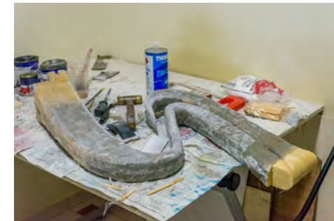
Fig. 64: Aplicação de fibra de vidro e massa plástica sobre o PU.
