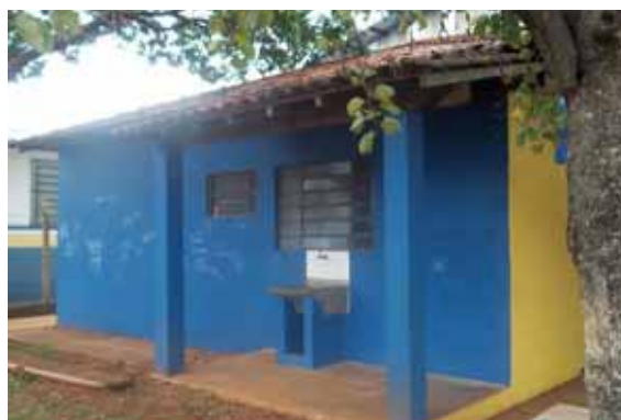
Figura 27: Vista exterior da S.R.M. 2 / fundos
