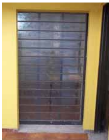
Figura 22: Porta Ampliada da entrada da S.R.M. 2.
