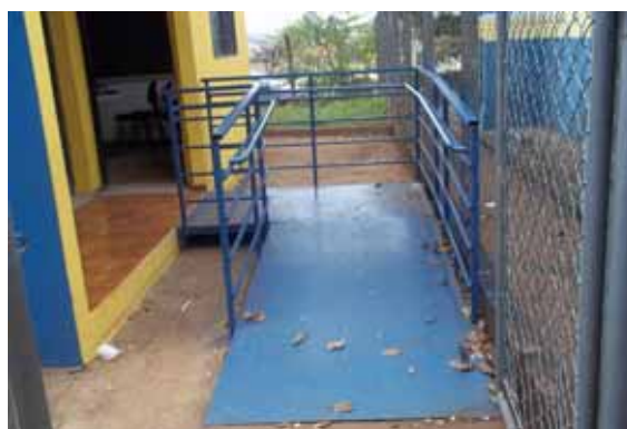
Figura 25: Rampa de acesso à S.R.M. 2
