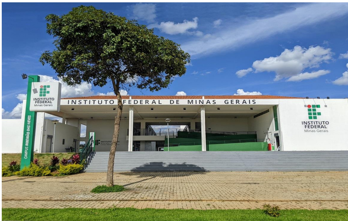
Figura 5 - Fachada do Câmpus Ribeirão das Neves
