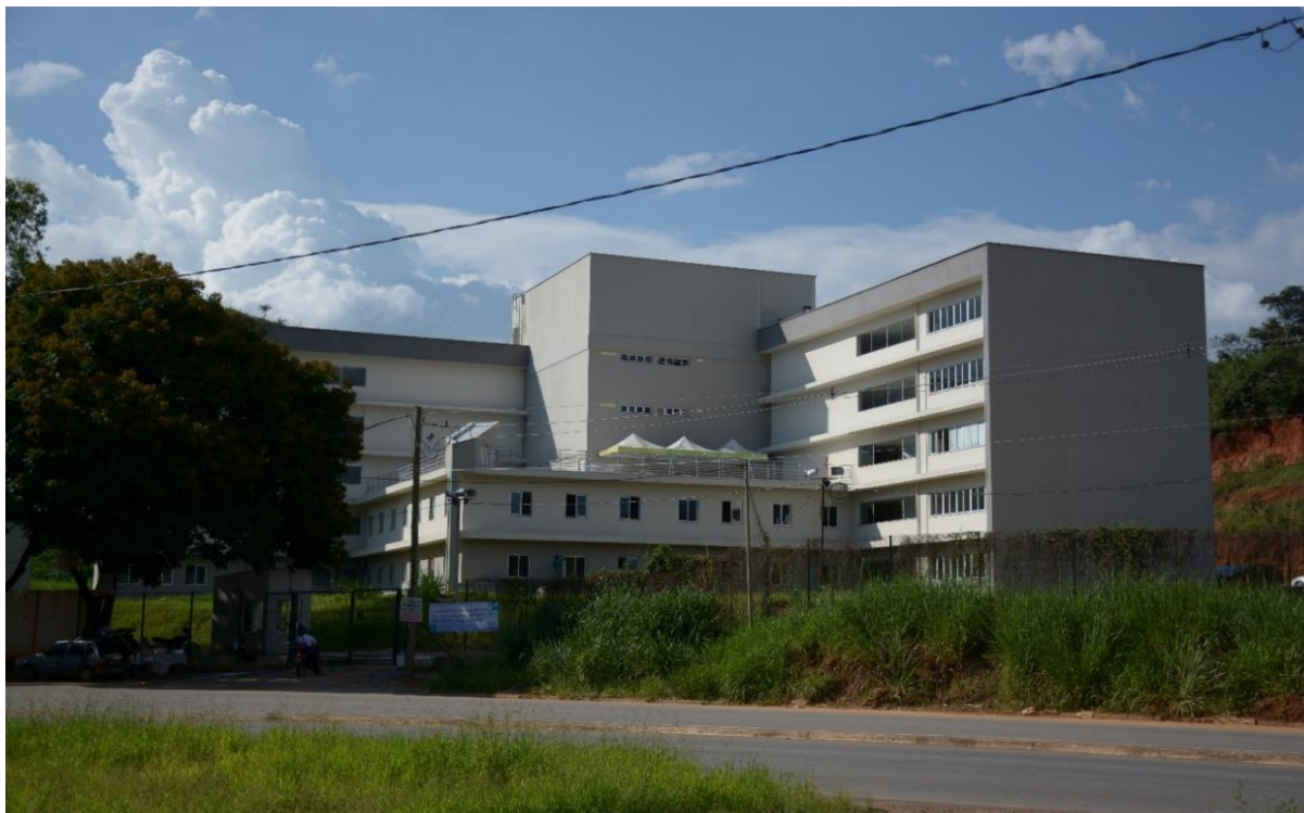
Figura 4 - Vista do Câmpus Sabará
