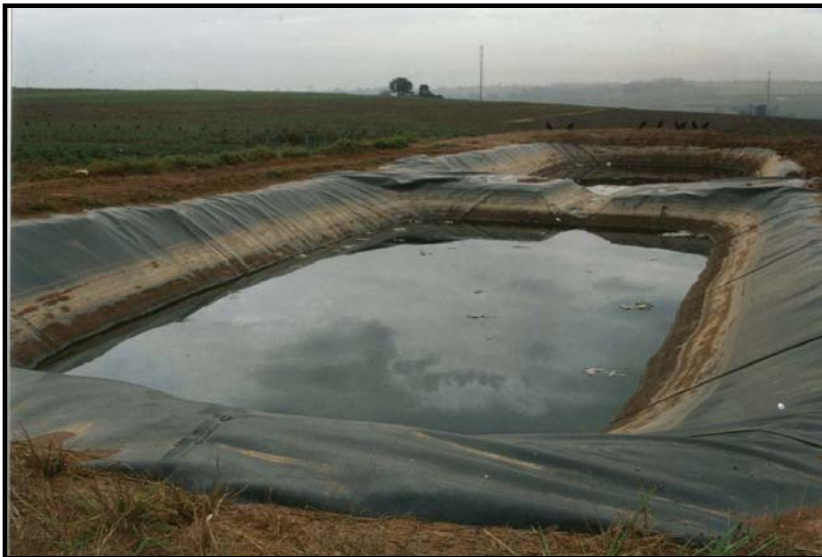
Figura 7. Lagoas de estabilização do líquido percolado no Aterro Sanitário do município de Rio Claro, SP.
