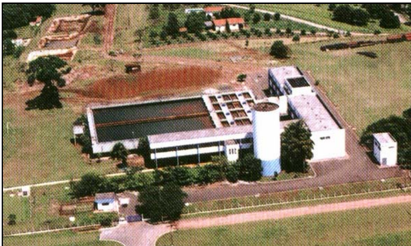
Figura 12. Vista aérea da ETA II, no canto superior esquerdo pode-se observar as três primeiras lagoas de secagem de lodo, construídas em alvenaria.
