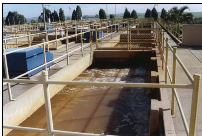
Figura 15. Unidades de floculação, ETA Capim Fino município de Piracicaba, SP.
