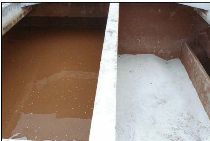
Figura 11. Unidade de filtração, ETA II município de Rio Claro, SP.
