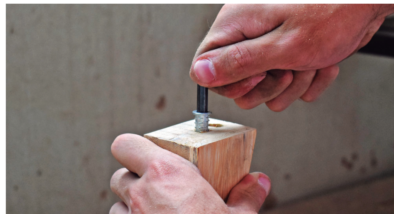
Figura 24 - Inserção de bucha americana na peça 4.
