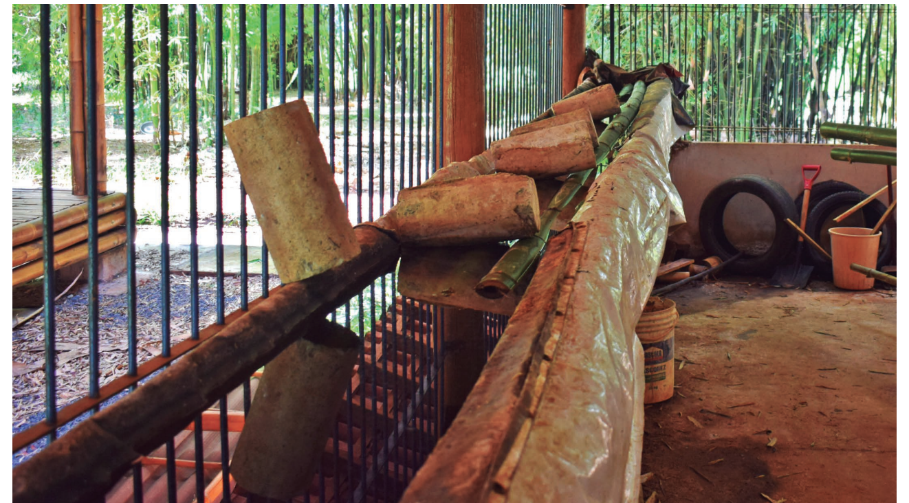
Figura 19 - Processo de tratamento preservativo por imersão.
