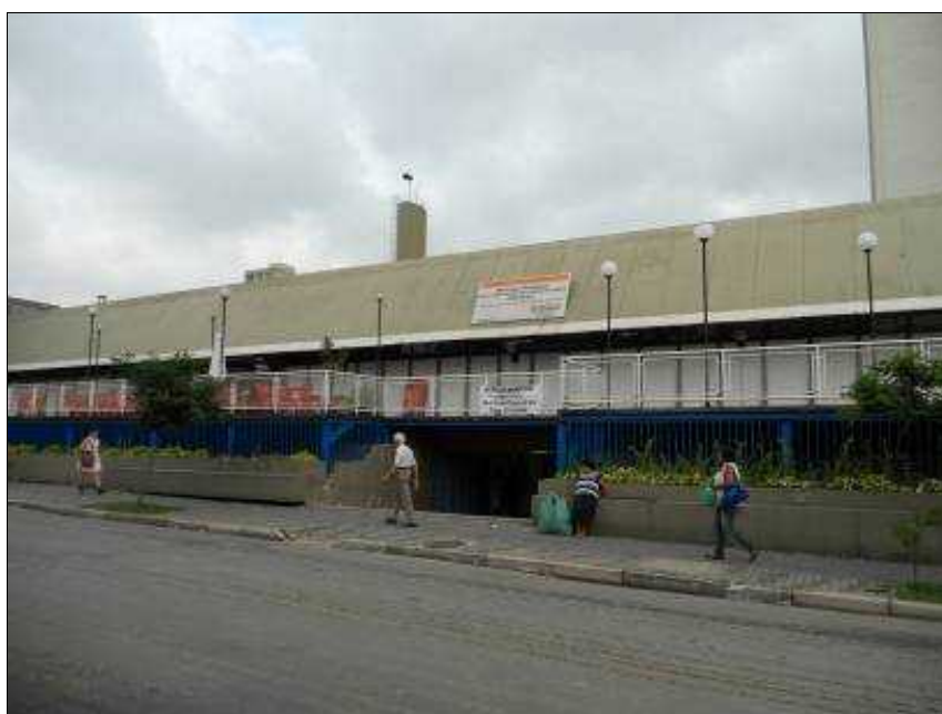
Fotografia 1: Fachada Principal do Mercado Municipal de Pinheiros
