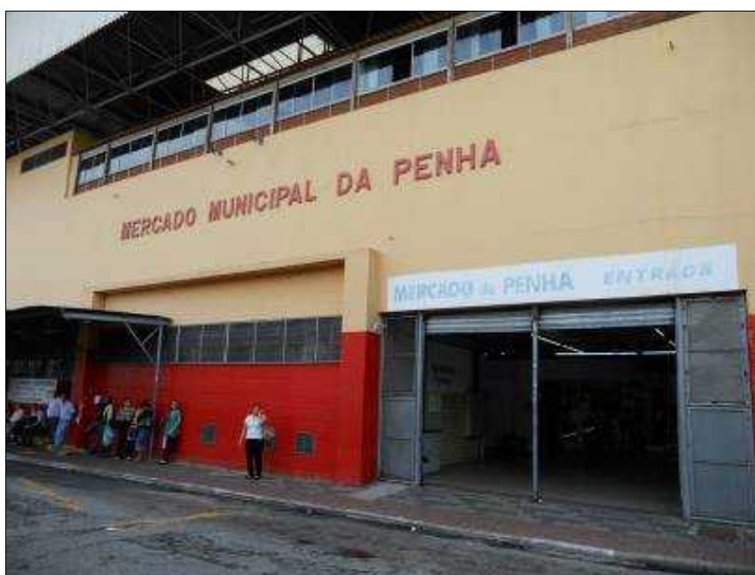
Fotografia 15: Fachada Principal do Mercado Municipal da Penha
