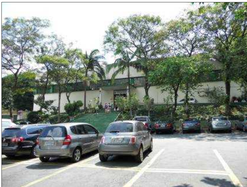
Fotografia 13: Fachada principal do Mercado de Santo Amaro
