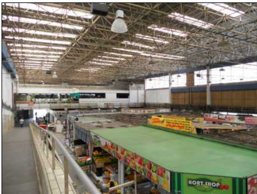
Fotografia 16: Interior do Mercado Municipal da Penha
