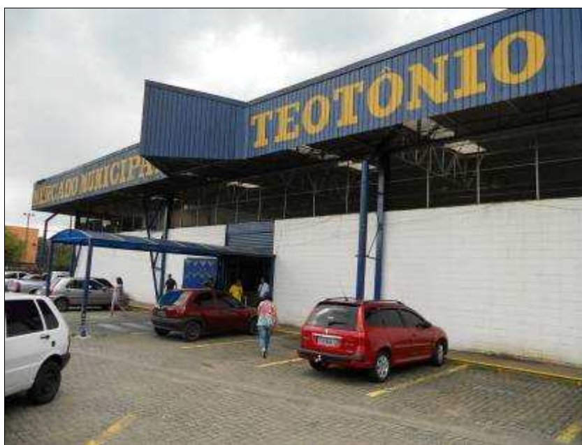
Fotografia 23: Fachada principal do Mercado Municipal de Teotônio Vilela
