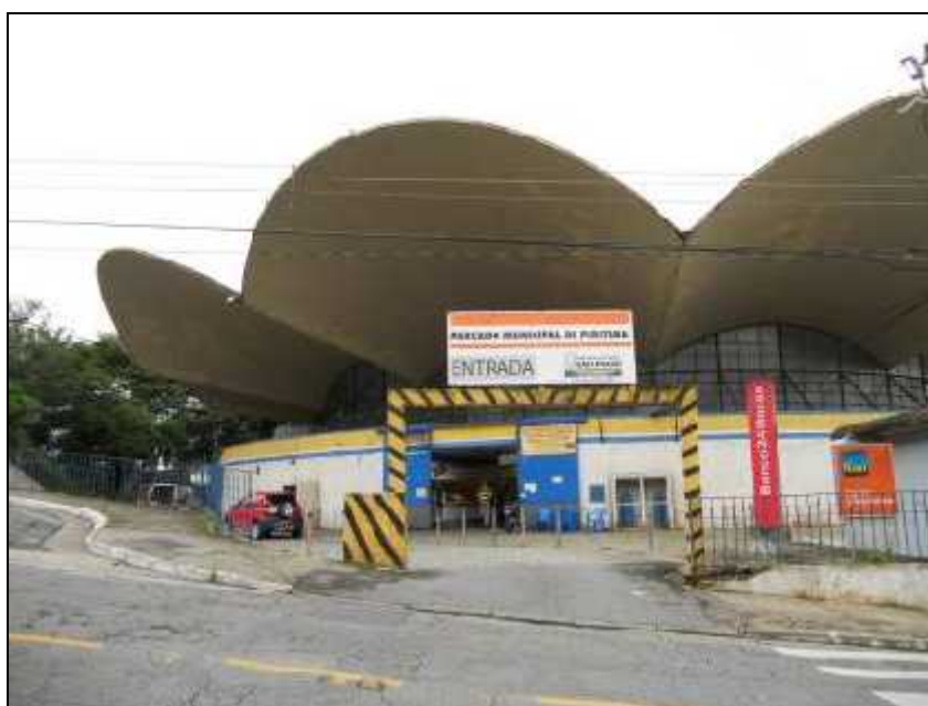
Fotografia 17: Fachada Principal do Mercado Municipal de Pirituba
