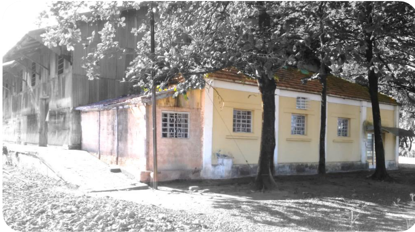
Figura 34: Anexo ao lado do armazém
