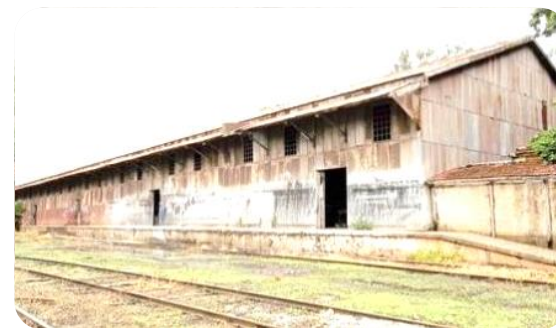
Figura 6: Armazém da FEPASA
