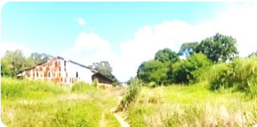
Figura 27: Atual situação do entorno do galpão.
