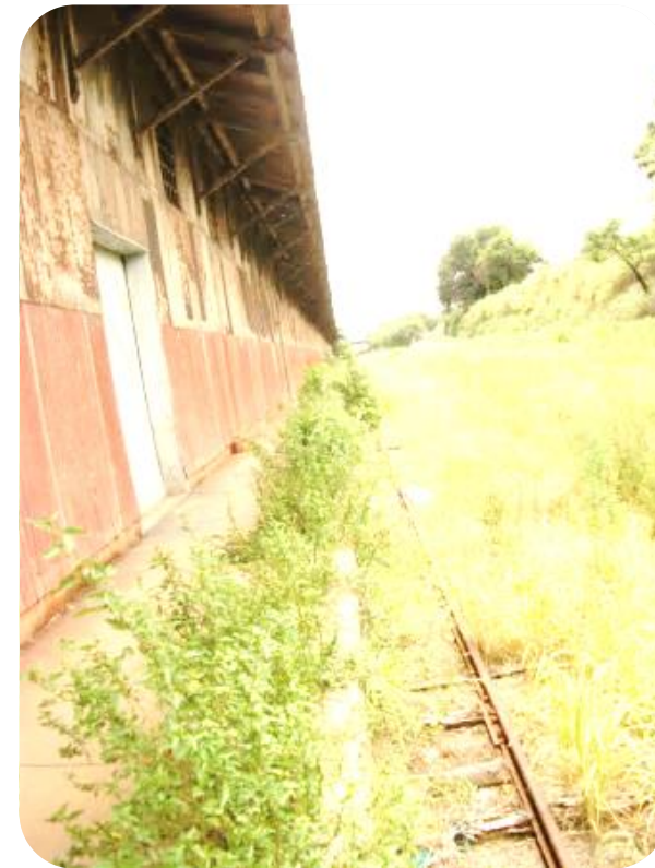
Figura 28: Plataforma do armazém.
