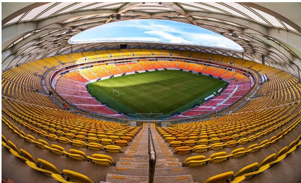
Figura 39 – Fotografia interna da Arena Amazônia. Detalhe para os assentos em tom amarelado e alaranjado, os anéis interligados e a cobertura em placas de PTFE.
