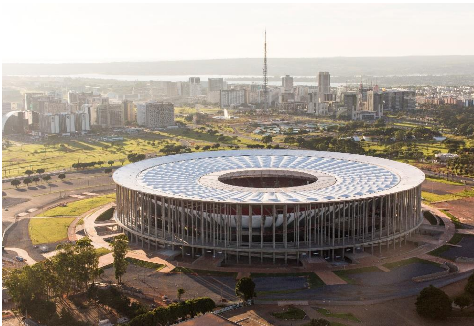
Figura 34 – Fotografia aérea do Estádio Mané Garrincha, após da reforma para a Copa do Mundo de 2014. Detalhe para as colunas esbeltas e a cobertura em manta.
