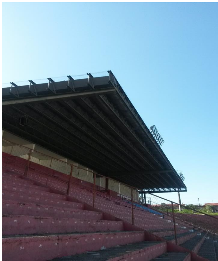
Figura 59 – Cobertura existente no “Ninho da Garça” – Detalhe para os módulos de treliças metálicas e a pequeno alcance da cobertura.
