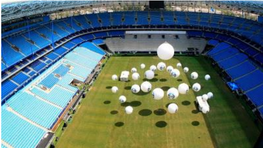
Figura 44 – Fotografia aérea do interior da Arena do Grêmio. Detalhe para os assentos individuais em azul, os quatro níveis e as treliças metálicas espaciais.
