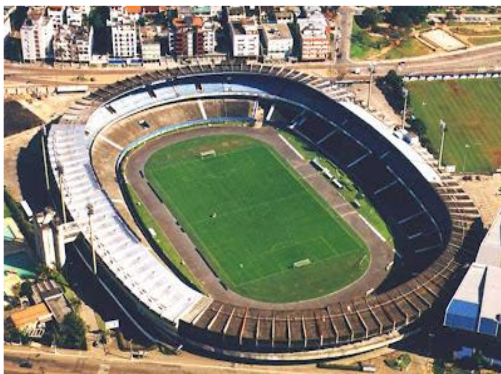
Figura 42 – Fotografia aérea do Estádio Olímpico Monumental. Detalhe para sua cobertura e arquibancadas em concreto armado.
