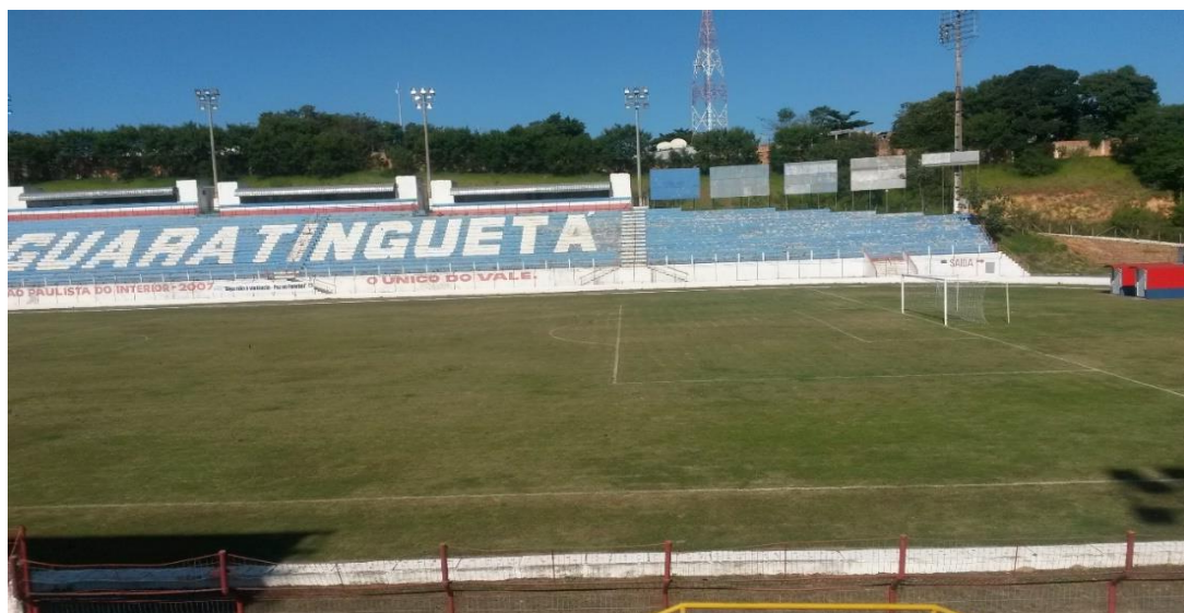
Figura 75 – Postes de iluminação do “Ninho da Garça”. Detalhe para a baixa altura e a localização atrás da arquibancada.
