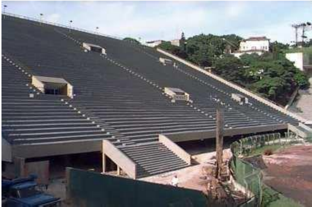
Figura 6 – Arquibancada recém construída, conhecida como “Tobogã”.
