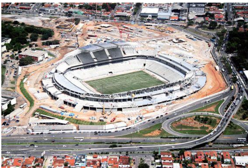
Figura 27 – Fotografia aérea da Arena das Dunas, ainda em sua construção.
