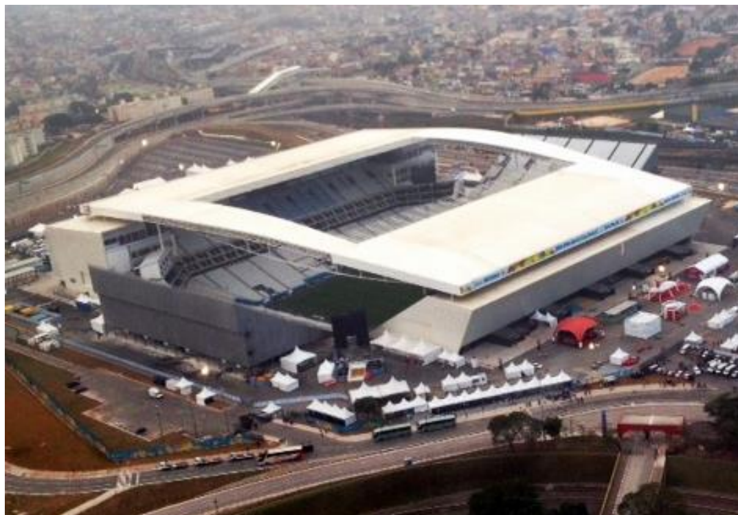
Figura 16 – Vista aérea da Arena Corinthians, ainda com a arquibancada provisória.
