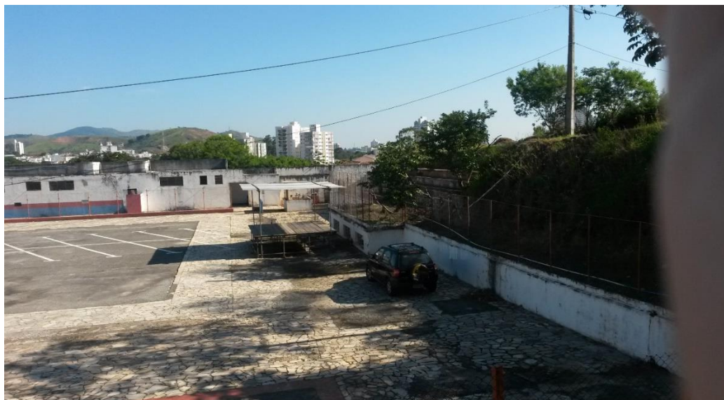
Figura 55b – Fotografia da área livre de entrada do Estádio Municipal Prof. Dario Rodrigues Leite. Detalhe para a quadra poliesportiva, o desnível e os banheiros das piscinas desativados.
