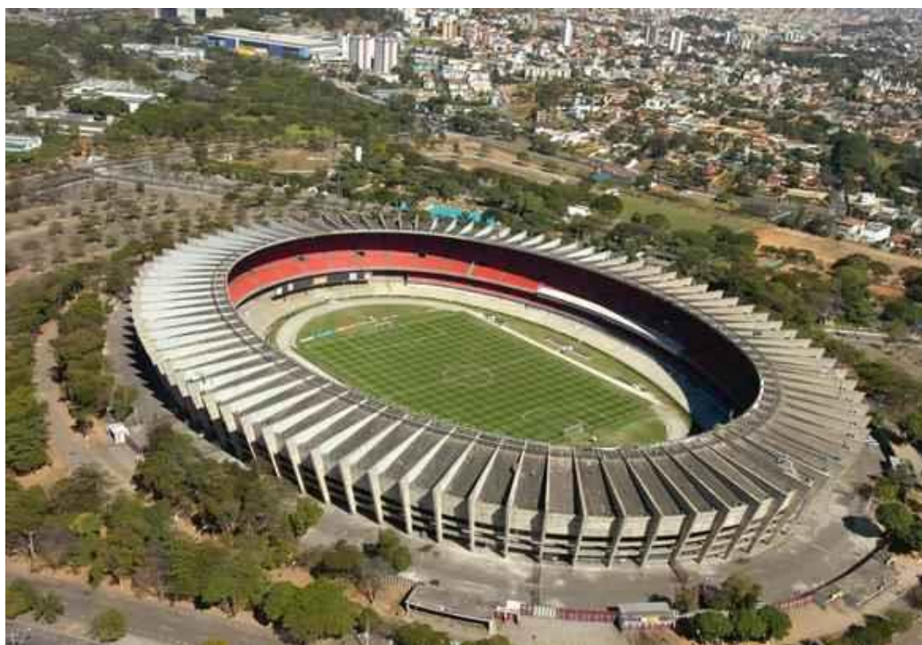
Figura 24 – Fotografia aérea do Estádio Mineirão, em Belo Horizonte, antes da reforma para a Copa do Mundo de 2014.
