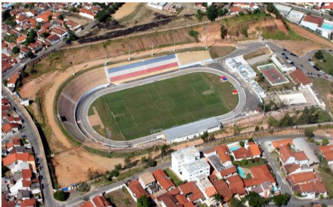
Figura 51 – Fotografia aérea do Estádio Municipal Prof. Dario Rodrigues Leite antes da ultima pintura, construção de camarotes e assentos individuais.
