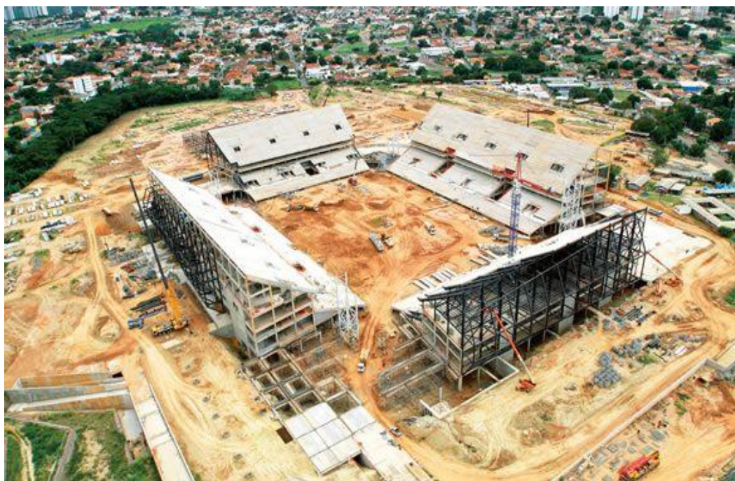
Figura 40 – Fotografia da Arena Pantanal em construção. Detalhe para a estrutura metálica das arquibancadas móveis.
