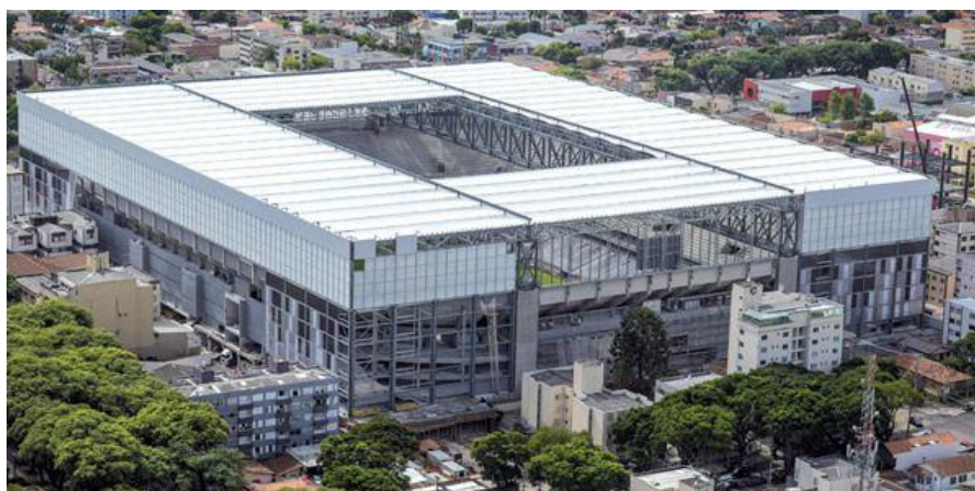
Figura 22 – Foto aérea da Arena da Baixada, no Paraná, após a reforma para a Copa do Mundo de 2014.
