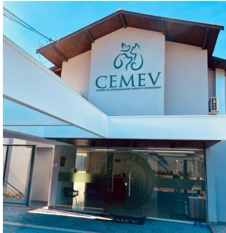
Figura 3 - Fachada do Centro de Especialidades Médico Veterinário.
