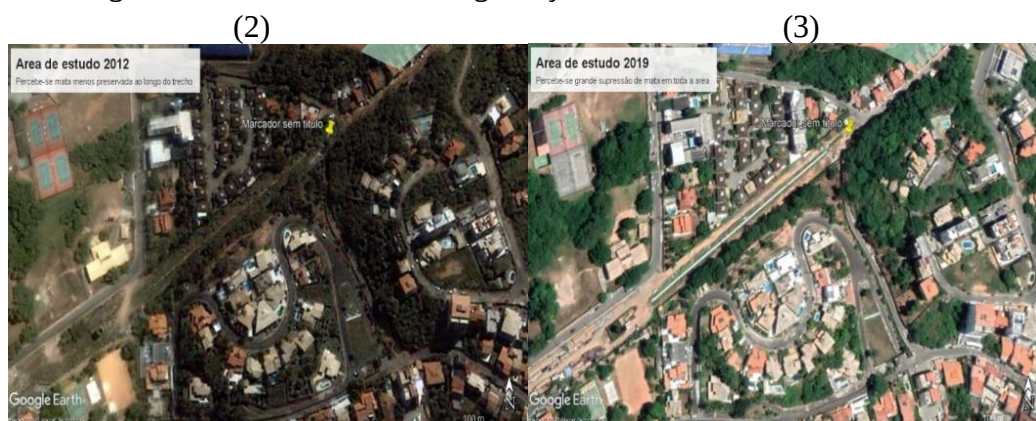
Figuras 2 e 3 - Mostrando a degradação da área nos anos 2012 e 2019
