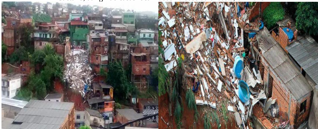
Figuras 3 e 4 (esquerda para direita) – Vista da encosta, deslizamento e desabamento de prédio em São Caetano, atingindo casas localizadas na base da encosta, em 2015
