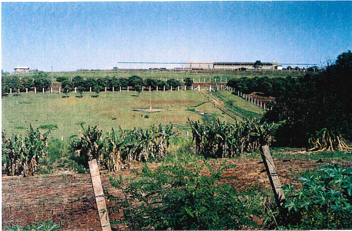
FOTO 10 - Aspecto da Unidade de Tratamento de Esgoto HALF - Córrego Cabrinha. Foto do Autor
