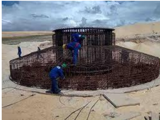
Figura 7 – Construção de uma fundação tipo “estaca”.
