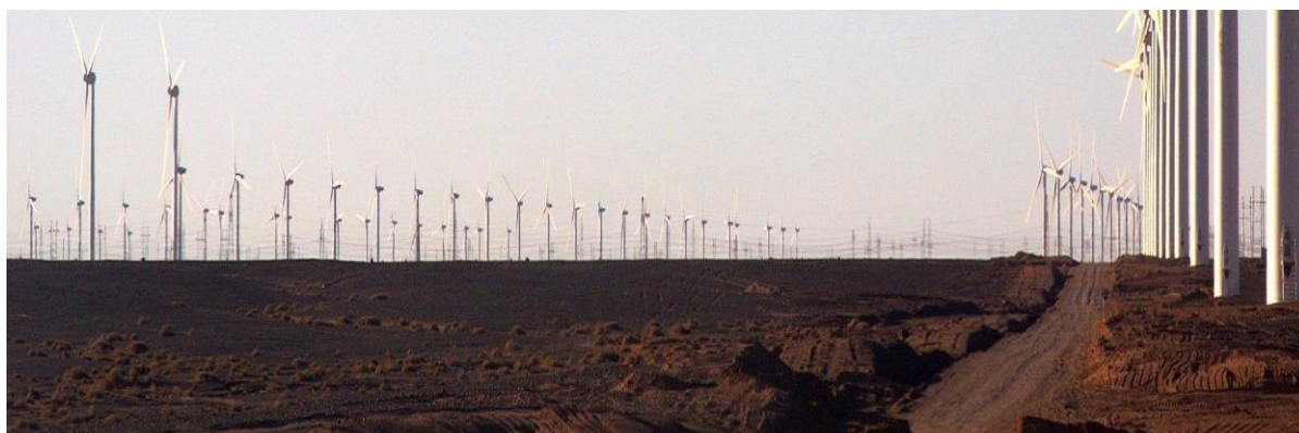
Figura 24 – Trecho do parque eólico de Gansu.
