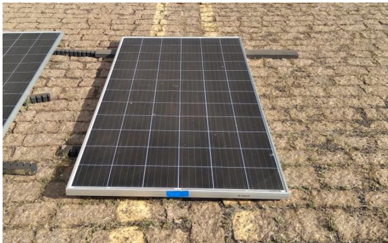
Figura 7: Estabilização do módulo fotovoltaico.
