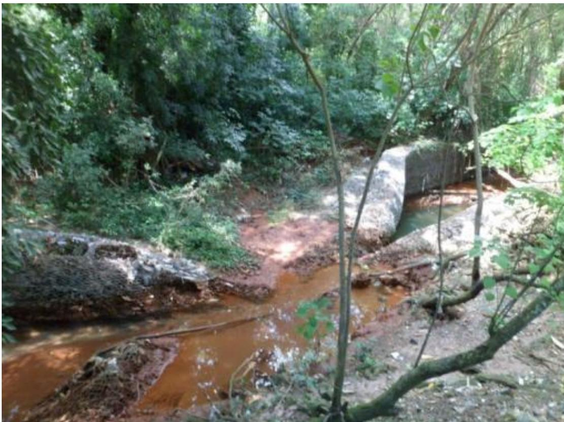
Figura 47 – Gabiões para contenção de talude localizado no baixo curso do Córrego Lavapés. Acervo pessoal. Imagem de Março/2015.
