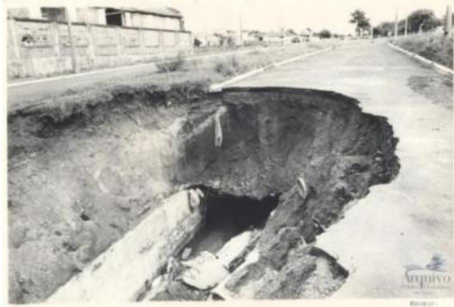
Figura 40 – Subsidência devido a rompimento de galeria pluvial. Fonte: Arquivo Histórico de Rio Claro.
