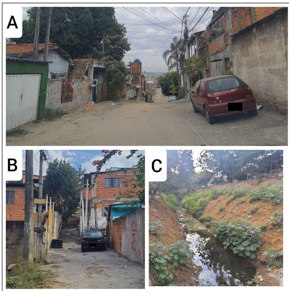
Figura 49 – A -via não pavimentada com ausência de sistema de drenagem (canaletas e bocas de lobo); B - caminho de viela; C - córrego na porção jusante da encosta.
