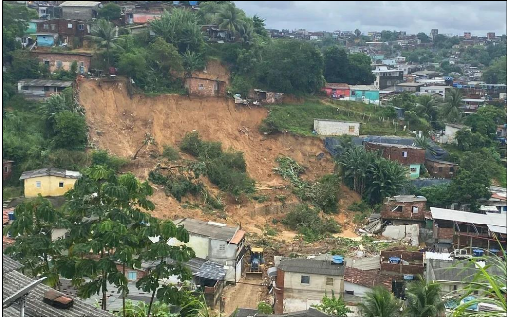
Figura 16 – Barreira cedeu e matou dezenas de pessoas em Jardim Monte Verde, entre o Recife e Jaboatão.
