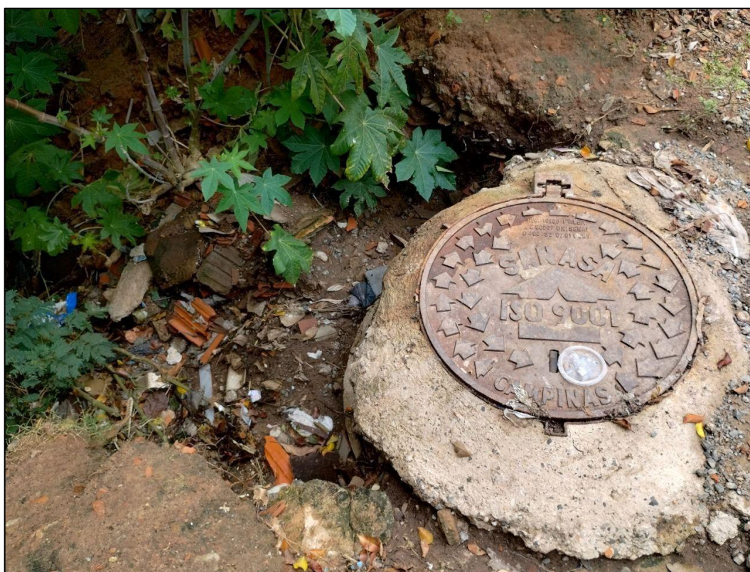
Figura 51 – Erosão ativa no topo do talude atingindo a via pública e descarte de resíduos sólidos.
