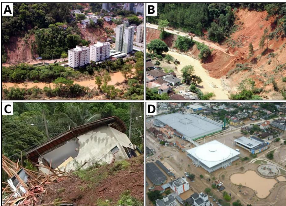
Figura 12 – Desastre de Blumenau (SC) em 2008. A: deslizamentos em encosta que destruíram casas. B: deslizamento interditou a estrada. C: casa destruída devido ao deslizamento. D: rastro de lama na cidade de Blumenau.
