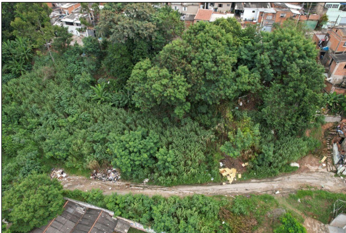
Figura 56 – Descarte de resíduos sólidos na base do talude.
