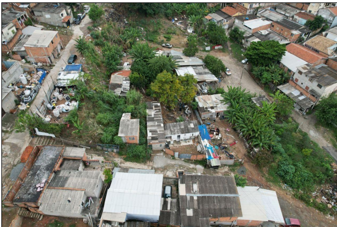
Figura 57 – Talude alterado com cortes e aterro.
