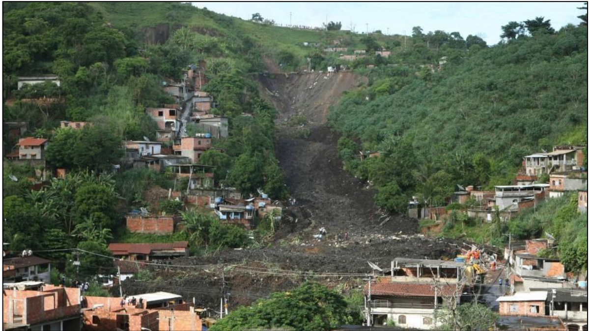
Figura 14 – Deslizamento no Morro do Bumba, Niterói (RJ), em abril de 2010.
