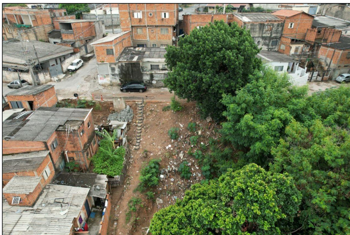
Figura 55 – Topo do talude com solos expostos e descarte de resíduos sólidos.
