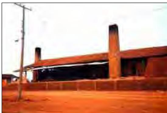
**Fotografia 03** – Detalhe de uma das cerâmicas. Notar que as chaminés não apresentam qualquer tipo de filtro e que os resíduos gerados pela atividade industrial são depositados diretamente no solo bem como a matéria prima para a fabricação dos artefatos cerâmicos. Autor: Ângelo Spoladore.
