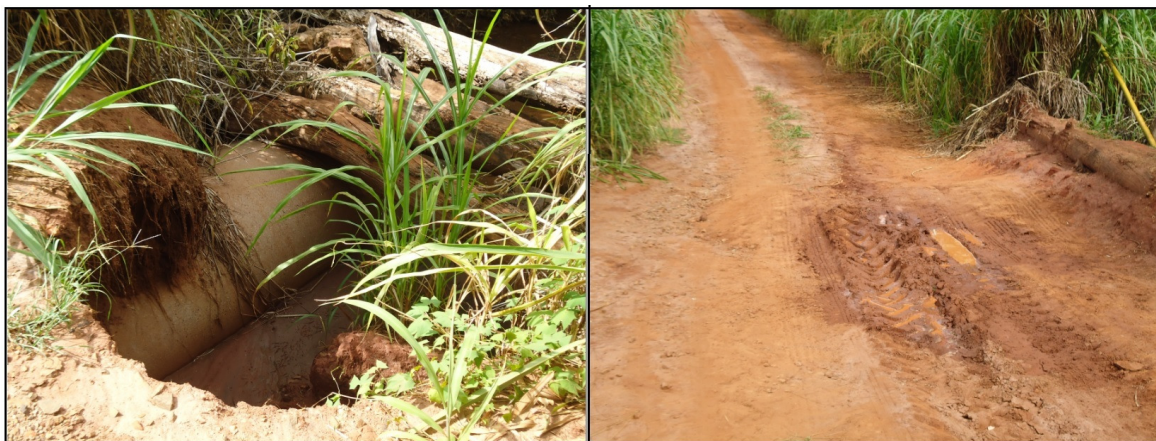
Figura 13 - Má conservação e erosão na estrada rural.
