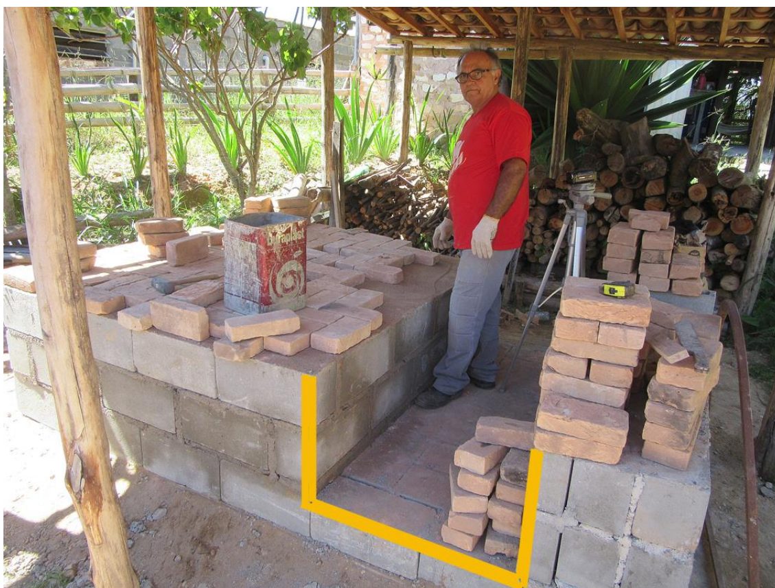
Figura 67: Sr. Evandro Oliveira construindo a base do forno catenário, Resende Costa, 2016.
