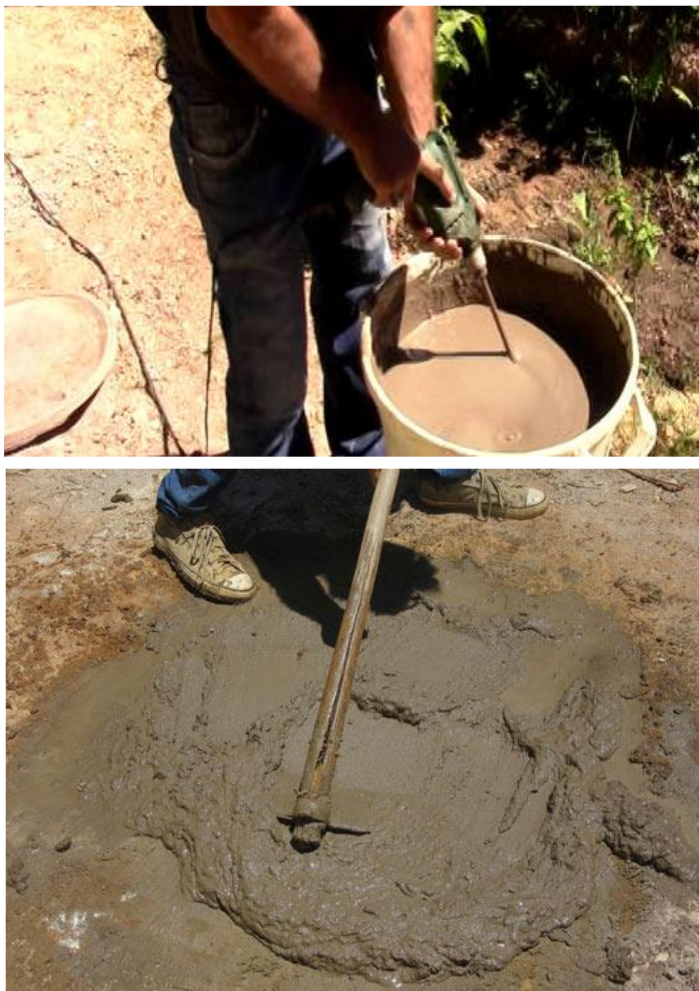
Figura 70: Preparação de massa para assentamento dos tijolos da fornalha e braseiro. Acima: massa em forma de barbotina, abaixo: massa com textura de reboco. Resende Costa. 2016.
