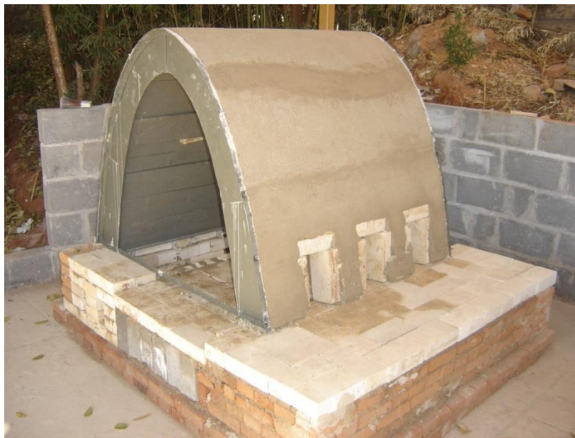
Figura 58: Projeto de forno alternativo, com arco catenário feito com a técnica de taipa. São João Del Rei, MG, 2004.
