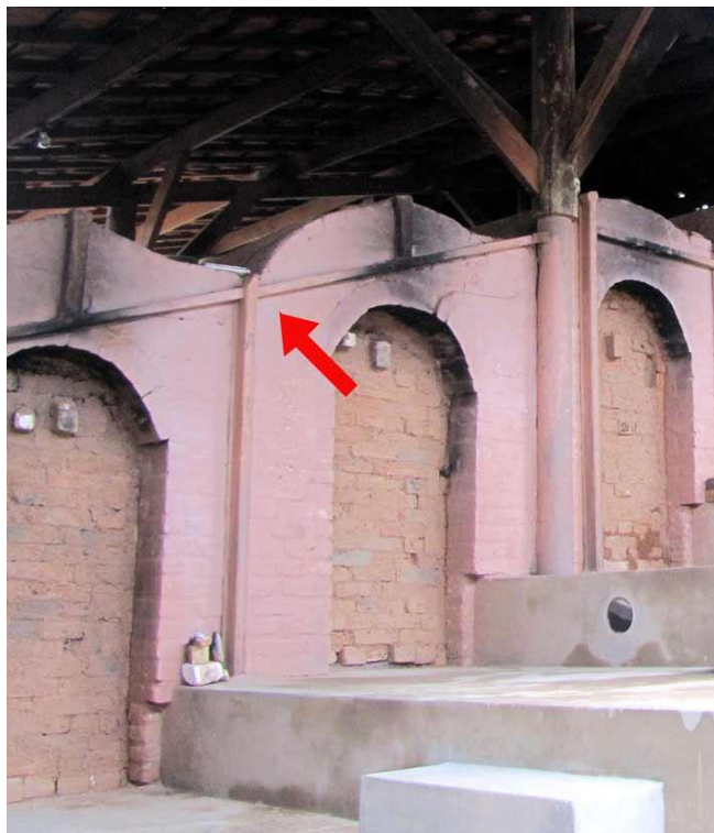
Figura 96: Amarrações em ferro em torno de um forno Noborigama. Cunha - SP, 2010.
