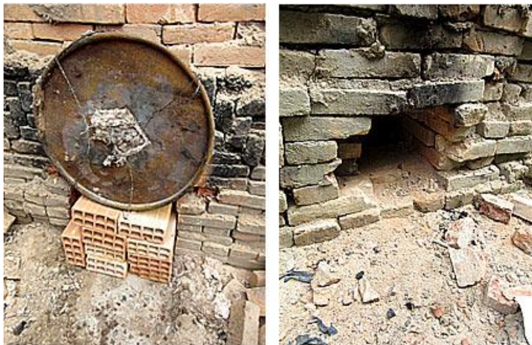
Figura 104: Esquerda: suporte de tijolos na base do braseiro; Direita: abertura para oxigenação, na parte posterior do forno. Ritópolis, 2016.
