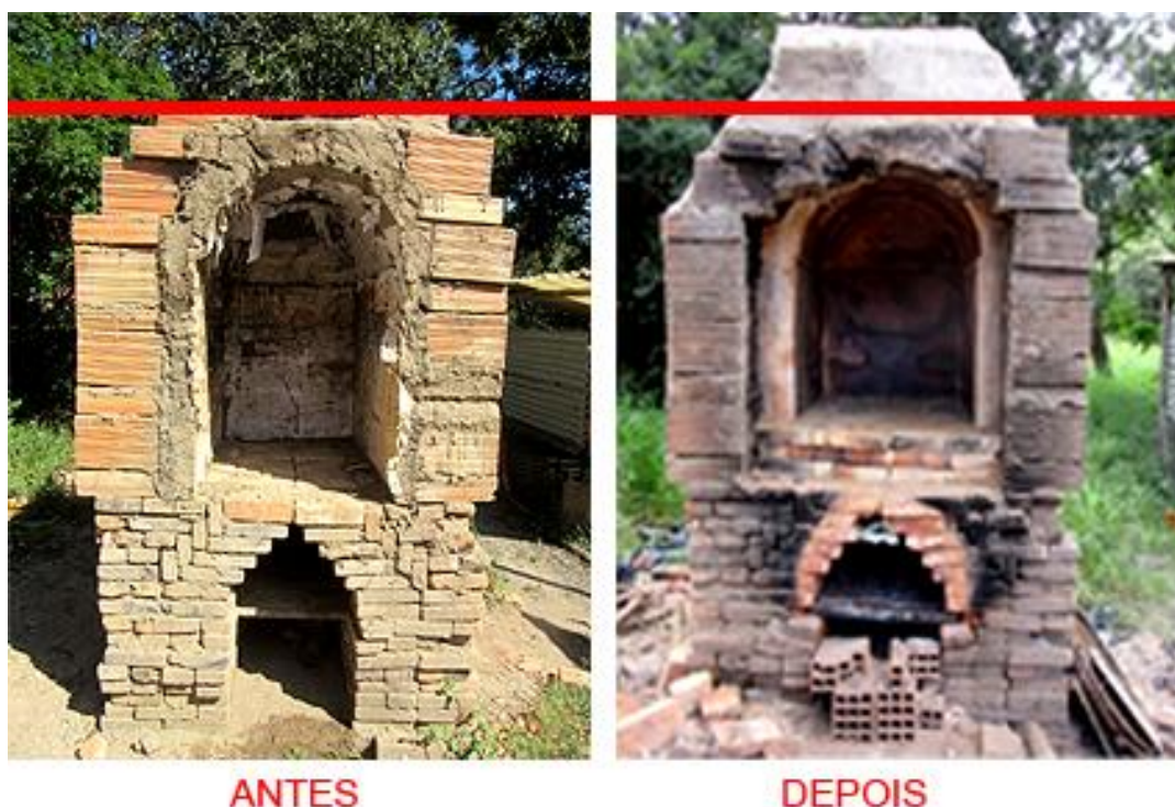
Figura 101: Forno de Arco Romano, antes de depois da reforma. Ritópolis, 2016.
