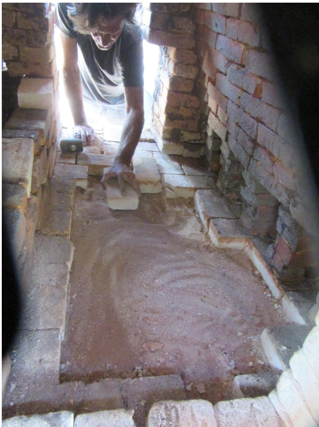
Figura 81: Base da câmara de queima sendo refeita após primeira queima. Resende Costa – MG, 2016.
