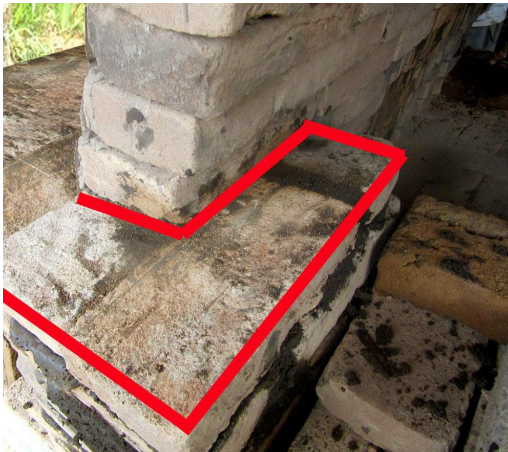
Figura 77: Amarração das paredes, feita fiada a fiada, 2016.
