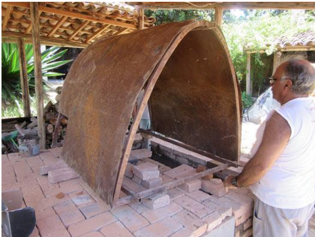
Figura 73: Sr. Evandro Oliveira conferindo a montagem da fôrma sobre a base do forno. Resende Costa, 2016.
