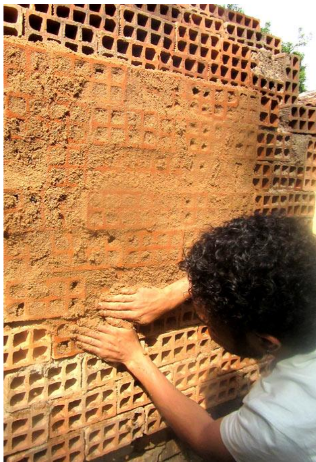
Figura 93: Preenchimento dos furos dos tijolos que compõem a parede externa do forno de Arco Romano. Ritápolis, 2016.
