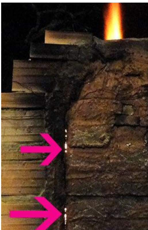
Figura 102: degrau na parede do forno. Ritápolis, 2016.
