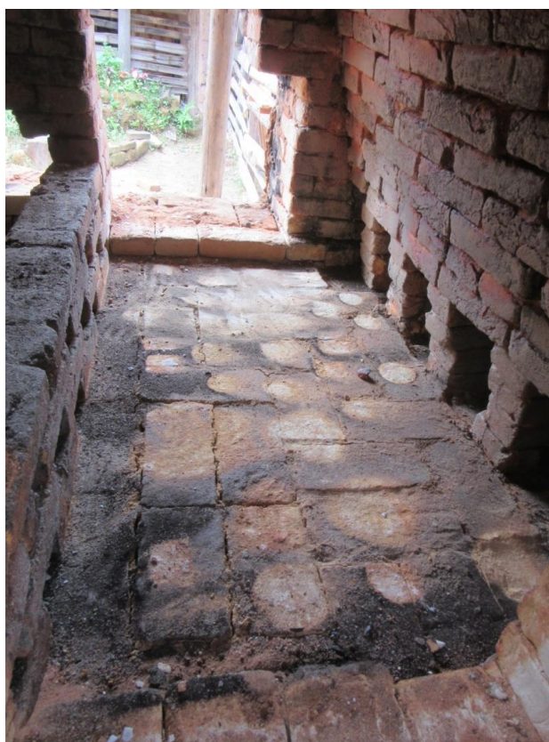
Figura 85: Vista da integridade da base da câmara de queima, após segunda queima. Resende Costa, 2016.
