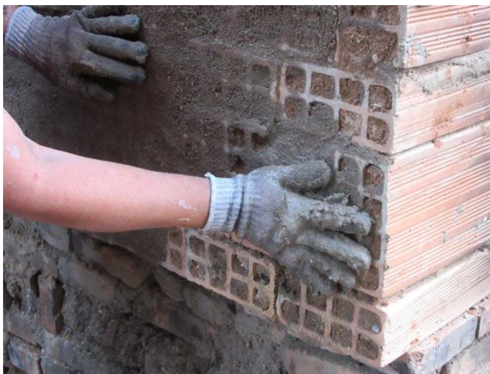
Figura 97: Reboco manual da parede do forno. Ritápolis, 2016.
