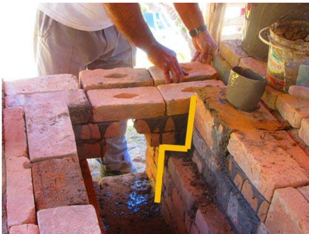
Figura 71: Detalhe do degrau interno que divide fornalha e braseiro. Resende Costa, 2016.
