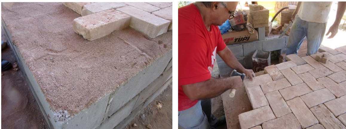
Figura 69: esquerda: detalhe do assentamento dos tijolos com areia, direita: Sr. Evandro Oliveira conferindo a amarração dos tijolos, Resende Costa, 2016.
