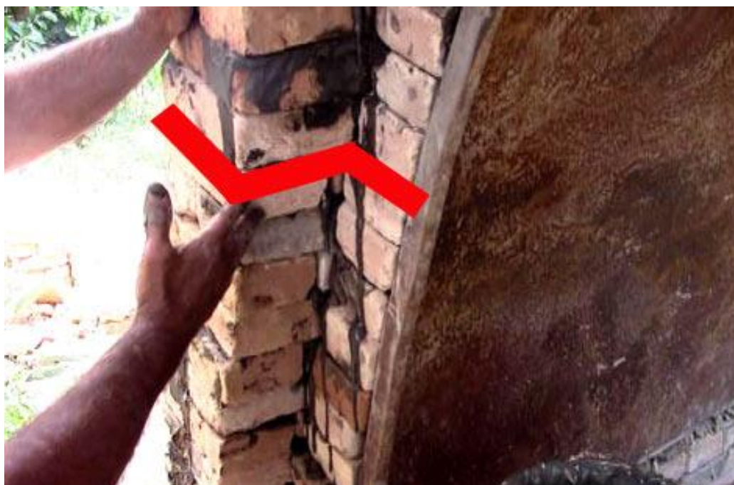
Figura 76: Degrau formado pela diferença no assentamento das camadas do arco. Resende Costa, MG, 2016.
