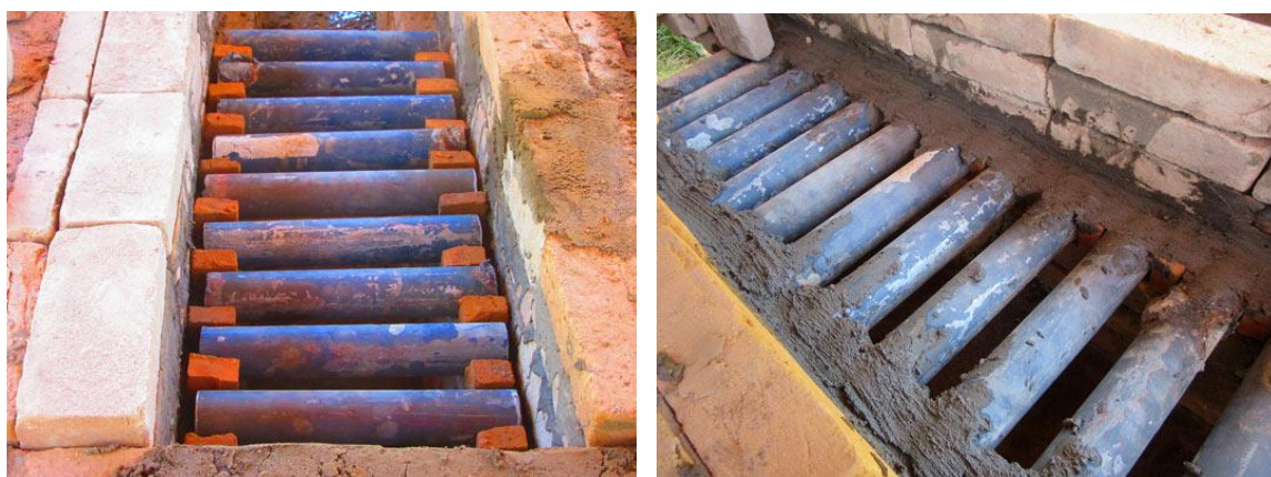
Figura 72: Esquerda: grelha montada com separação feita em tijolos, direita: grelha já rejuntada. Resende Costa, 2016.
