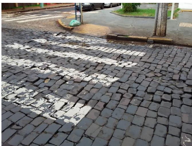
FIGURAS 22 e 23: Trechos degradados da pavimentação tombada da Avenida Nove de Julho. FONTE: Os autores, 2016.
