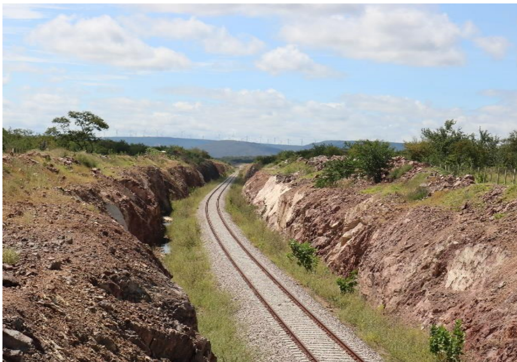
Figura 8 — Trecho 3 da Ferrovia Transnordestina em Juá (Curral Novo do Piauí, PI)
