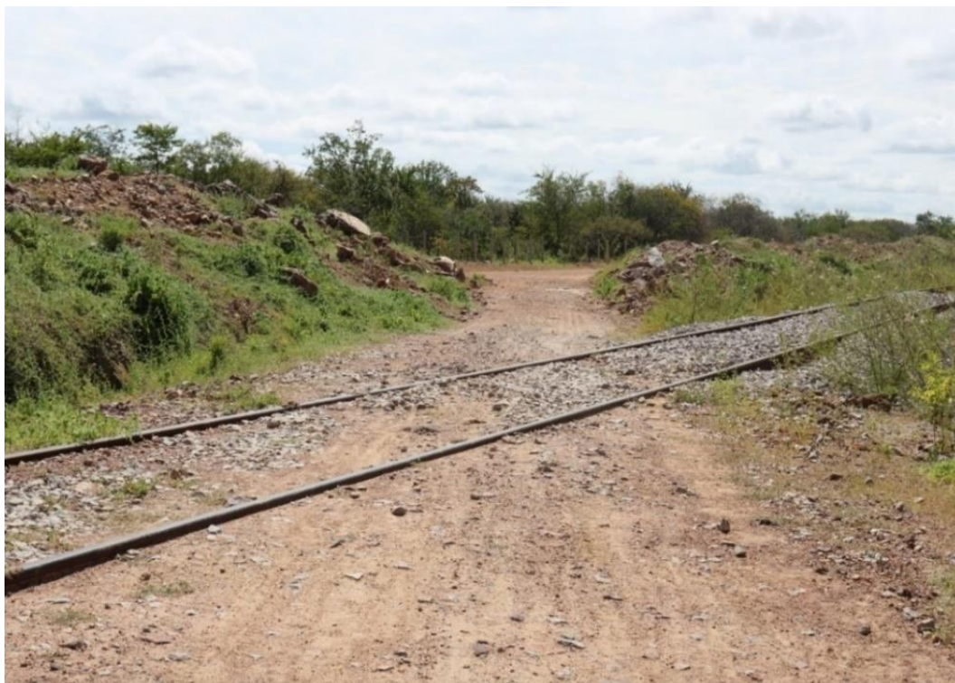
Figura 7 — Trecho 2 da Ferrovia Transnordestina em Caldeirãozinho (Paulistana, PI)
