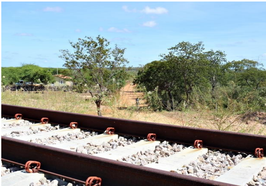
Figura 6 — Trecho 1 da Ferrovia Transnordestina em Caldeirãozinho (Paulistana, PI)
