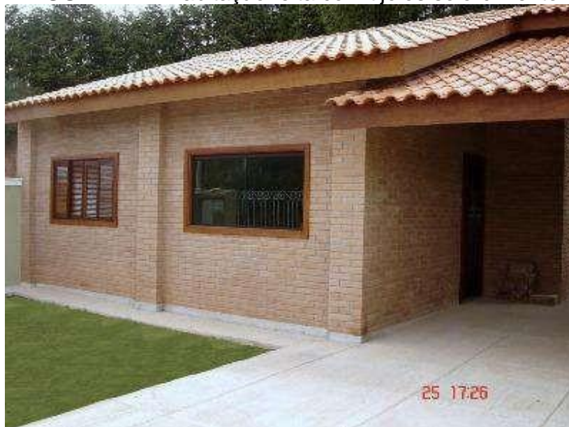
FIGURA 44 – Habitação feita com tijolos solo-cimento
