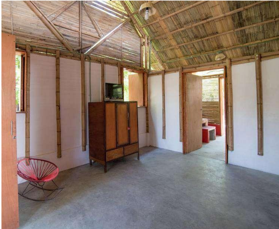
FIGURA 55 – Habitação feita utilizando técnica Pamacon
