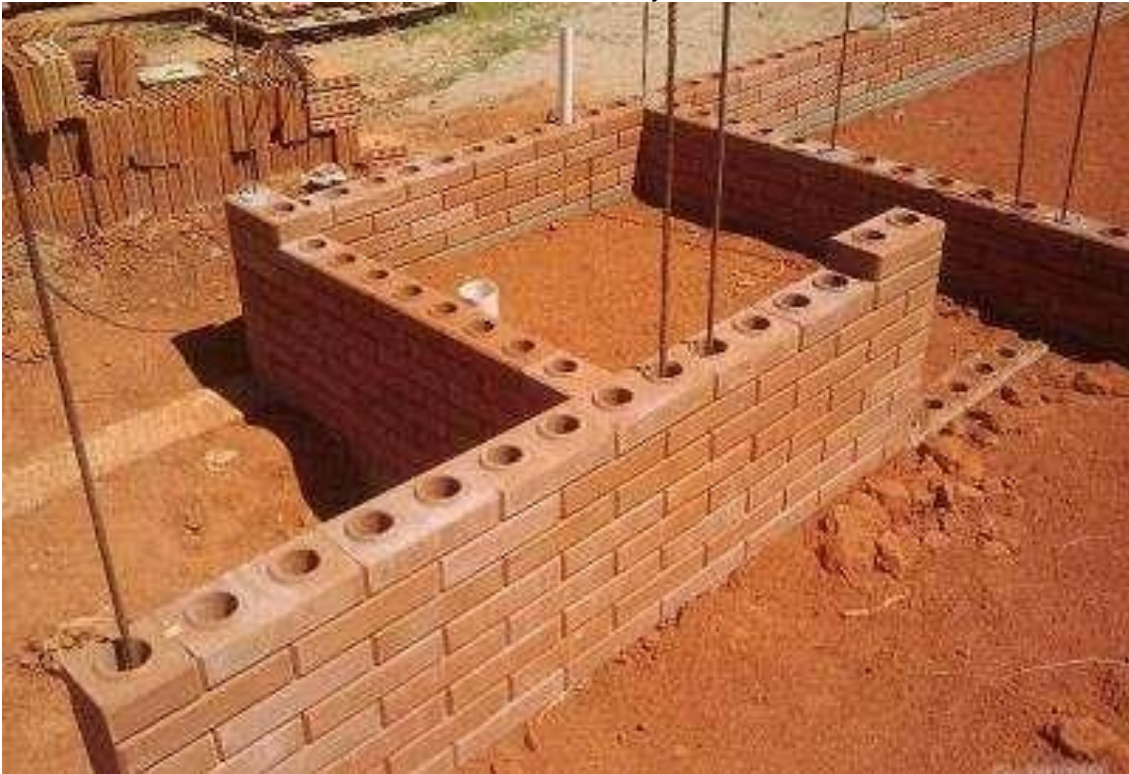
FIGURA 43 – Estrutura com tijolos solo-cimento
