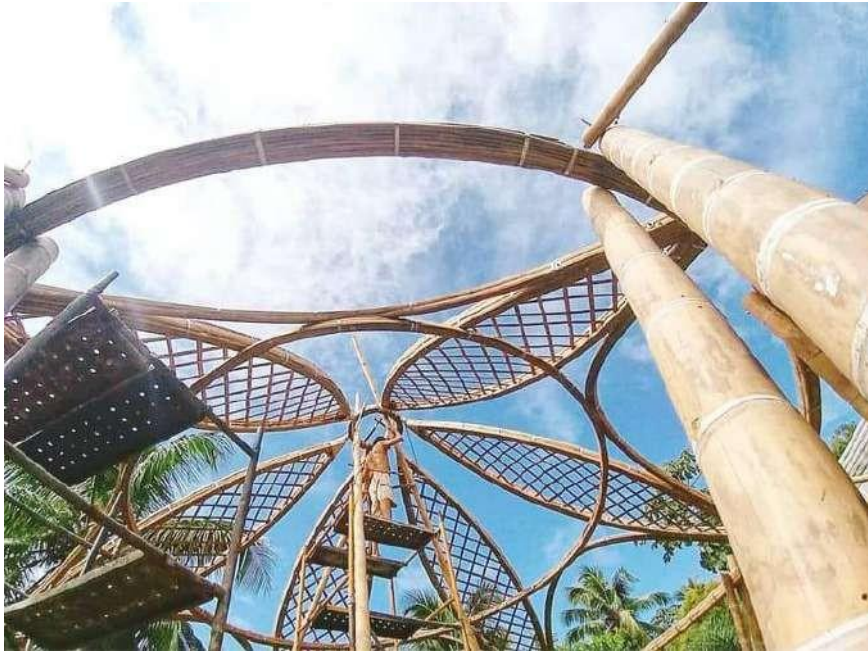
Figura 36 – Estrutura em bambu Eco centro Vila Flor
