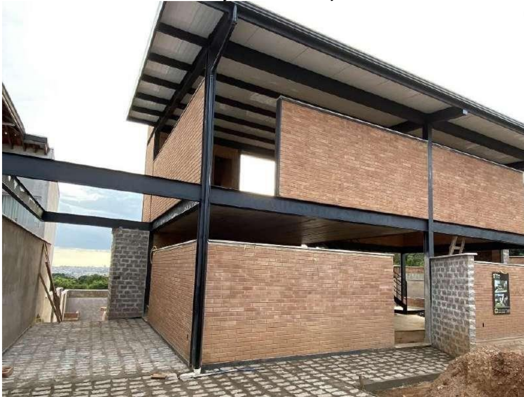
FIGURA 45 – Habitação feita com tijolos solo-cimento
