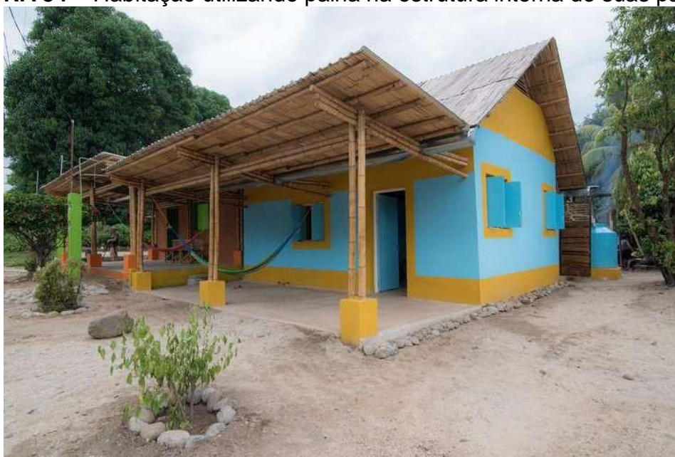
FIGURA 54 – Habitação utilizando palha na estrutura interna de suas paredes
