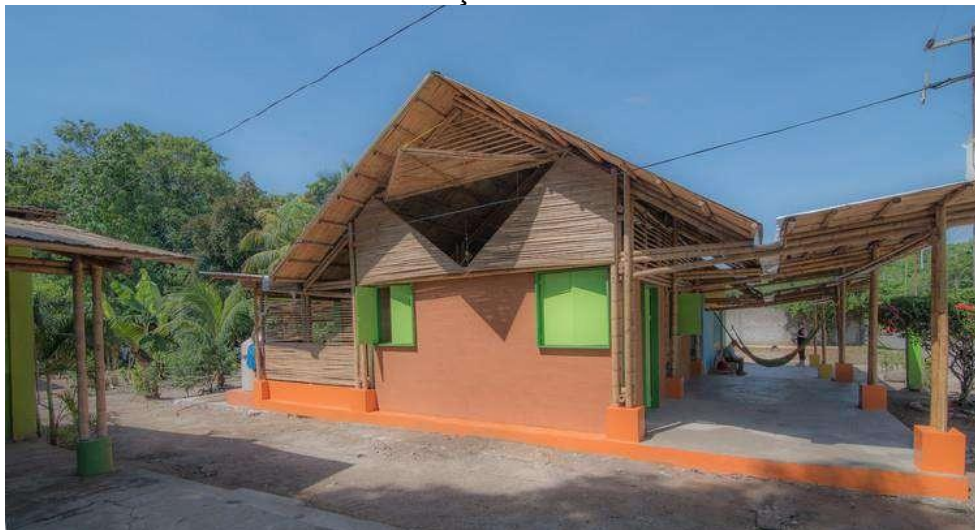
FIGURA 56 – Habitação feita utilizando técnica Pamacon e sistema de ventilação cruzada
