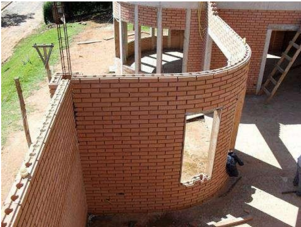
FIGURA 46 – Habitação feita com tijolos solo-cimento
