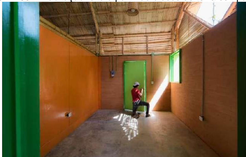
FIGURA 53 – Habitação feita a partir de blocos de terra compactada
