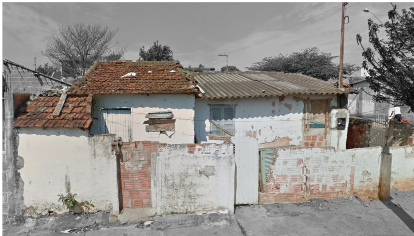
FIGURA 32: RESIDÊNCIA NA VILA ARRUDA II FONTE: IMAGEM DO GOOGLE E EDITADA PELA AUTORA.
