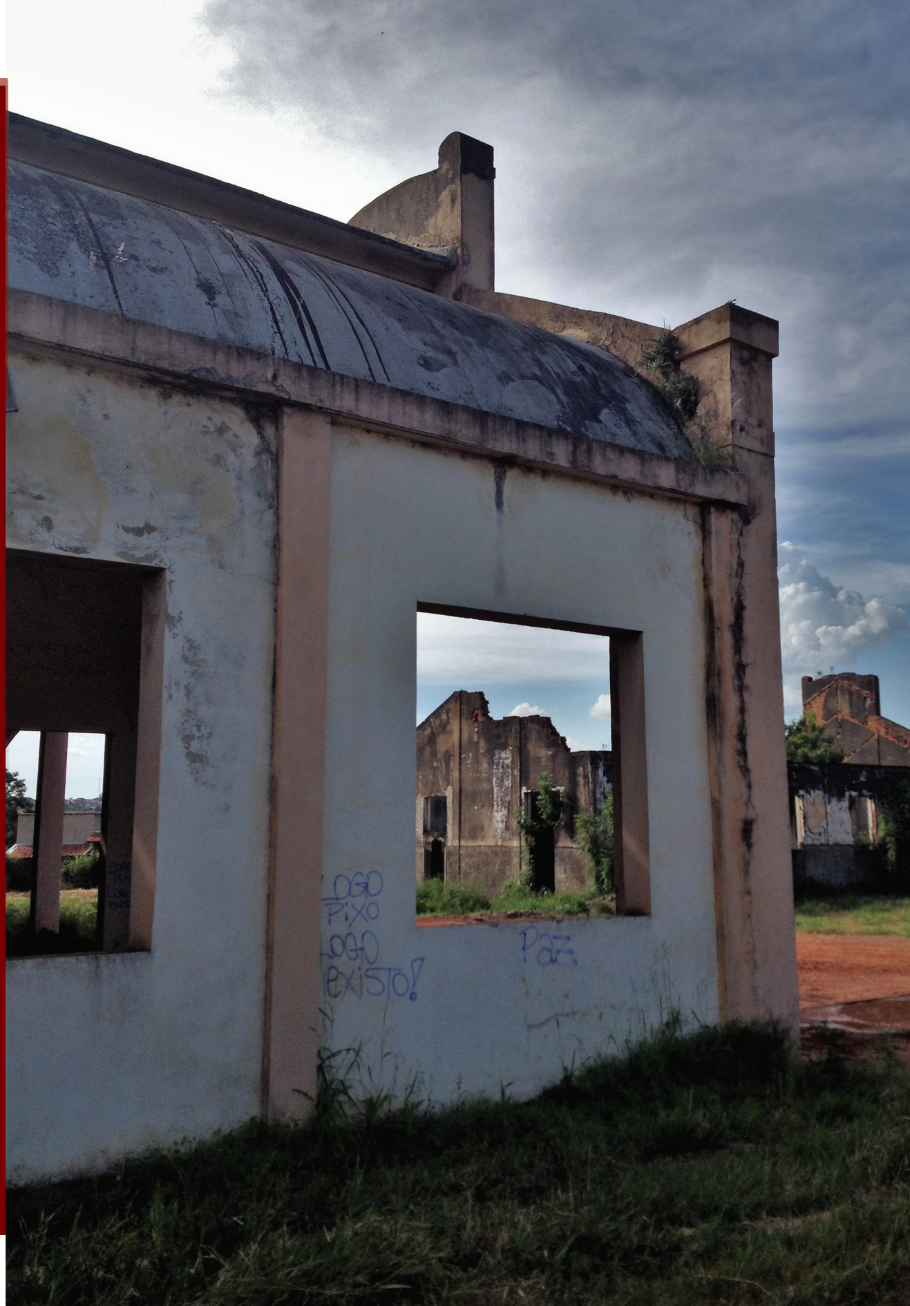
FIGURA 6: ELEVÇÃO LESTE COM ENQUA- DRAMENTO DA RUÍNA. FEV. 2016_A CERVO PESSOAL
