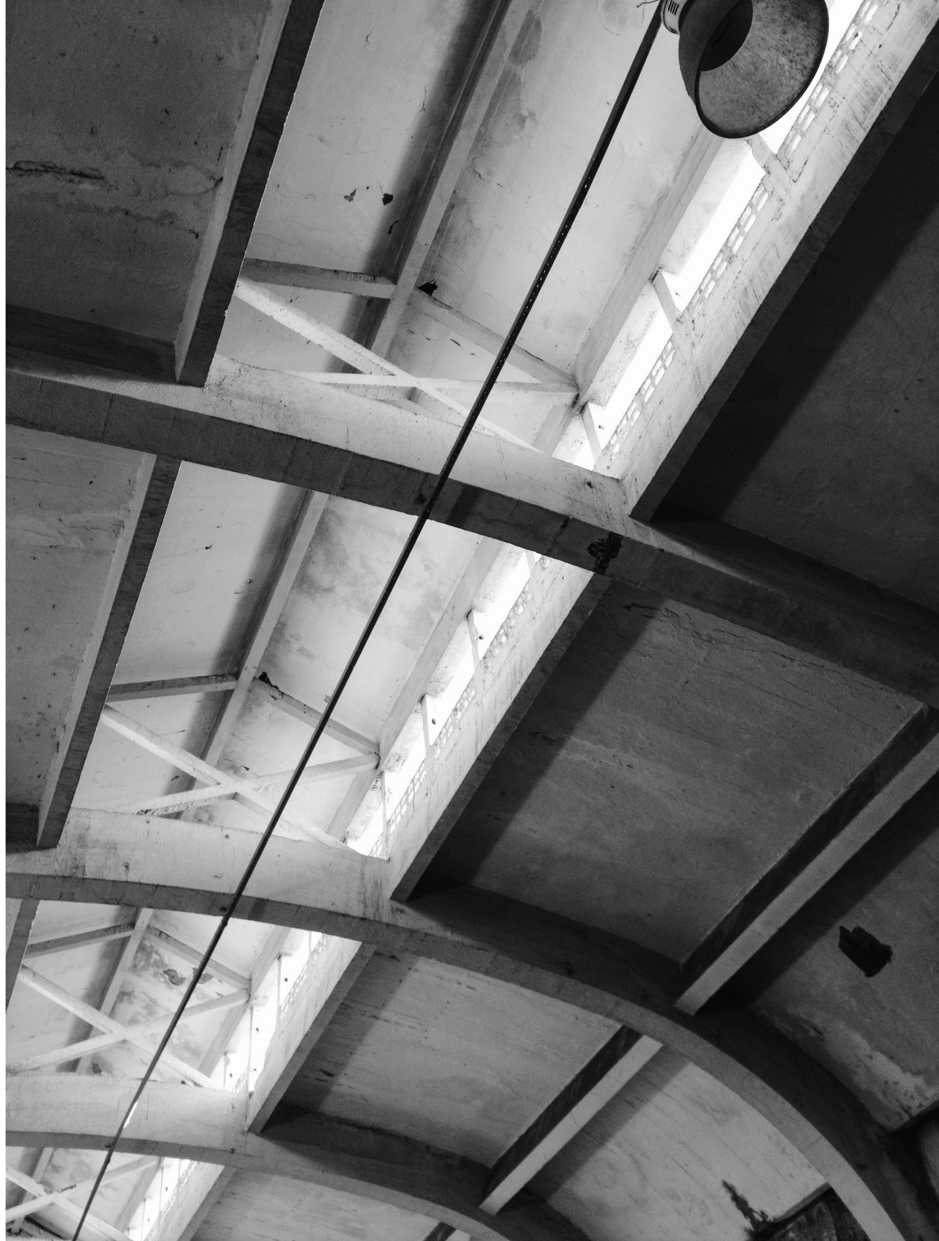
FIGURA 5: ESTRUTURA INTERNA SUPERIOR DA OFICINA; ÊNFASE PARA O RITMO DOS PÓRTICOS E GEOMETRIAS. FEV. 2016_ACERVO PESSOAL
