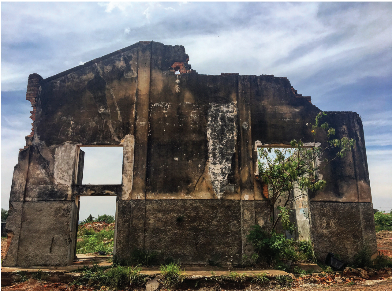
FIGURA 51: RUÍNAS, ELEVACÃO SUL OUT. 2016_ACERVO PESSOAL
