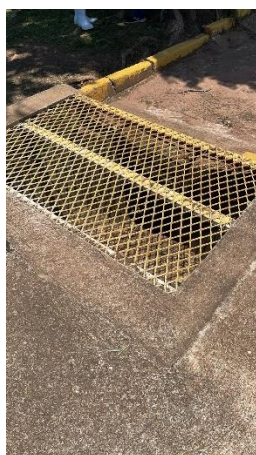
Figura 32 - Exemplo de grelha encontrada no campus de Marília
