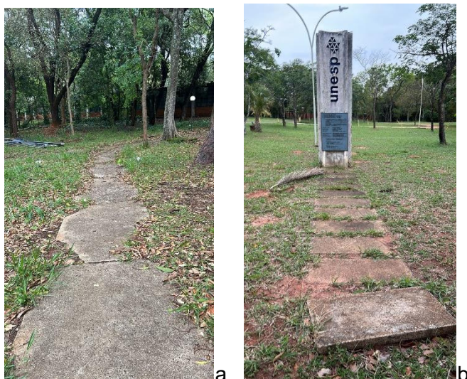
Figura 24 – Largura e manutenção dos passeios 109A e 129A no campus de Bauru
