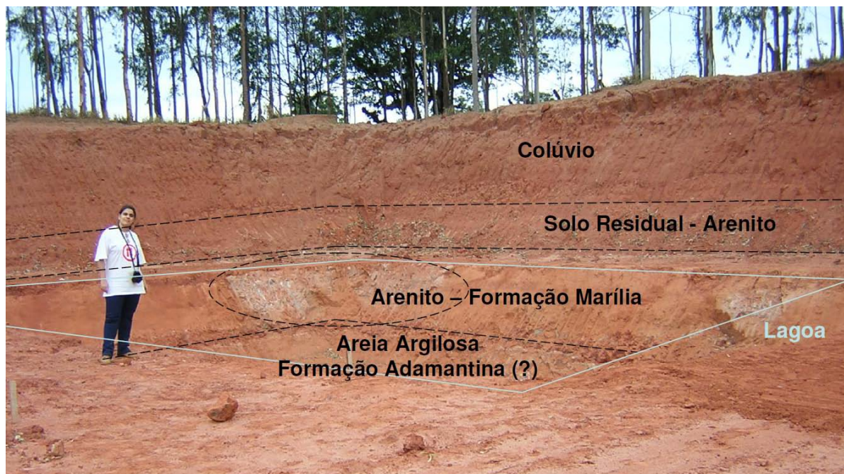
Figura 46: Vista geral da área escavada para o futuro armazenamento de chorume. Destaque para o perfil geológico mostrado através do talude, com continuidade para a área escavada da lagoa (MONDELLI, 2008).
