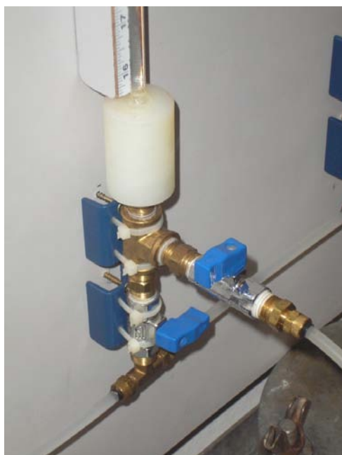
Figura 82 – Detalhe do conjunto de conexões acopladas ao tubo de carga através do adaptador de nylon.
