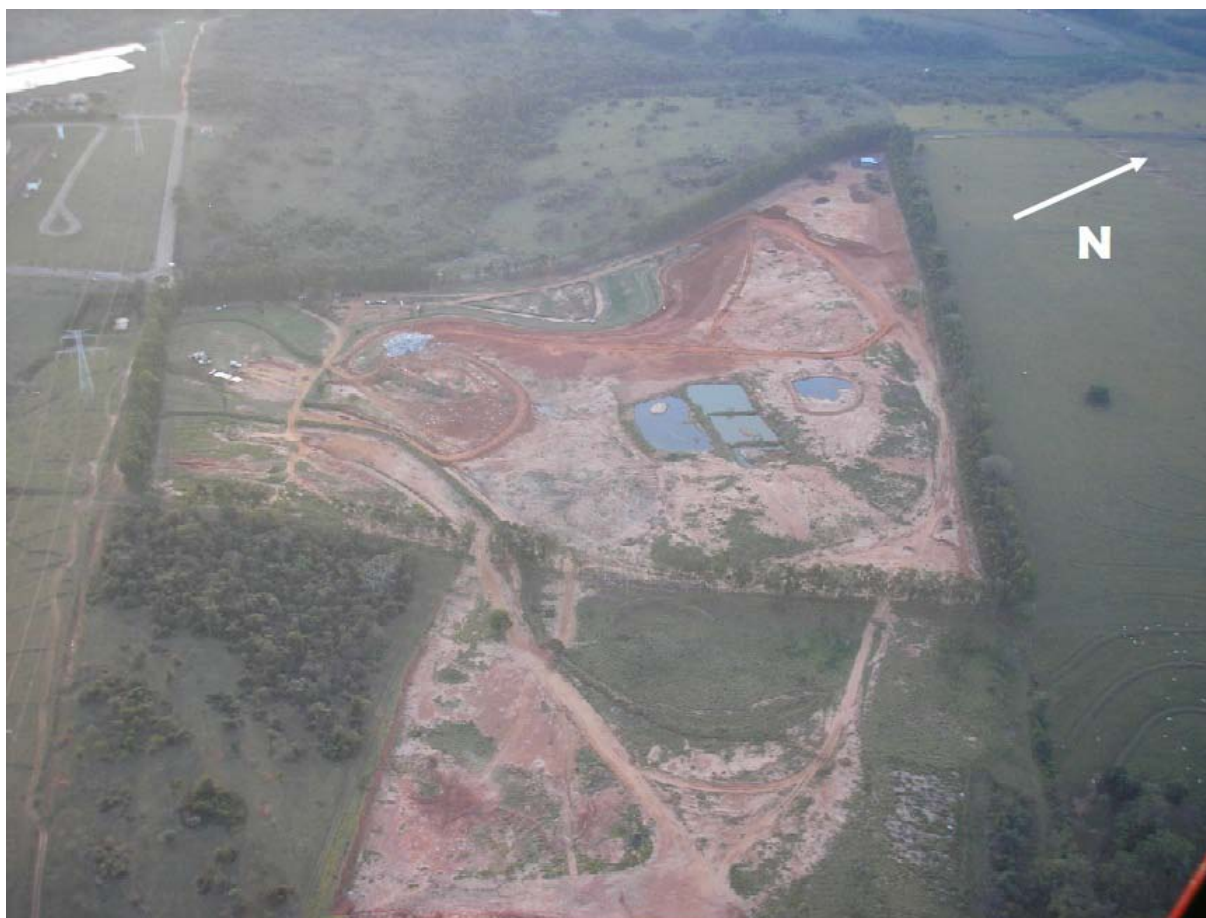
Figura 39 – Vista aérea do aterro de RSU de Bauru de 2006 (MONDELLI, 2008).
