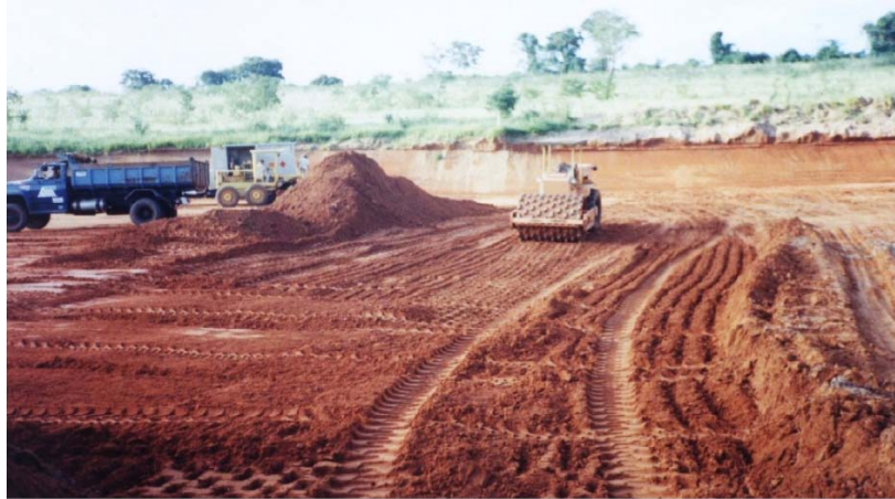
Figura 36 – Compactação de base do aterro de RSU de Bauru (MONDELLI, 2008).
