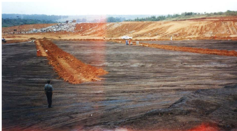
Figura 37 – Imprimação betuminosa da base do aterro de RSU de Bauru (MONDELLI, 2008).
