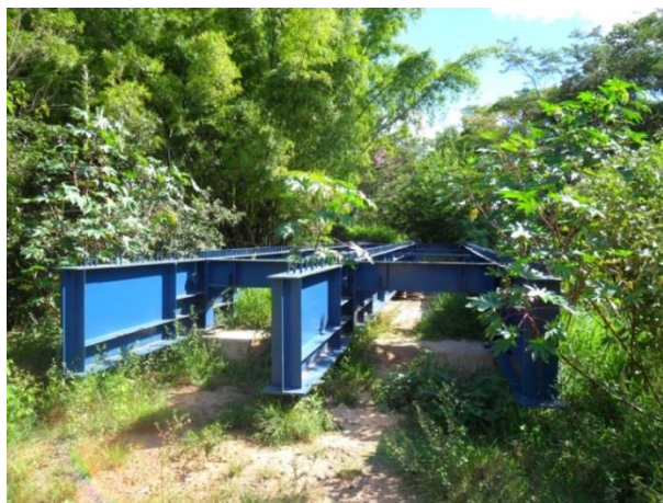
Figura 14 - Vigas de aço USI-SAC-50 Fonte: Trabalho de Campo, 2014.
