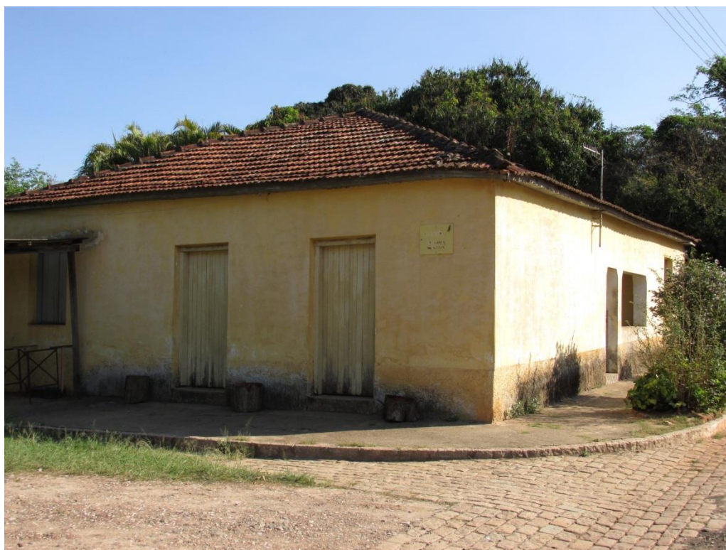
Figura 9 - Casa antiga (Construção original do bairro) Fonte: Trabalho de Campo, 2016.
