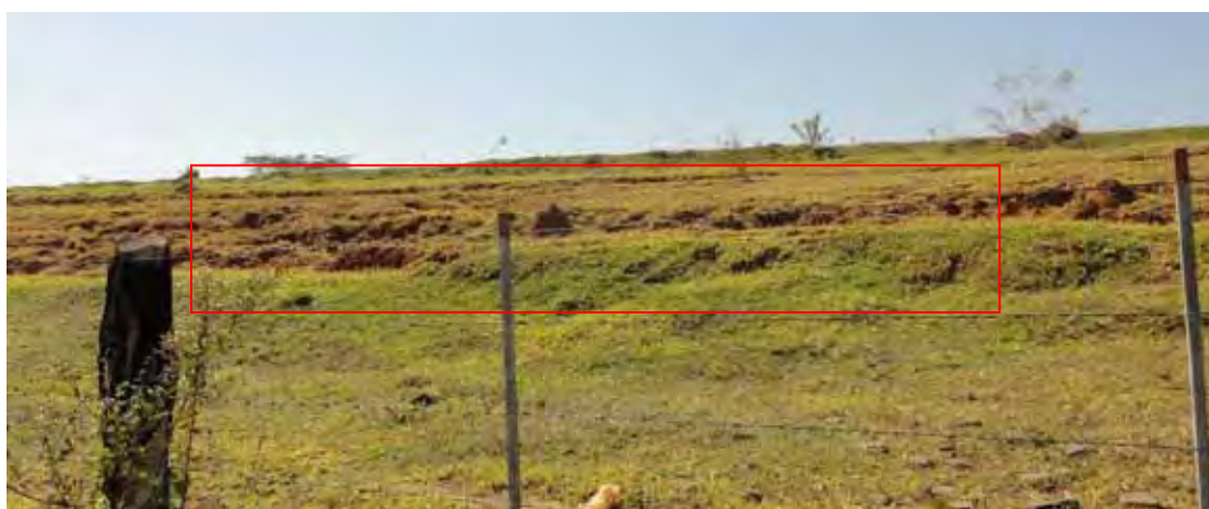
Figura 28 – Processos erosivos na unidade C
