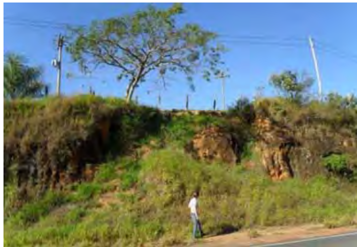
Figura 26 – Cicatriz de escorregamento derivado de cortes antrópicos para construção de estradas
