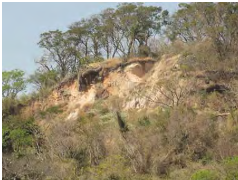
Figura 29 – Cicatriz de escorregamento no alto da encosta em relevo montanhoso
