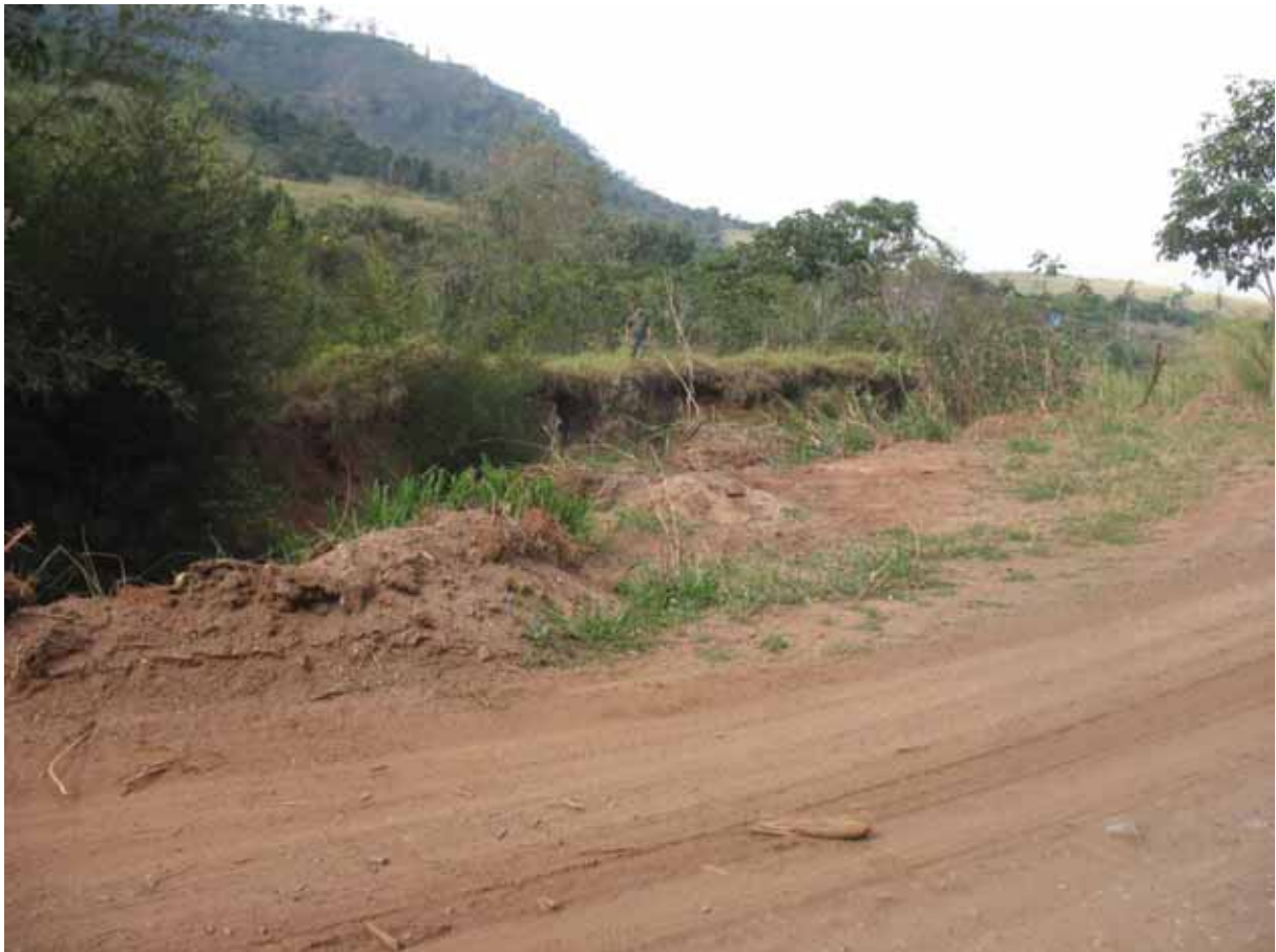
Foto 26. Voçoroca na margem direita da estrada. (Ponto 21)
