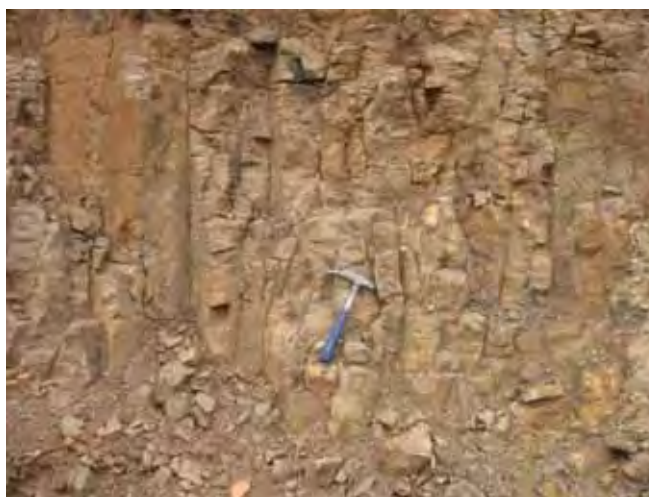
Foto 8. Basalto muito alterado e fraturado em talude da estrada CHQ-040) (Ponto 10).
