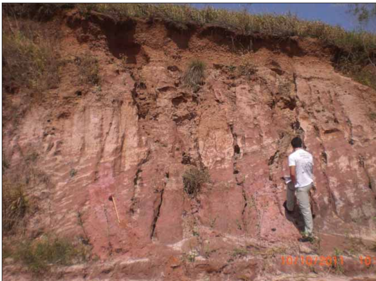
Foto 23. Erosões hídricas (Sulcos) em arenitos da Formação Pirambóia exposto em talude. (Ponto 3)
