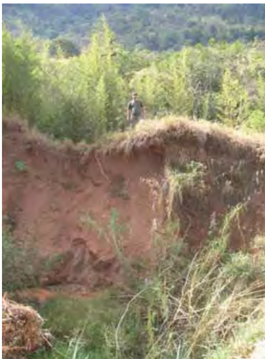
Foto 27. Voçoroca na margem direita da estrada CHQ-040. (Ponto 21)
