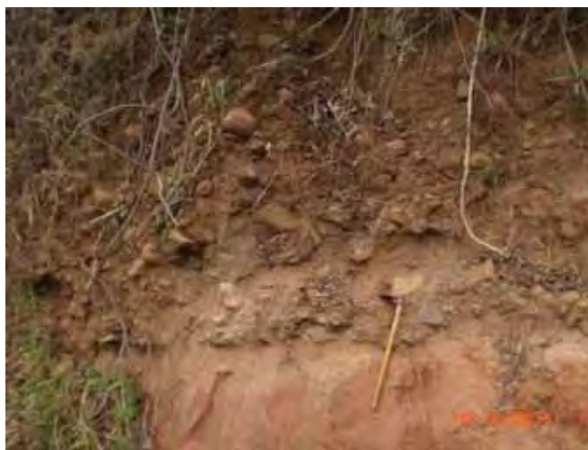
Foto 14. Talude da estrada expondo tálus contendo fragmentos centimétricos a decimétricos de rocha sobreposto a arenitos rosados da Formação Pirambóia (Ponto 5).
