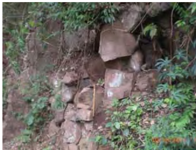
Foto 13. Talude de estrada exibindo arenitos da Formação Botucatu (Unidade 3), bastante cimentados e fraturados. Blocos sujeitos a queda. (Ponto 22).
