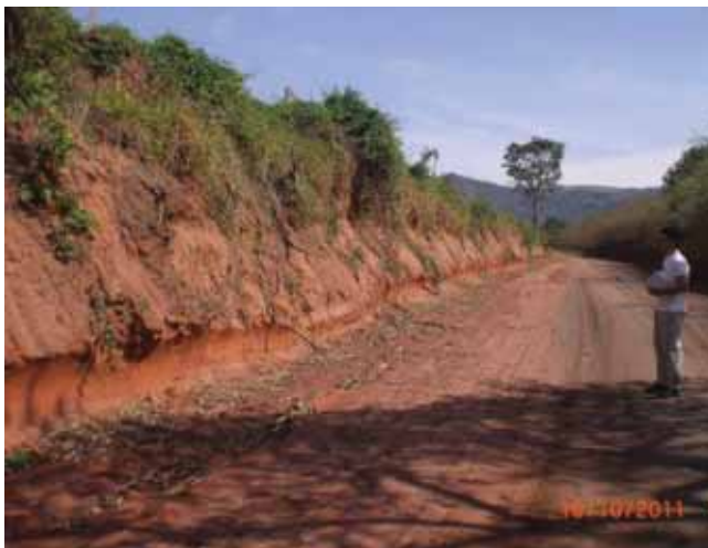
Foto 29. Colúvio exposto em talude de aproximadamente 2,5m, na estrada (CHQ-040). (Ponto 2)
