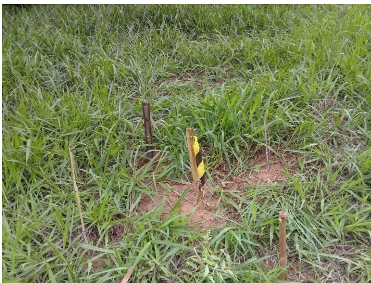
Figura 43 - Sinalização das estacas com fita zebraada.
