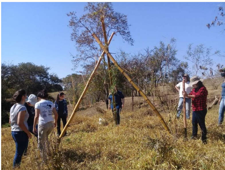
Figura 38 - Bambus amarrados e posicionados dentro das covas.
