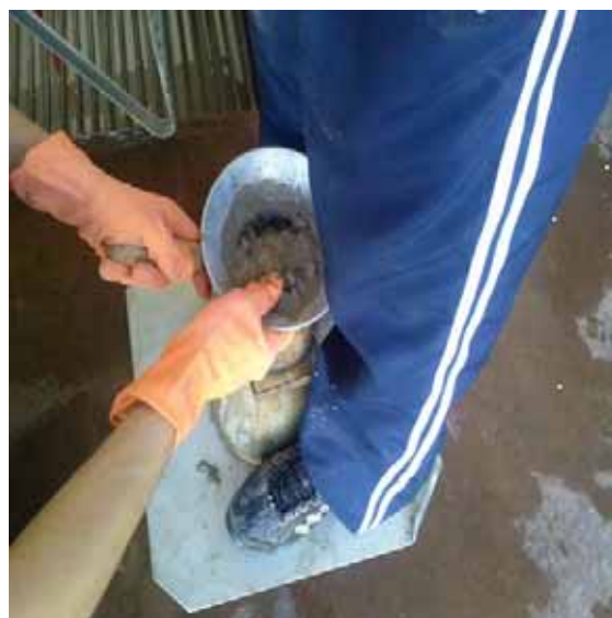
Figura 17 - Moldagem do concreto
