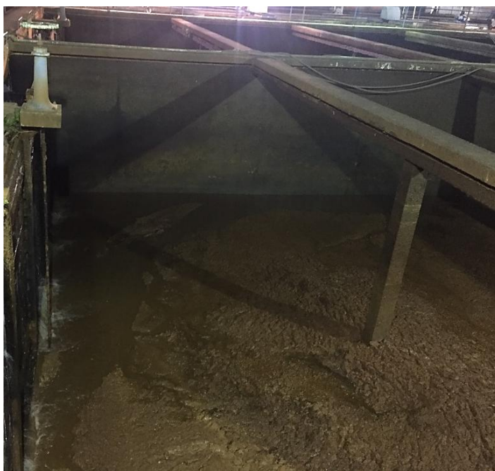
Figura 7 - Lodo sendo retirado durante a lavagem do decantador da ETA I
