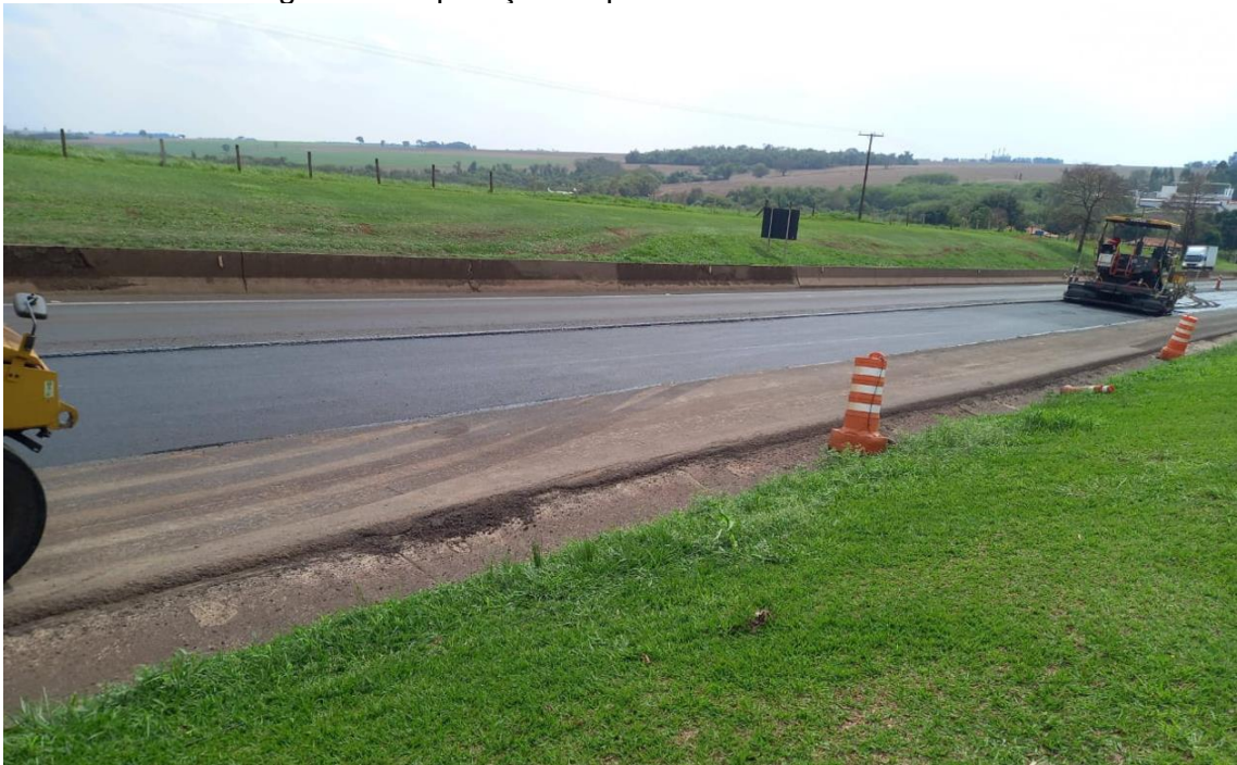
Figura 36 - Aplicação da primeira camada de CBUQ
