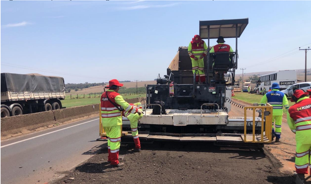
Figura 33 - Aplicação da segunda camada de asfalto espuma na camada de base
