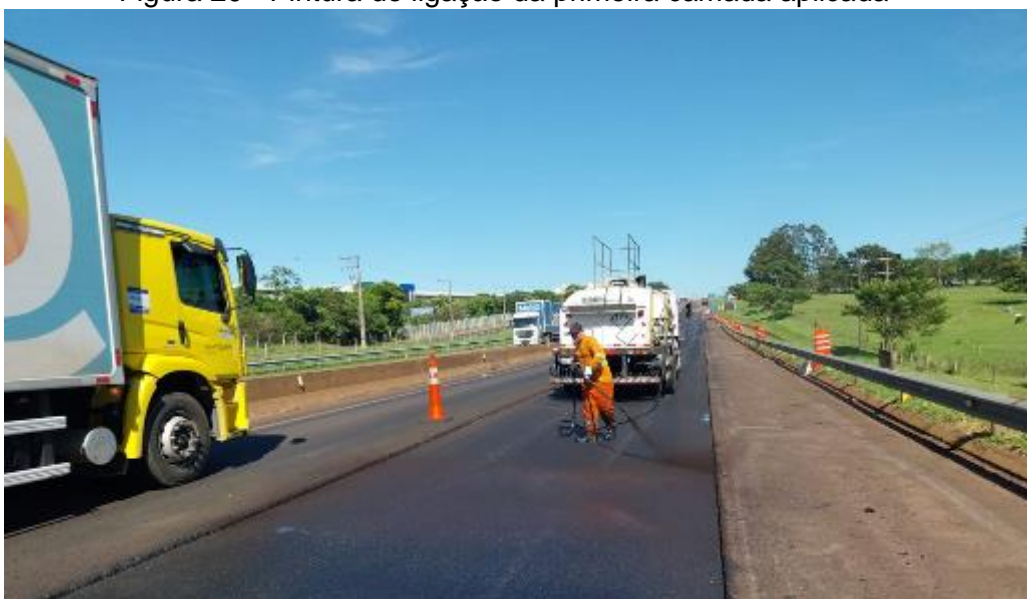
Figura 20 - Pintura de ligação da primeira camada aplicada
