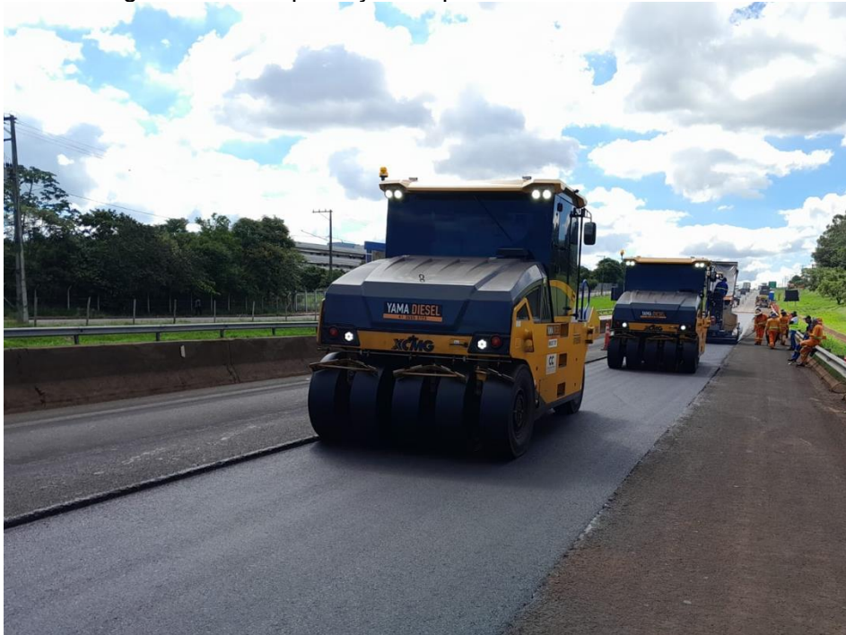
Figura 19 - Compactação da primeira camada de CBUQ
