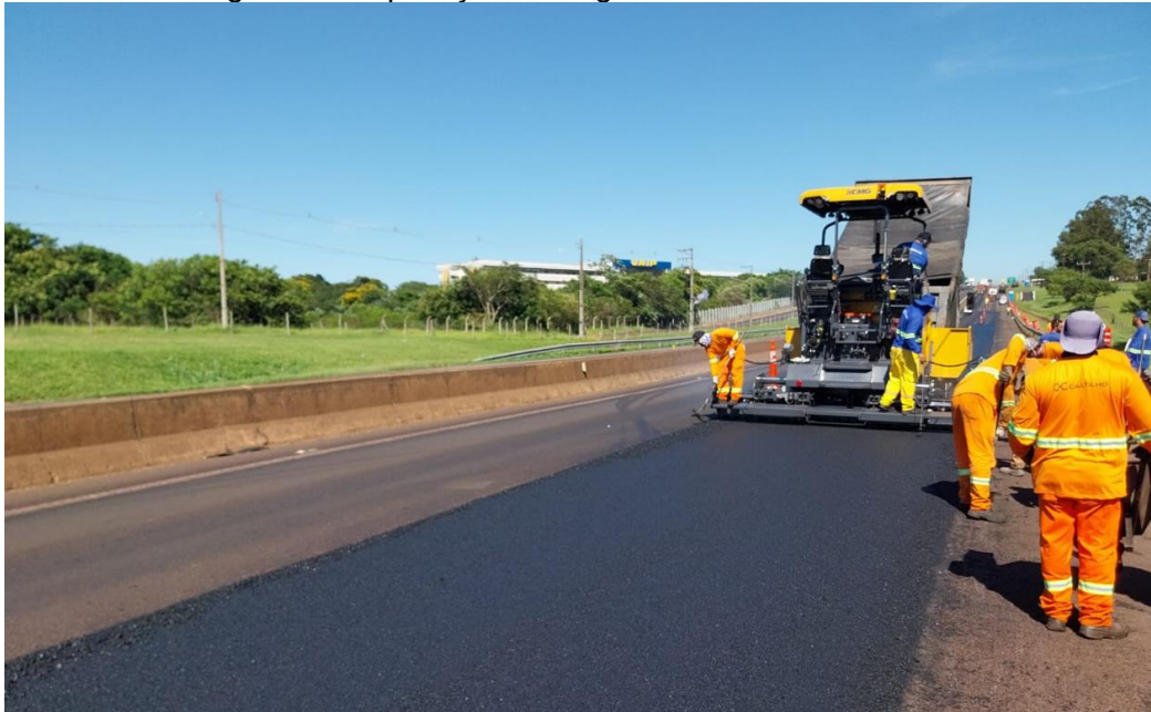
Figura 21 - Aplicação da segunda camada de CBUQ
