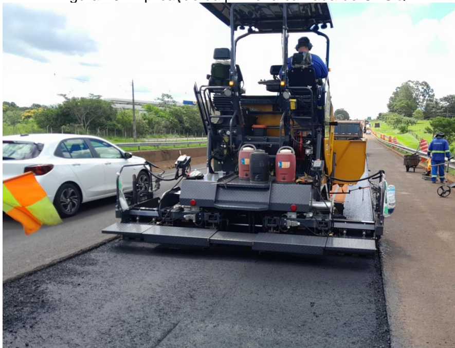
Figura 18 - Aplicação da primeira camada de CBUQ
