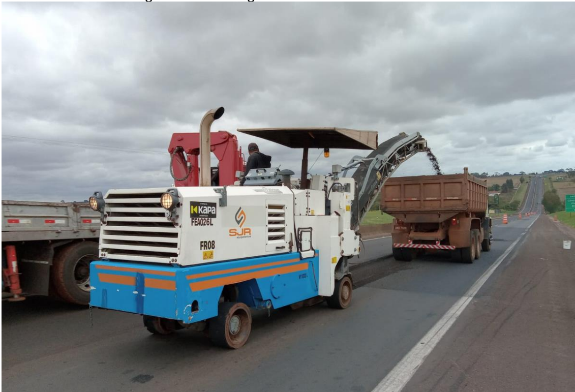
Figura 23 - Fresagem do revestimento asfáltico
