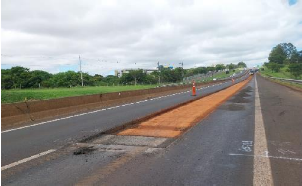
Figura 12 - Fresagem do pavimento
