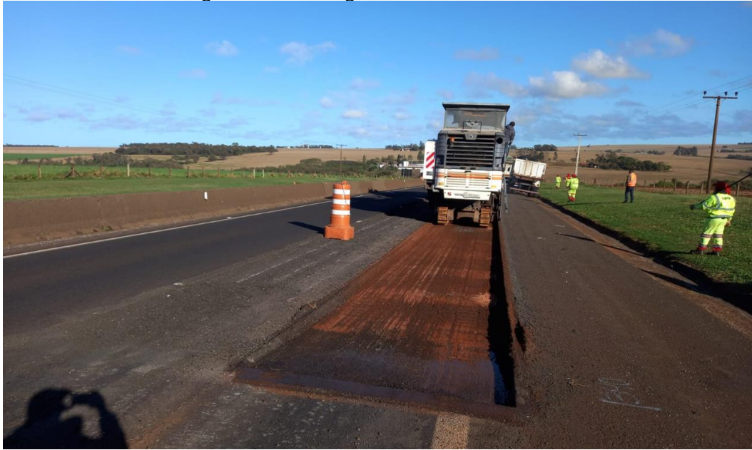
Figura 24 - Fresagem da camada de base
