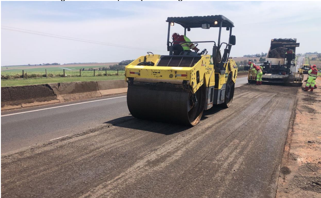
Figura 34 - Compactação da segunda camada de base
