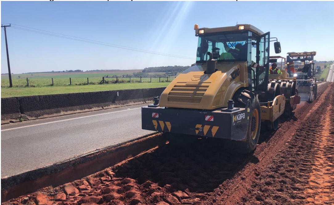
Figura 28 - Compactação de sub-base com rolo pé de carneiro
