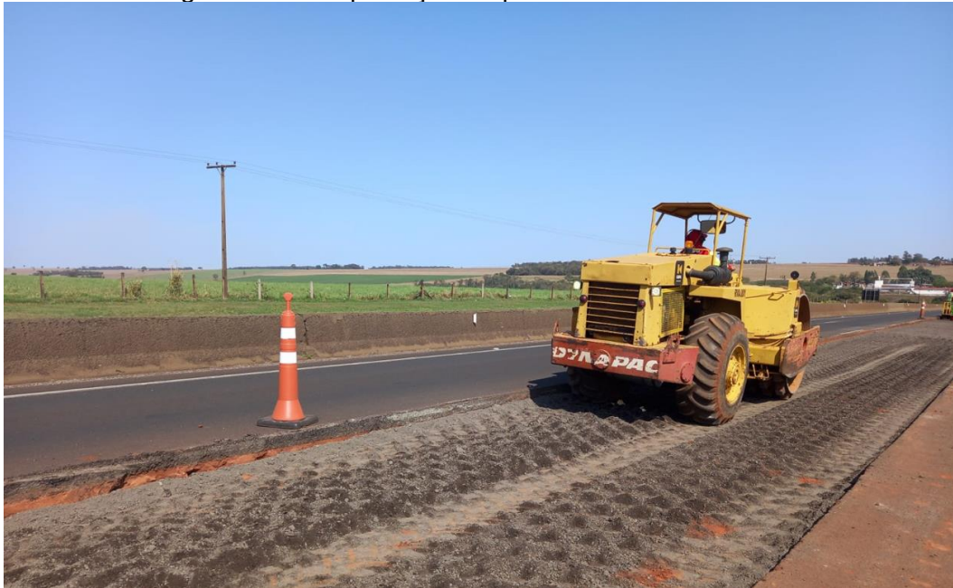
Figura 32 - Compactação da primeira camada de base
