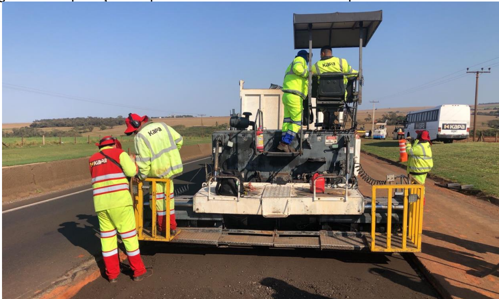
Figura 31 - Aplicação da primeira camada de asfalto espuma na camada de base
