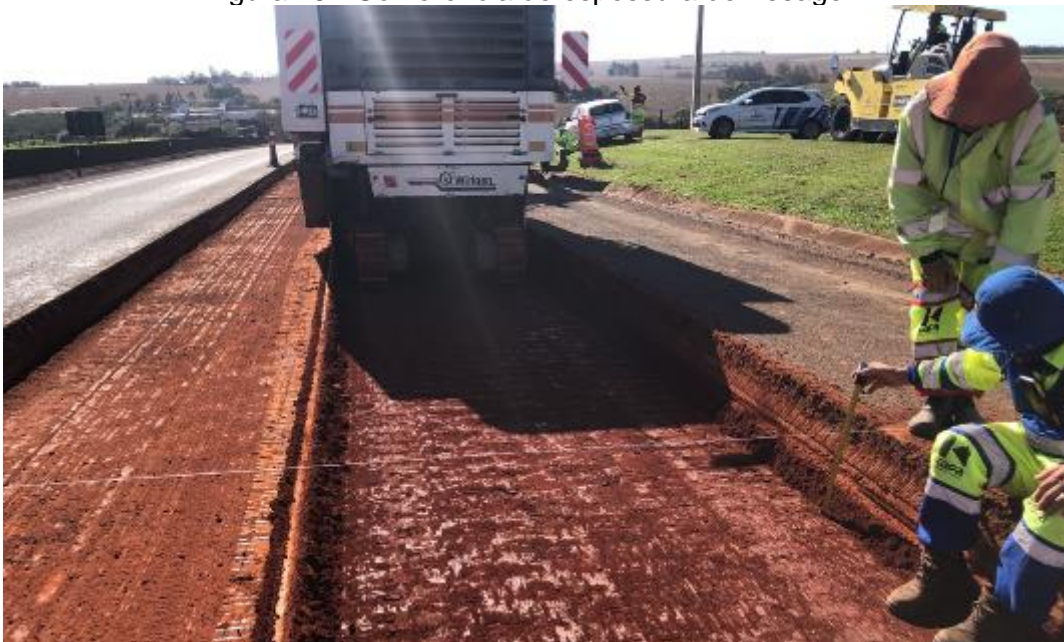
Figura 25 - Conferência de espessura de fresagem
