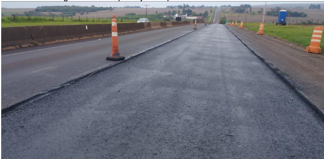
Figura 37 - Compactação da primeira camada de CBUQ
