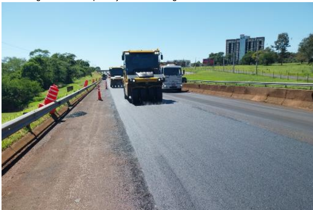
Figura 22 - Compactação final da segunda camada de CBUQ
