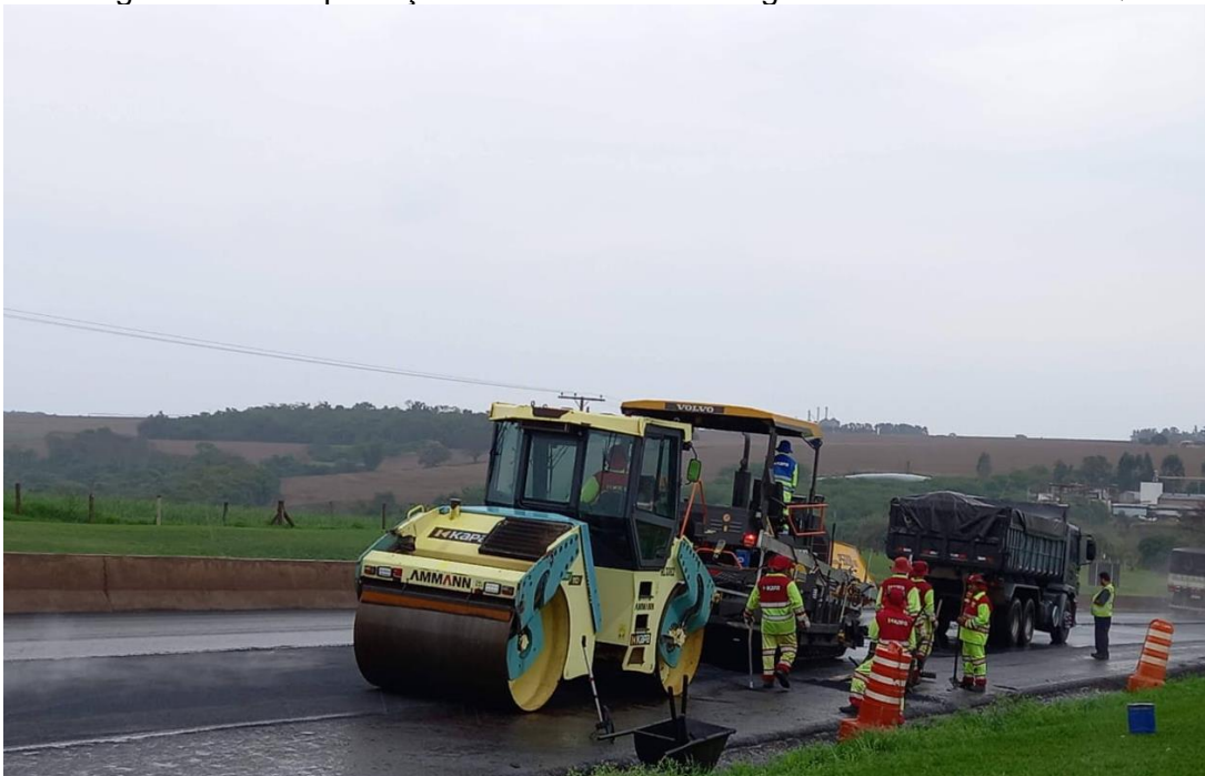
Figura 39 - Compactação e acabamento da segunda camada de CBUQ
