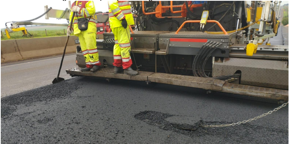
Figura 38 - Aplicação da segunda camada de CBUQ
