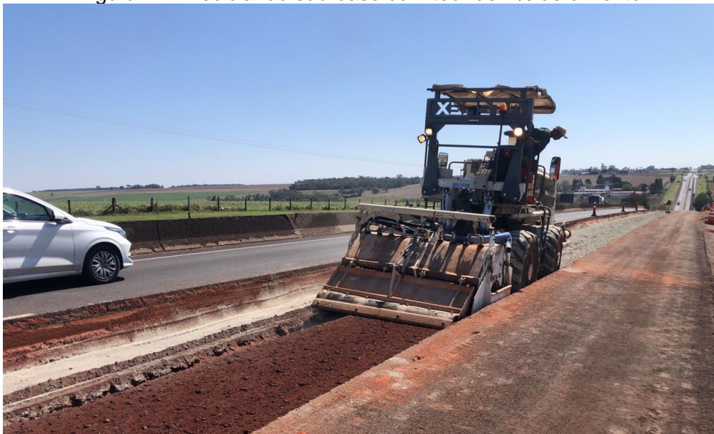
Figura 27 - Reciclando sub-base com teor de 4% de cimento
