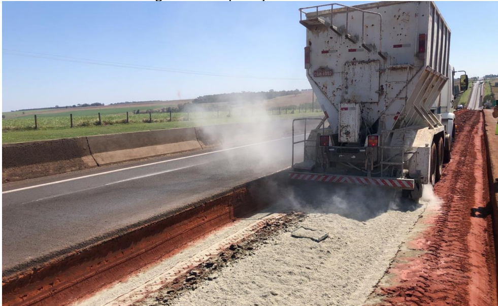
Figura 26 - Aplicação de cimento
