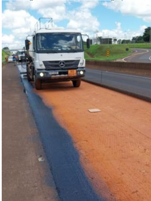
Figura 15 - Pintura de ligação
