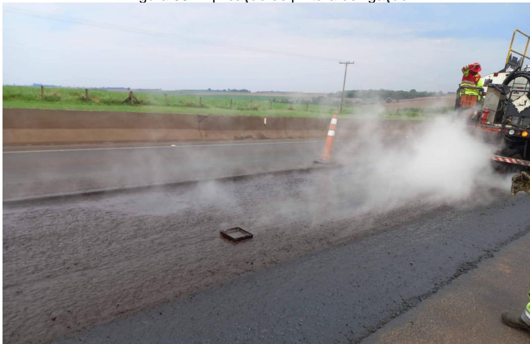
Figura 35 - Aplicação de pintura de ligação
