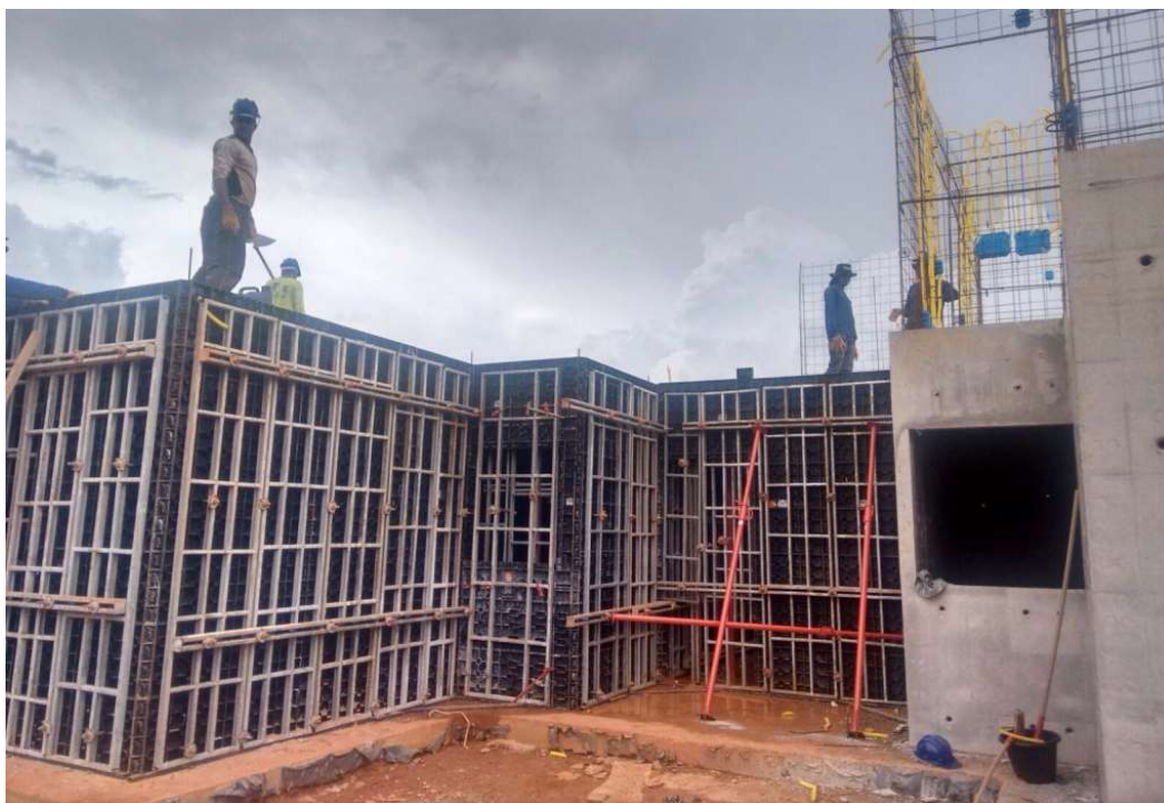
Figura 1 – Obra com sistema de paredes de concreto moldadas in loco .
