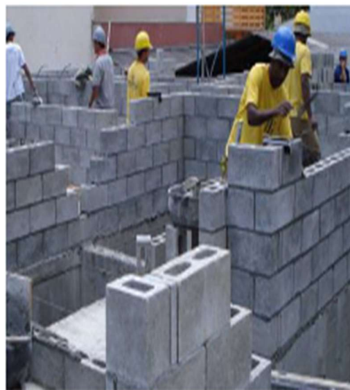
Figura 8 – Parede em alvenaria estrutural. (a) desenho esquemático. (b) foto de obra.
