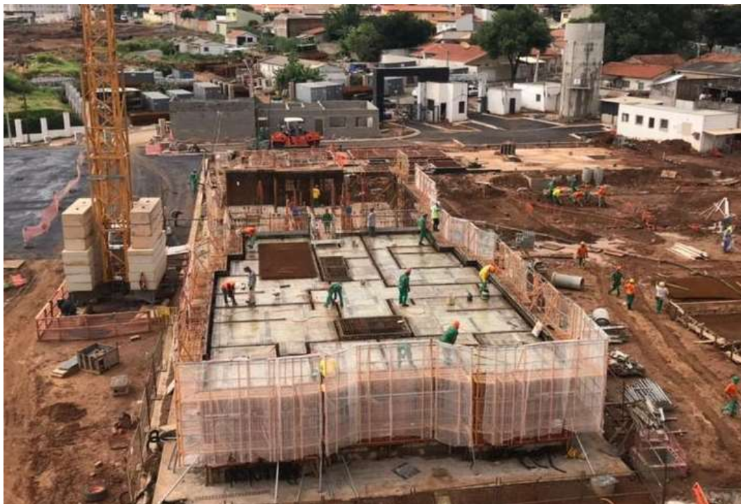
Figura 16 – Montagem da Laje da obra analisada: Vista superior.
