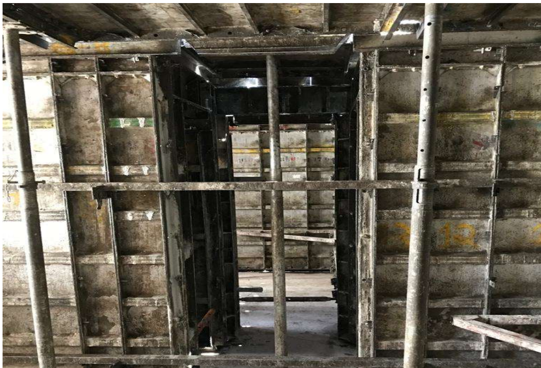
Figura 14 – Formas internas da obra analisada montadas e com os travamentos.
