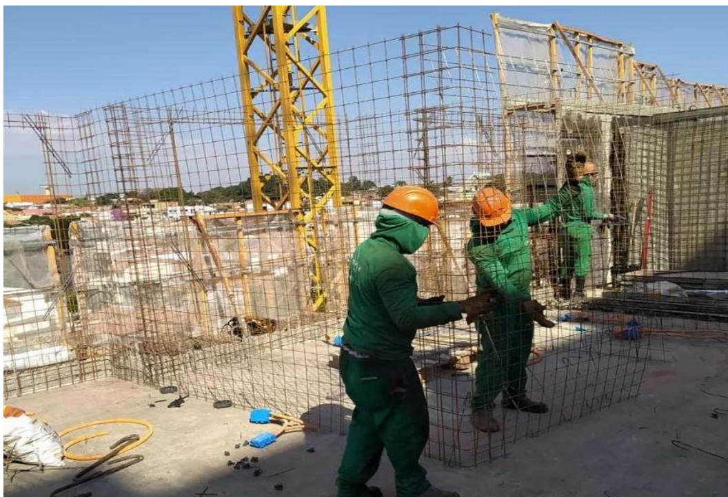
Figura 12 - Montagem da “Gaiola” da obra analisada: Vista frontal.
