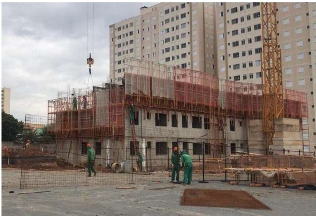
Figura 10 - Montagem da Fachada da obra analisada: vista frontal.
