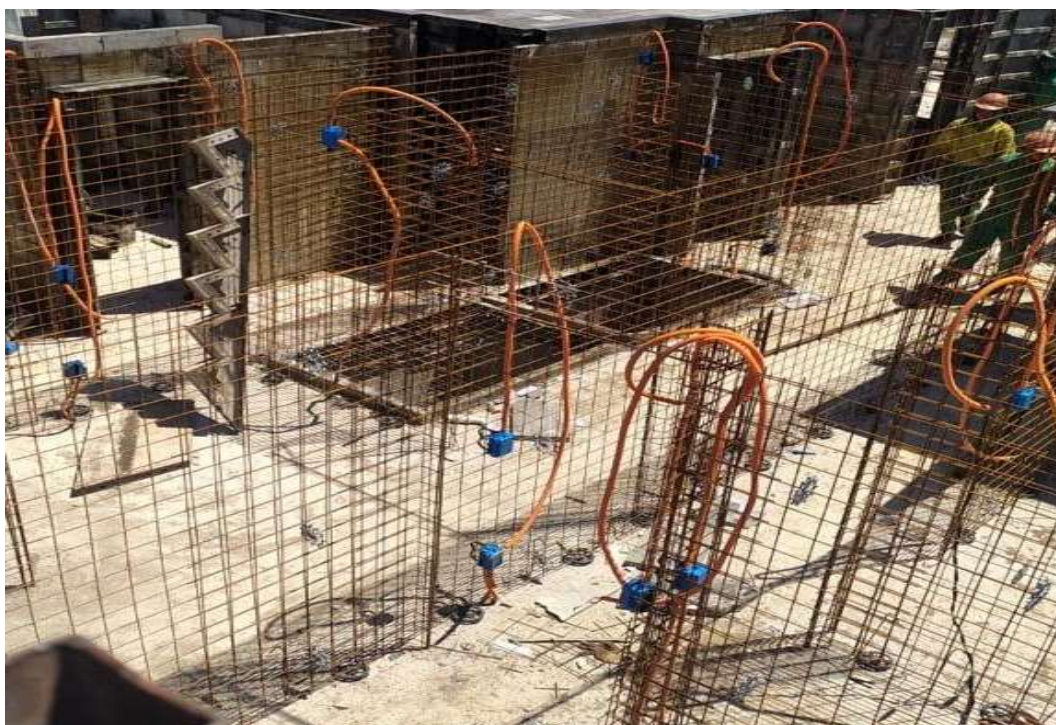
Figura 13 - Montagem da “Gaiola” da obra analisada: Vista superior.
