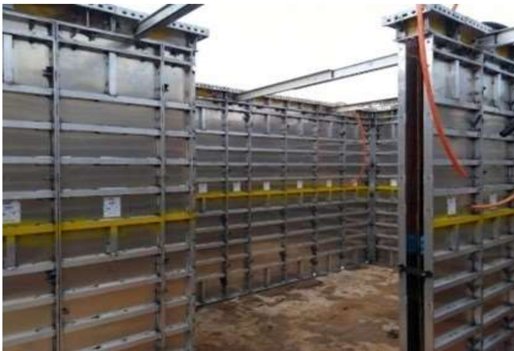
Figura 3 - Moldes para concretagem de parede de plástico.
