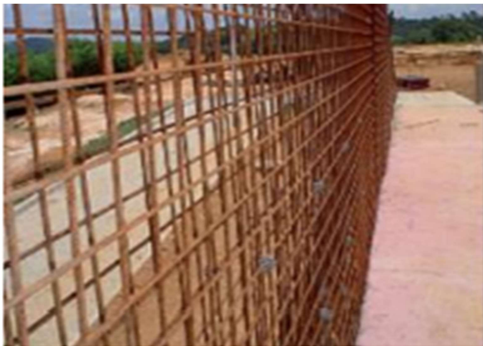
Figura 6 – Armaduras utilizada em paredes de concreto: Aço em telas eletrossoldadas.
