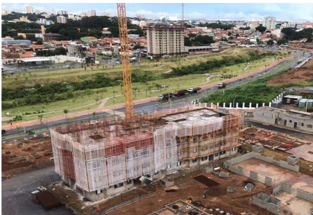
Figura 11 - Montagem da Fachada da obra analisada: Vista superior.
