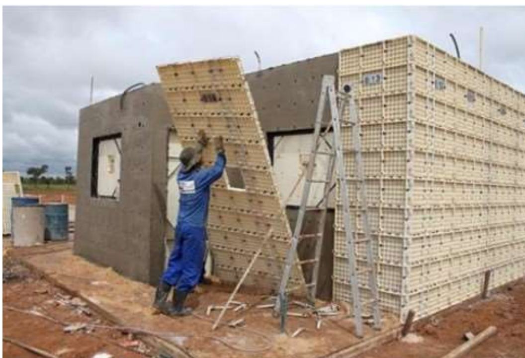
Figura 2 - Moldes para concretagem de parede de plástico.
