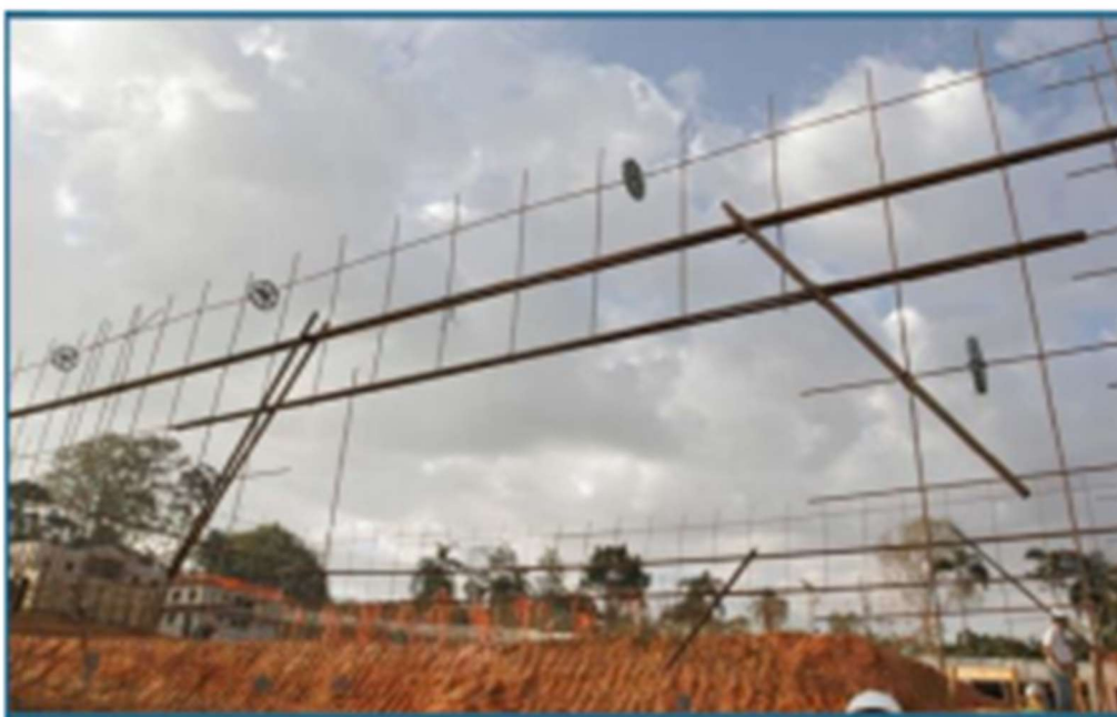
Figura 5 – Armaduras utilizada em paredes de concreto: Aço em barra.
