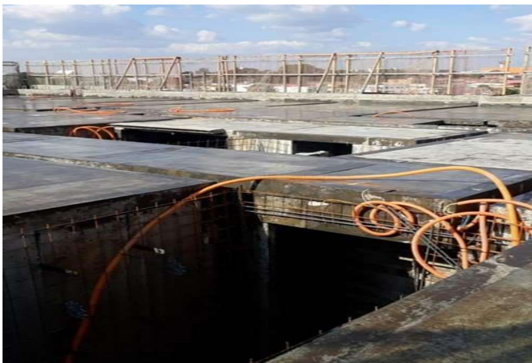
Figura 17 – Montagem da Laje da obra analisada: Vista frontal.
