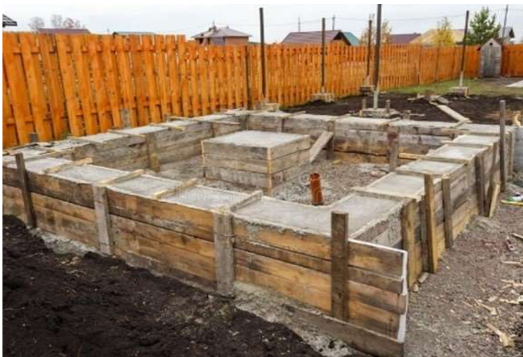
Figura 4 - Moldes para concretagem de parede de madeira.
