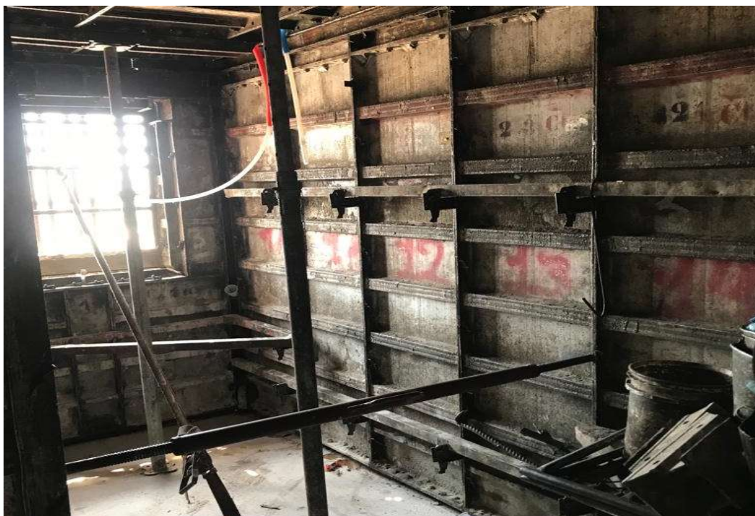
Figura 15 – Formas internas montadas com os travamentos e acessórios.
