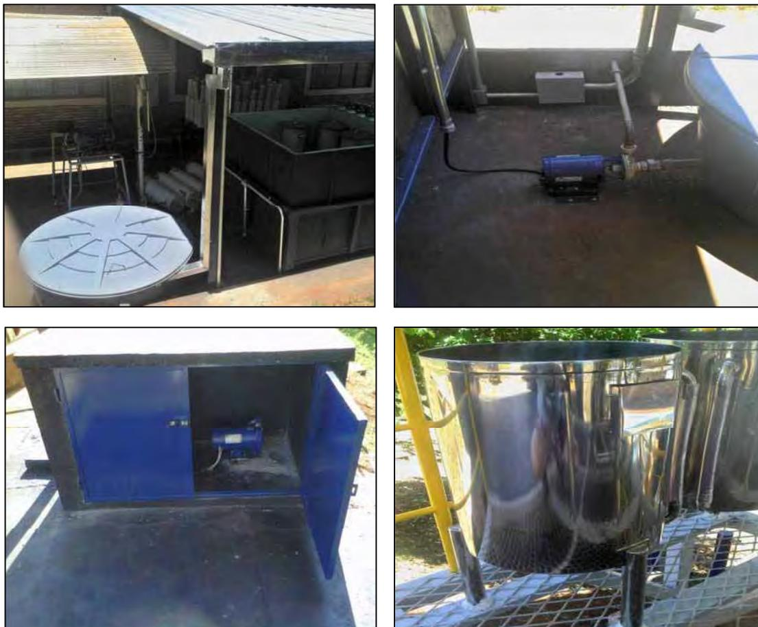
Apêndice 5. Sistema de coleta de água de chuva para utilização na diluição de CF, constituída de tanque de 1.000 litros, 9 metros de calha de coleta de água de chuva, 1 (uma) bomba de 0,75 cv., de transferência de água, para 2 (dois) reservatórios de 90 litros cada, fabricados em aço inox 306, os quais possuem 1 (uma) bomba de transferência de água, com motor de 1 cv tanques de aço inox 306.
