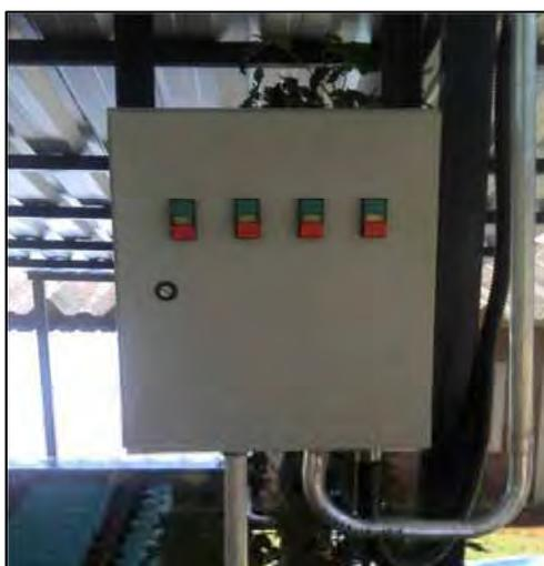
Apêndice 6. Painel de comando, responsável pelo acionamento e proteção dos motores, dos equipamentos citados acima.
