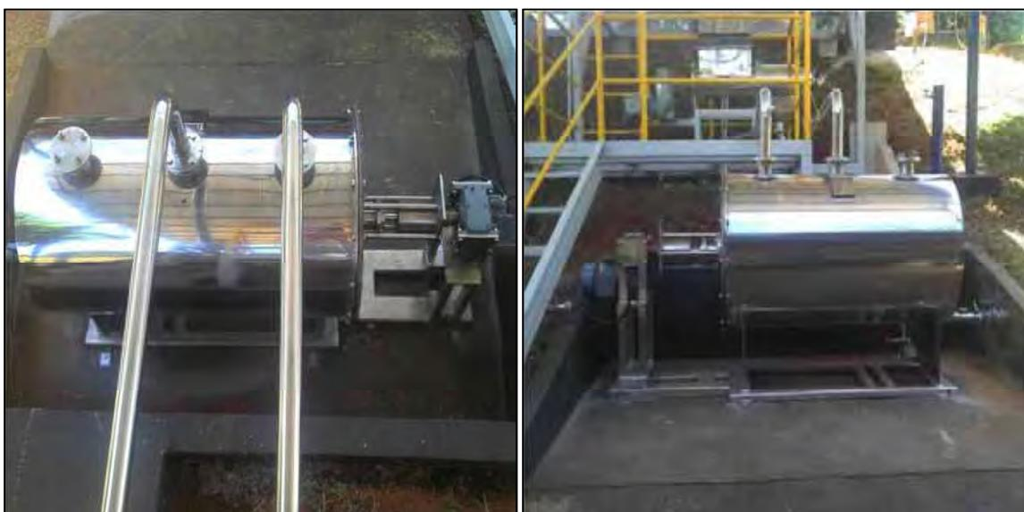
Apêndice 4. Tanque de homogeneização de fração líquida de CF, com capacidade de 400 litros e motor de 1 cv.
