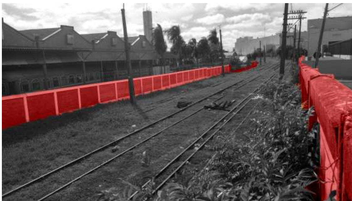
Figura 14 – Isolamento do leito férreo
