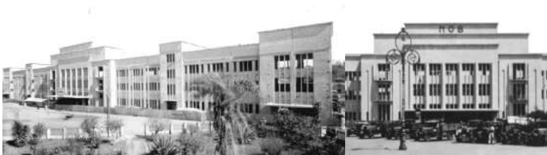
Figura 5 – Fotomontagem da Estação em construção (1935) e da construção finalizada (1939)
