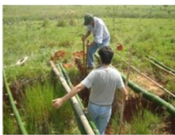
Figura 47. Corte na parede da erosão, utilizando enxadão e cavadeira. Fonte: Autores (março de 2012)
