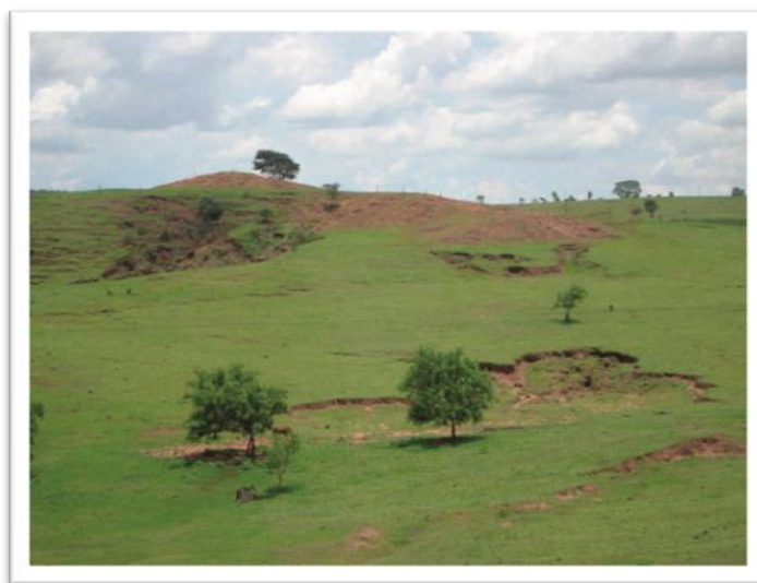
Figura 14. Erosões do tipo sulcos e ravinas nas vertentes da área do Assentamento Rural Nova Esperança destinada como Reserva Legal. Fonte: Autores (fevereiro de 2011)
