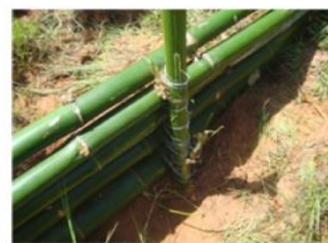
Figura 51. Amarração dos colmos de bambu, com uso de arame liso.
