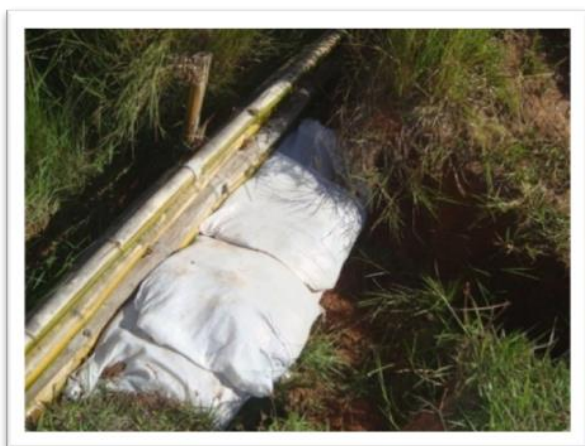
Figura 55. Disposição dos sacos de ráfia a montante da barreira de contenção na erosão 2. Fonte: Autores (março de 2012)
