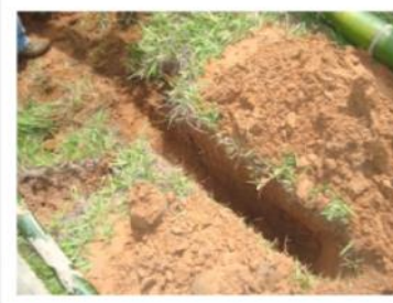
Figura 48. Detalhe do corte na parede da erosão, para encaixe dos colmos principais de bambu. Fonte: Autores (março de 2012)
