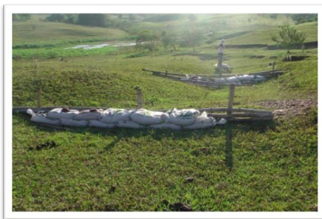
Figura 25. Barreiras feitas com sacos de ráfia (areia e seixos) apoiadas em bambu, a montante da erosão.
