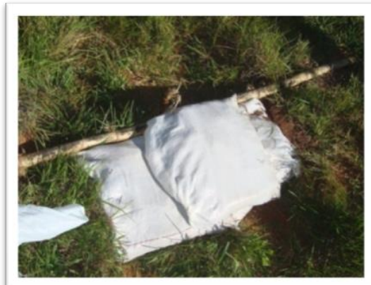
Figura 54. Disposição dos sacos de ráfia a montante da barreira de contenção na erosão 1. Fonte: Autores (março de 2012)
