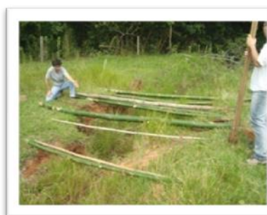
Figura 46. Corte de colmos de bambus conforme a largura do foco erosivo. Fonte: Autores (março de 2012)
