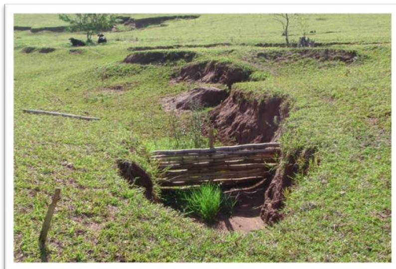
Figura 30. Barreira de bambu, com destaque para o crescimento dos brotos e o acúmulo de sedimento e gramíneas no interior da erosão (ravina B). Fonte: Autores (março de 2012)
