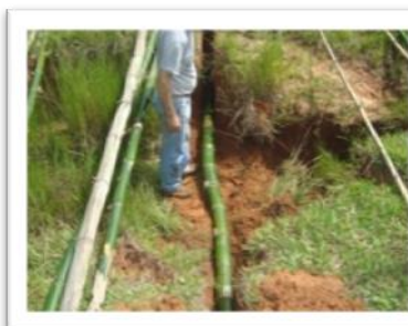
Figura 49. Encaixe dos colmos de bambu na parede da erosão.
