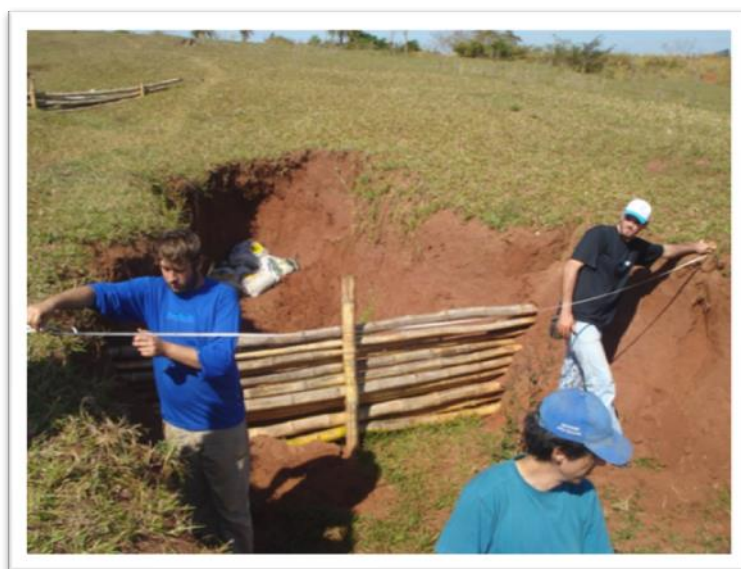
Figura 27. Monitoramento da ravina B. Fonte: Autores (abril de 2012)
