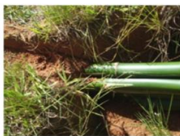
Figura 50. Detalhe do empilhamento dos colmos de bambus na parede da erosão.
