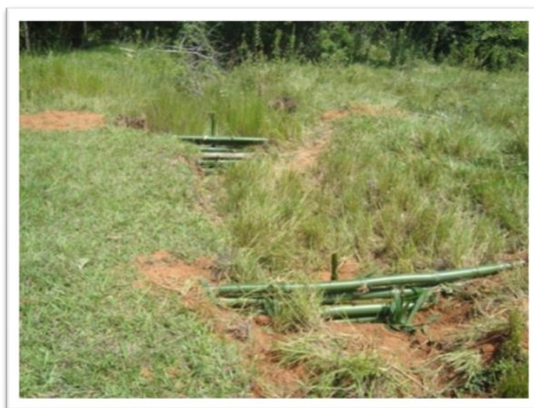
Figura 52. Detalhe final da montagem das barreiras de contenção a montante dos focos erosivos.
