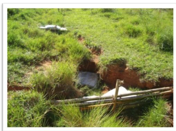
Figura 57. Vista da disposição final dos sacos de ráfia a montante das barreiras 1 e 2 e na cava erodida. Fonte: Autores (março de 2012)
