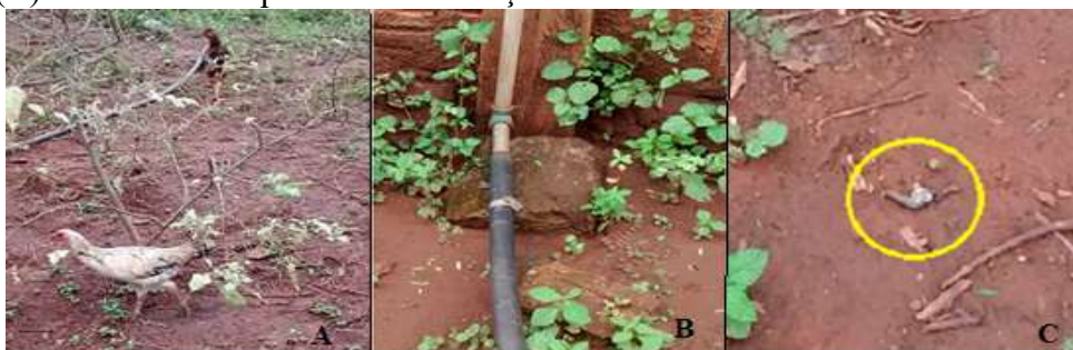
Figura 1- Trajeto água de poço-residência: (A) Aves transitando próximo a tubulação que faz a ligação entre poço-residência; (B) Tubulação que faz ligação entre poço à residência exposta ao solo; (C) fezes das aves próxima a tubulação.
