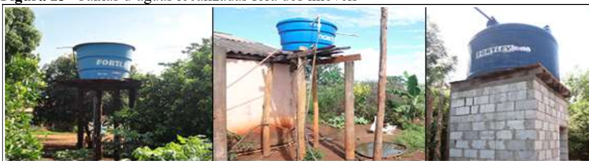
Figura 23- Caixas d'água localizadas fora dos imóveis
