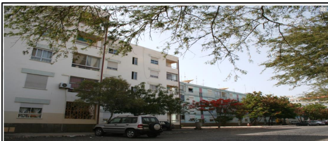
Figura 12: Conjunto Habitacional “Novo Horizonte” (1989-1991) / Praia/Santiago (Cabo Verde)
