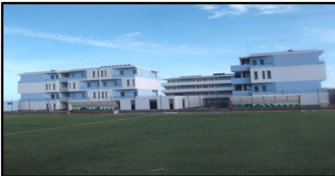
Figura 29: Estrutura física do empreendimento do Casa Para Todos em Ponta d'Água (Cabo Verde)
