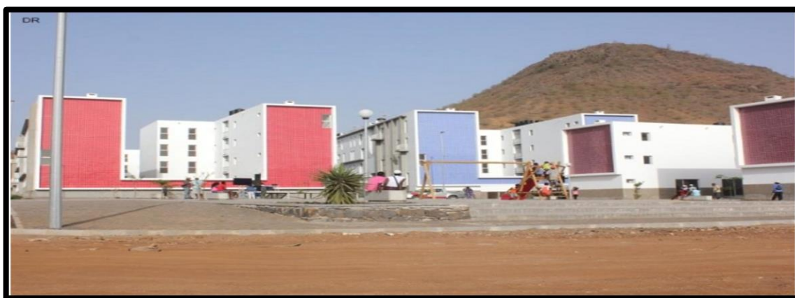
Figura 31: Estrutura física do empreendimento do Casa Para Todos em São Pedro Latada (Cabo Verde)
