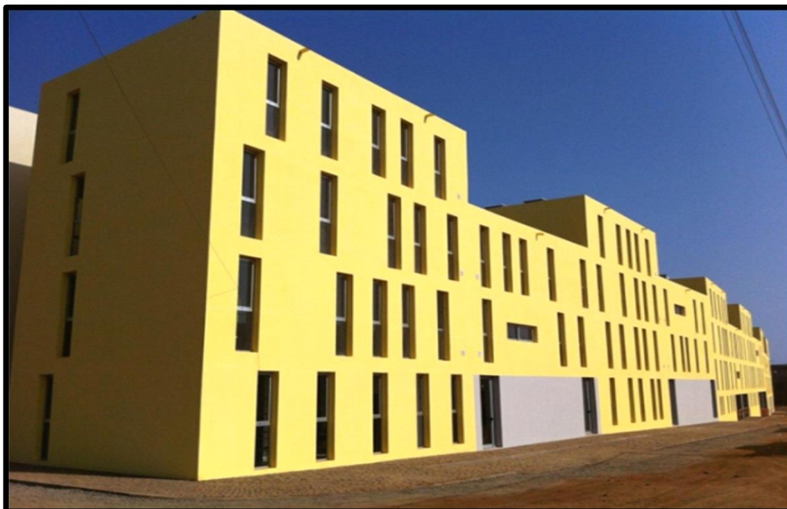
Figura 26: Estrutura física do empreendimento do Casa Para Todos em Achada Grande Trás (Cabo Verde)
