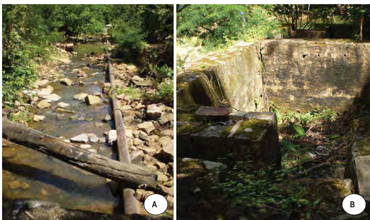
Figura 45 - Parque Ambiental Pirapora. A. Detalhe do sistema de canalização no Parque Ambiental Municipal Pirapora implantado na década de 60 para abastecimento público. B. Detalhe do banheiro público utilizado pela poluição na década de 60, hoje abandonado por ausências de políticas de preservação do patrimônio histórico.
