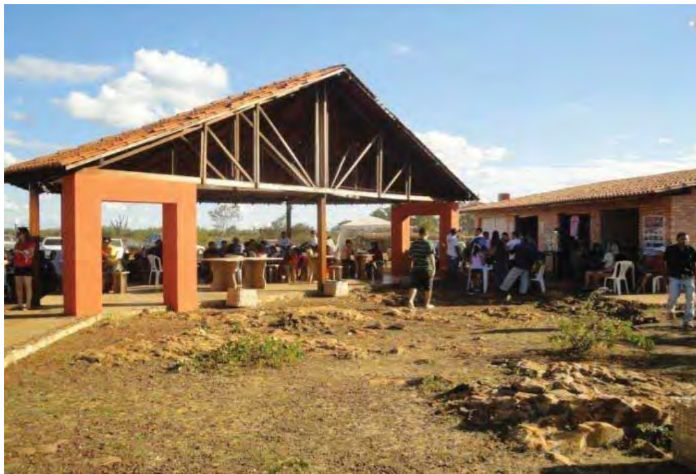
Figura 33 - Mirante do Gritador. Detalhe da estrutura de apoio aos turistas, dos quiosques de lojas e serviço de bar do Mirante, bem como lixeiras dispostas junto ao apoio.
